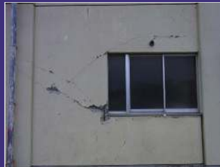
柱、壁のせん断破壊
