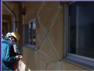
柱、壁のせん断破壊
