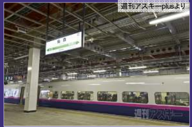
天井材撤去後の様子
