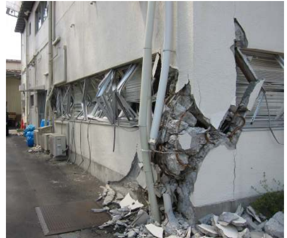
柱の軸崩壊
