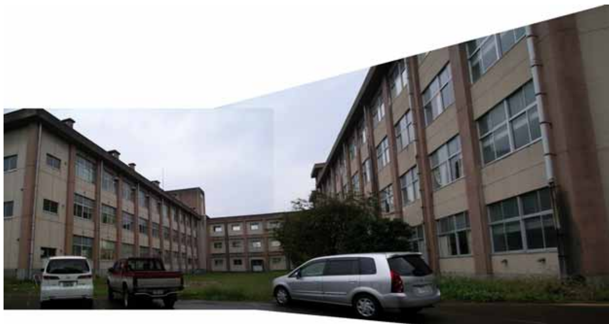
特別教室棟（左）と普通教室棟（右，第2校舎）
