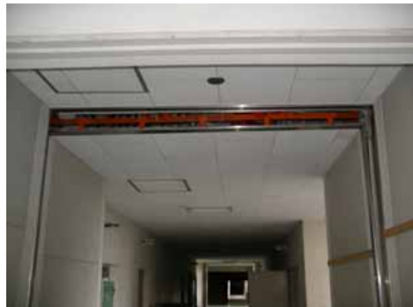
EXPJ 部分の鉛直方向のずれ
