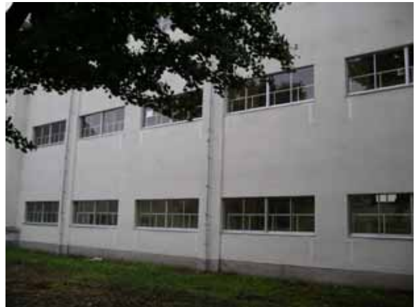
2号館（北側構面の壁柱には越し壁にスリット）
