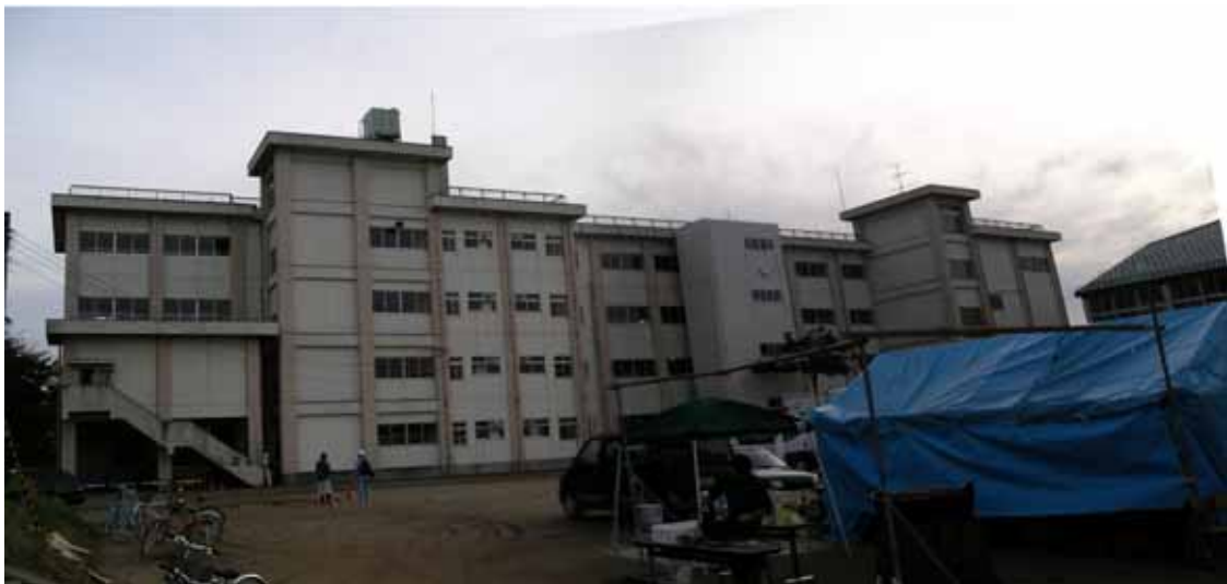
東小千谷中学校管理教室棟（左2スパン分が増設部分）
