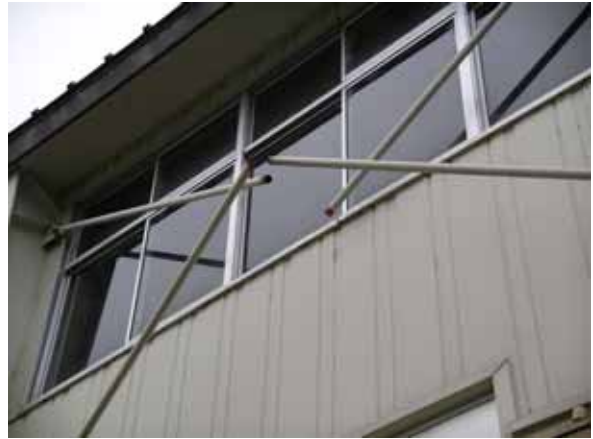
トレーニング場のブレース破断
