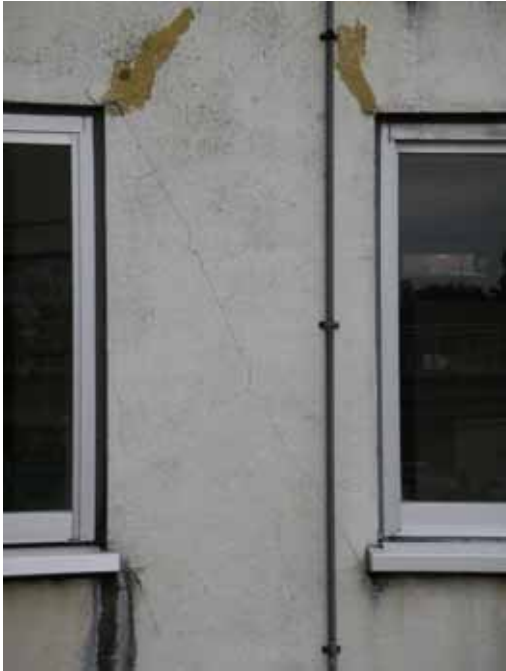
東側普通教室棟の柱のせん断ひび割れ (1mm 程度) 特別教室棟の煙突の被害
