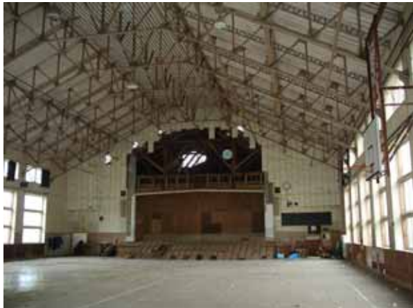
屋内運動場 (S1) (ステージ上の仕上げ材の大規模な落下)
