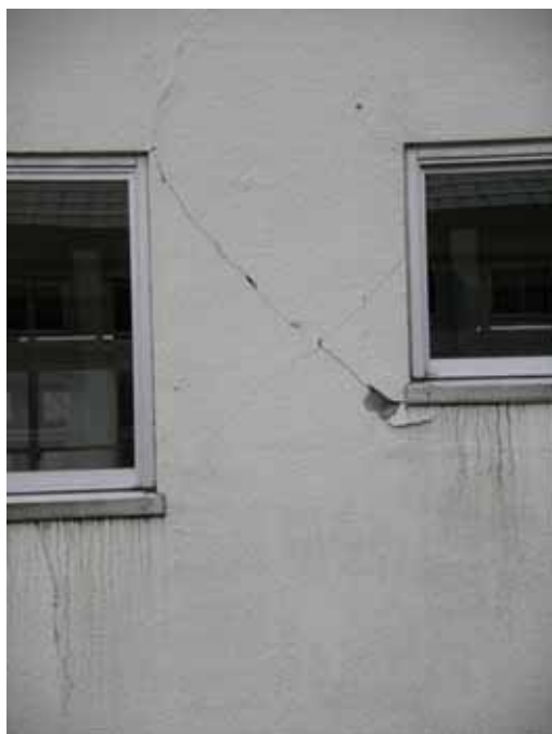
管理教室棟1階柱のせん断ひび割れ（外観および内観）（ひび割れ幅2mm程度）
