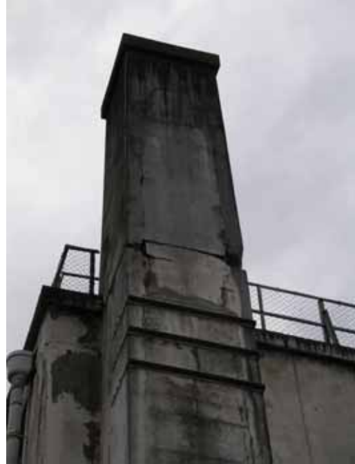
東側普通教室棟の柱のせん断ひび割れ (1mm 程度) 特別教室棟の煙突の被害
