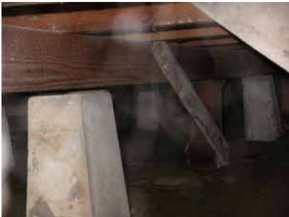
保健室床下の束と土台の隙間（床が緩む）
