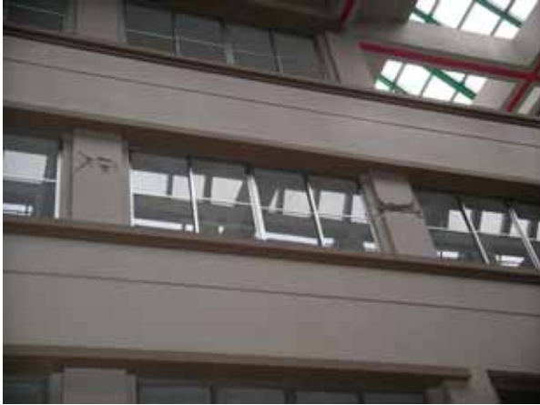
ポーチ上部の3階柱の被害（左：アトリウムから / 右：正面から）
