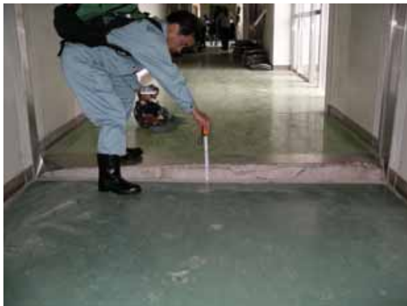
EXPJ 部分の鉛直方向のずれ
