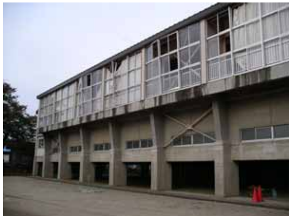
屋内運動場（窓ガラスの被害とブレースの座屈）
