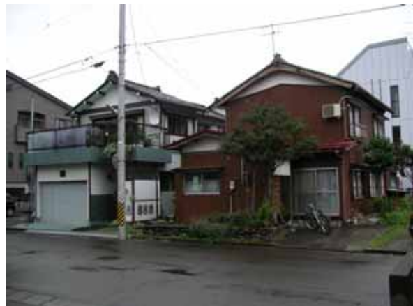
周辺の民家に被害は見られない
