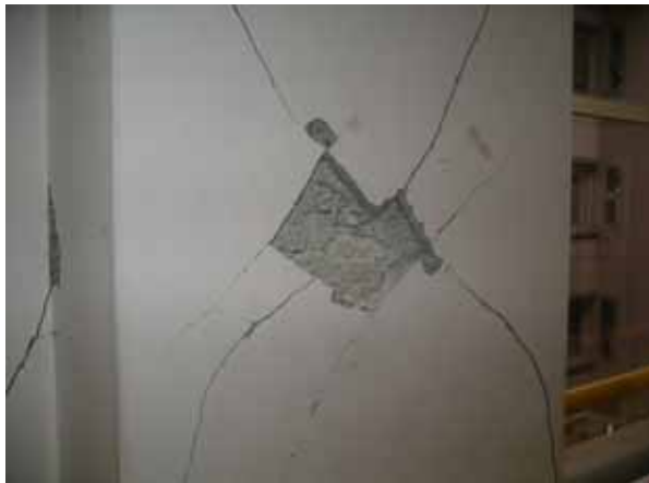
向かって左側柱の仕上げモルタルはつきり後
