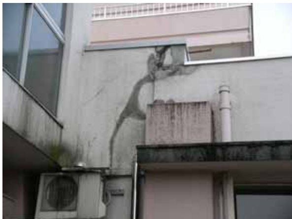
壁の沈下によると思われる隙間 屋内運動場～管理特別教室棟（昇降口）の被害
