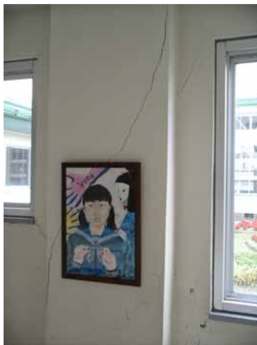
管理教室棟1階柱のせん断ひび割れ（外観および内観）（ひび割れ幅2mm程度）
