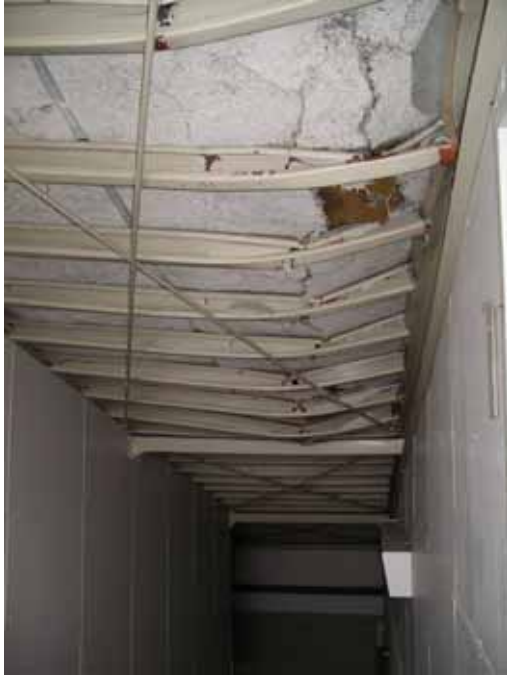
崩落した CB はトレーニング場階段室屋根を直撃 大体育館の内部
