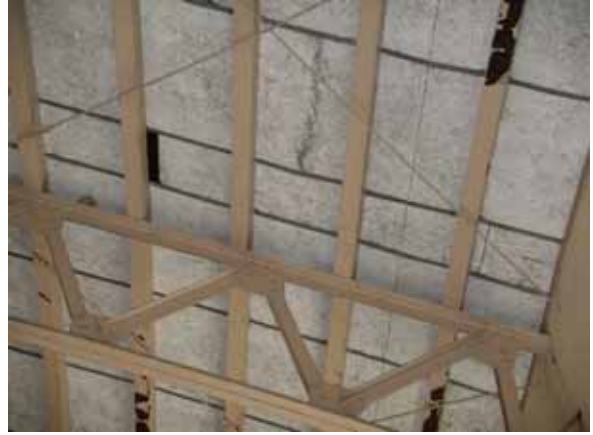
屋内運動場内部と天井材のずれ
