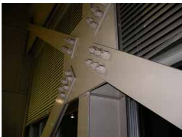
間柱に溶接され振れ止め処理されたブレース
