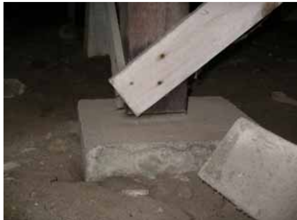
保健室床下の束と土台の隙間（床が緩む）
