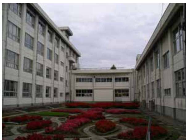
管理・普通教室棟～特別教室棟の中庭（腰壁～柱間にはスリットが設けられている）
