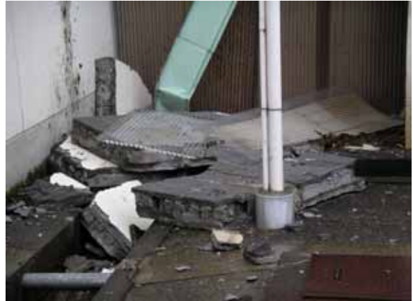
トレーニング場側壁（CB）の崩落
