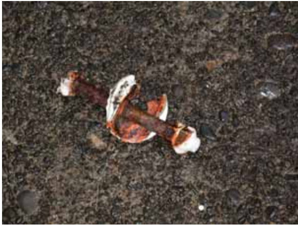
ブレース交差部のボルト
