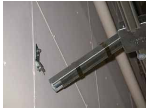
機械実習棟の照明器具による内装壁面の損傷
