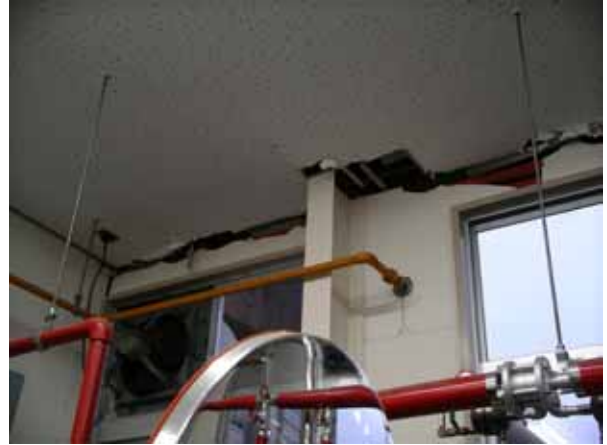
機械実習棟 外観と天井の被害
