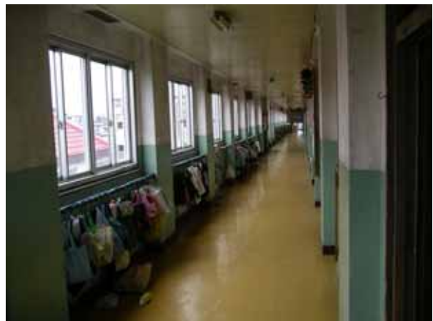
西側教室棟内部 (無被害: 3 スパン / 1 教室)
