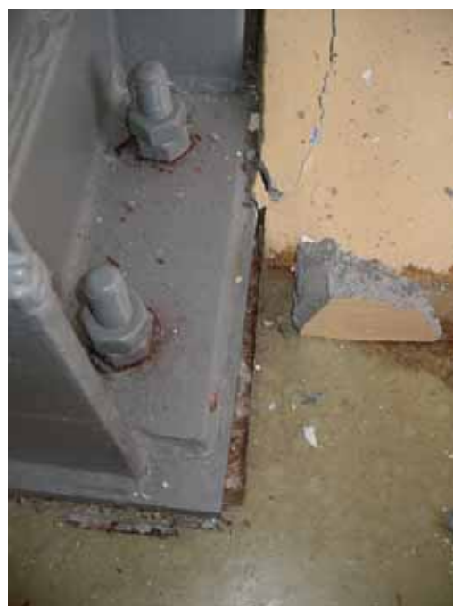
柱脚部分のベースプレートのずれ
