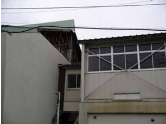
トレーニング場側壁（CB）の崩落
