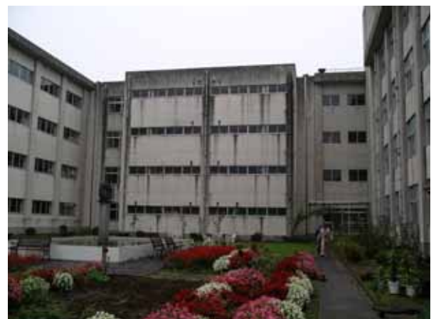
特別教室棟～管理普通教室棟間の渡り廊下棟
