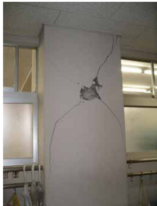
2年1組教室側柱 (モルタルはつきり後)
