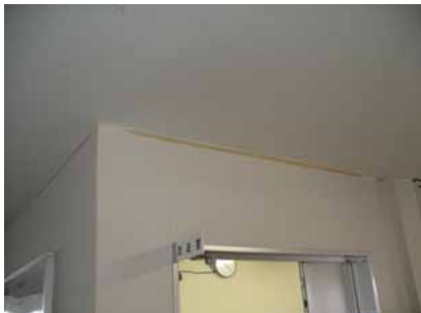
壁の沈下によると思われる隙間 屋内運動場～管理特別教室棟（昇降口）の被害
