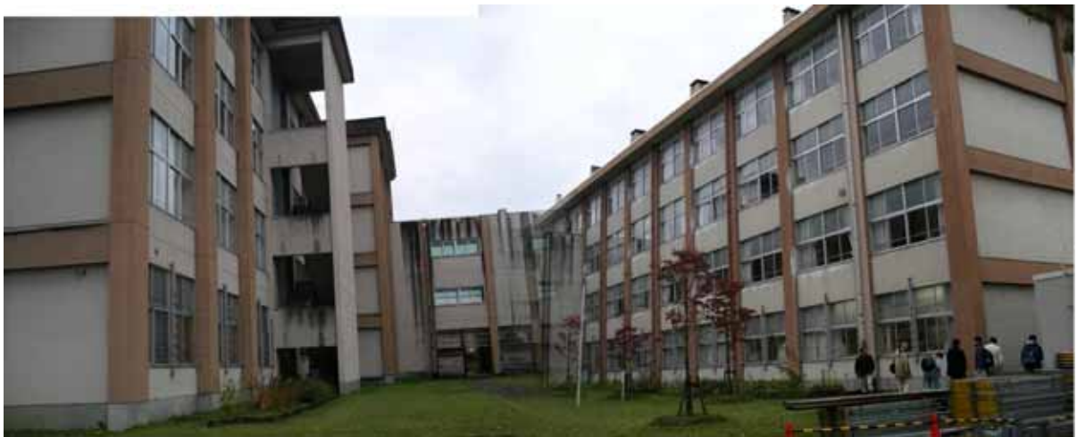
特別教室棟～普通教室棟
