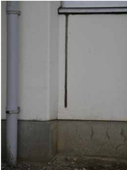
管理・普通教室棟の腰壁のスリット（外観および内観）
