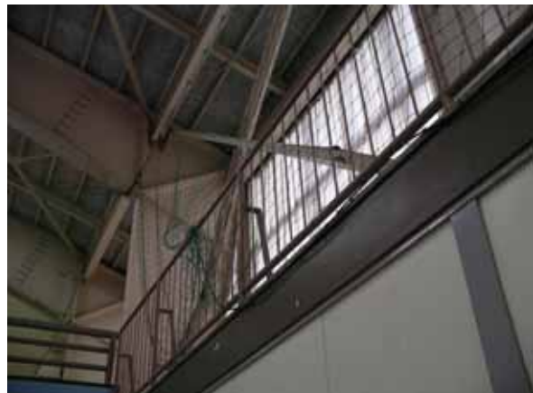
屋内運動場（窓ガラスの被害とブレースの座屈）
