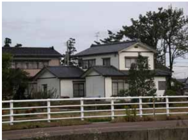
学校周辺には瓦屋根の住宅が見られるが、外壁の目地ずれ程度で大きな被害はない
