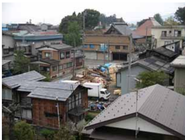
周辺の被害状況
