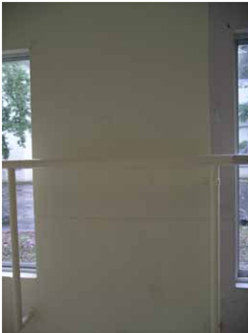
右側腰壁にはスリットなし
