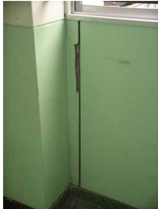
管理・普通教室棟の腰壁のスリット（外観および内観）
