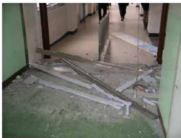
写真 4-4 EXP.J の被害
