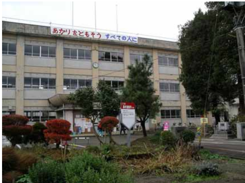
写真 3-2 管理教室棟（北校舎）北側構面
