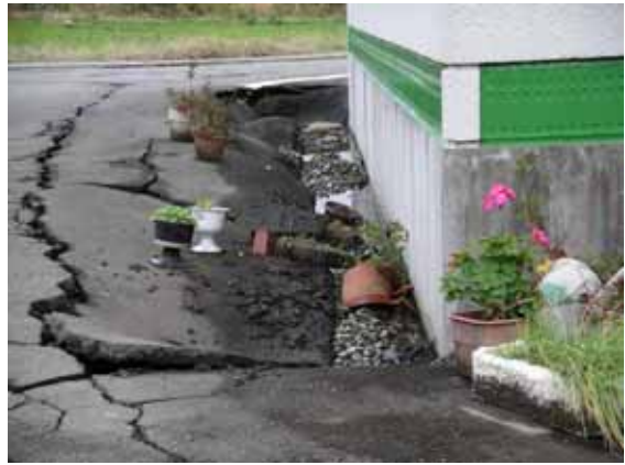
周辺地盤の沈下が著しいが構造被害は無い
