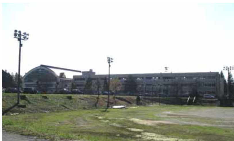
写真 11-1 小国中学校全景（左：体育館，右：北校舎）
