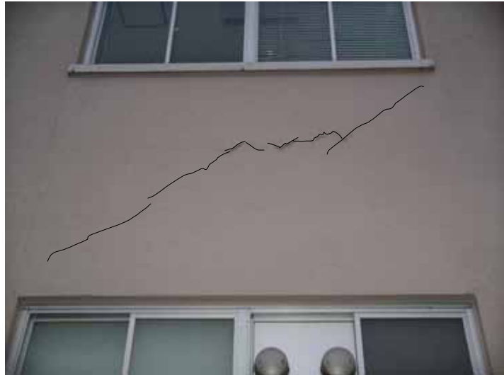
隣接する補強構面間の梁にせん断ひび割れ ひび割れ状況を加筆により強調表示 写真 9-2 4号館
