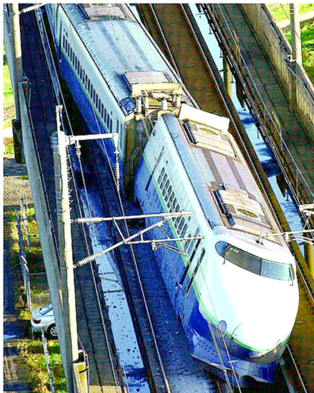
写真2：脱線した上越新幹線「とき325号」(毎日新聞号外 10月24日)
