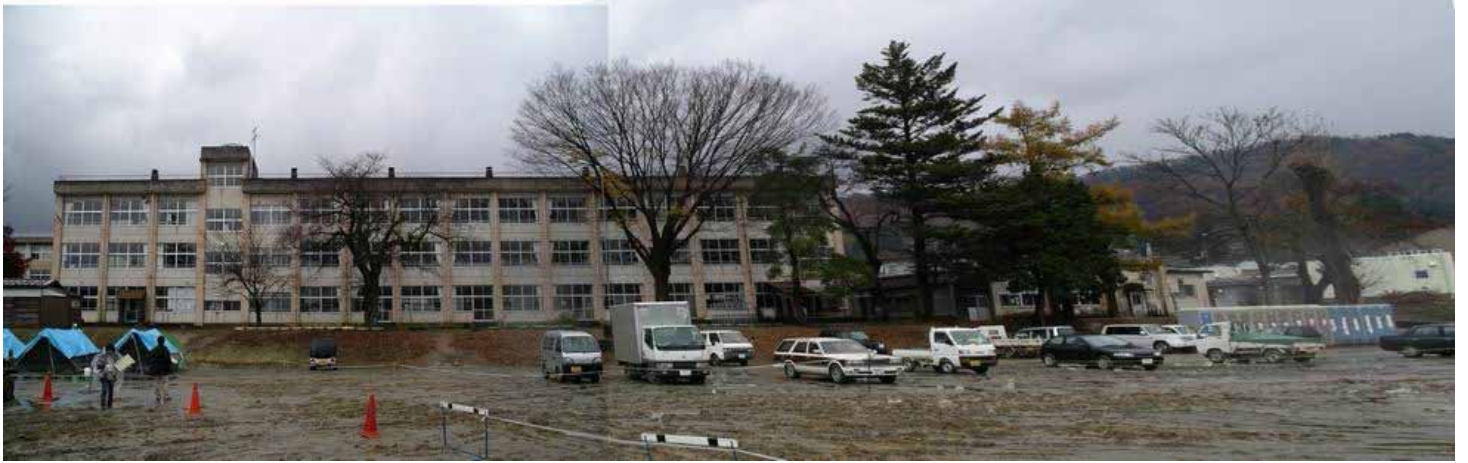
教室棟（南校舎）
