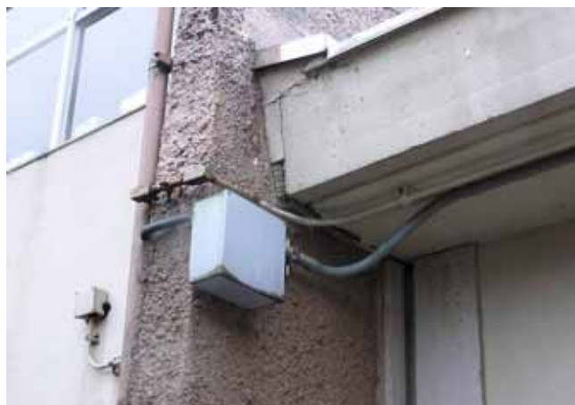
写真 1 3 EXP.J の被害
