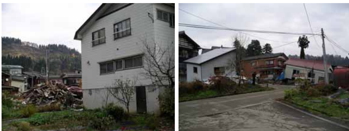
写真 8-1 田麦山地区の被害
