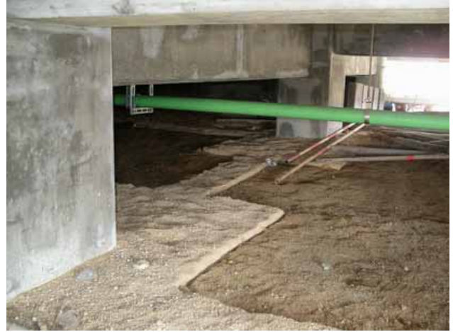
基礎梁が露出 / 躯体に被害は見られない
