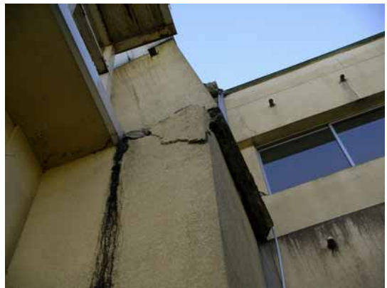
写真 11-11 南側校舎と渡り廊下の EXP.J の被害
