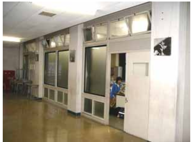
3階（調理室直上）は長柱
