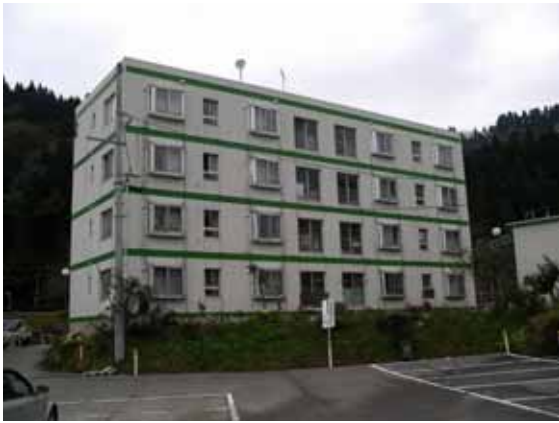
周辺地盤の沈下が著しいが構造被害は無い
