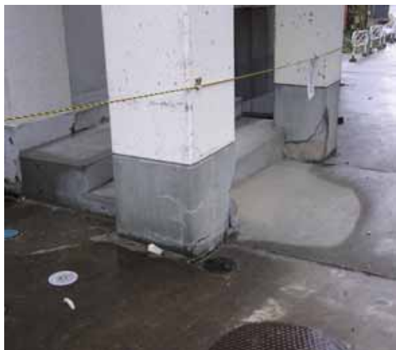
写真 4-5 柱脚部被害
