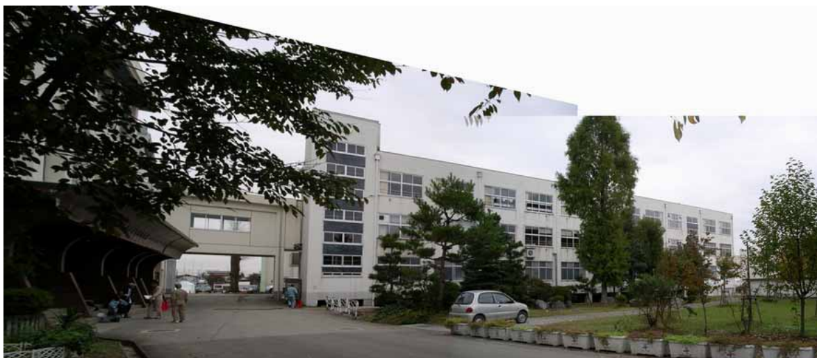
写真 4-1 小千谷中学校 全景
