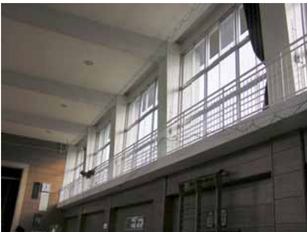
写真 6-6 屋根梁は PS、柱は RC
