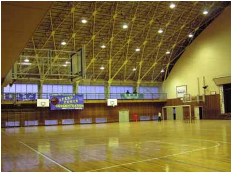
写真 2-5 屋内運動場内観
