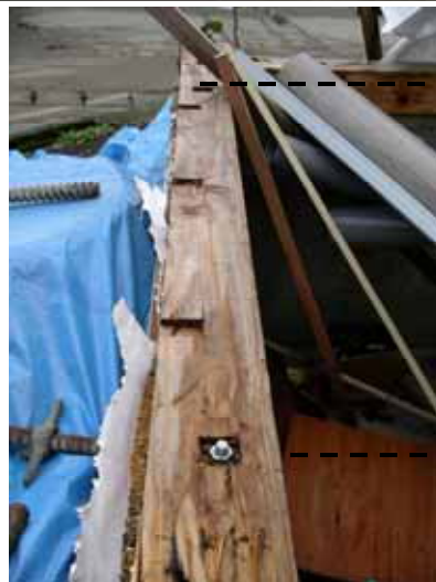
写真 8-4 RC 造基礎上の土台のボルト
