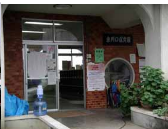
（被害なし：外観調査）
