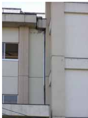
写真 12-2 EXP.J の被害
