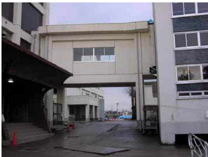
管理・普通教室棟 管理教室棟
