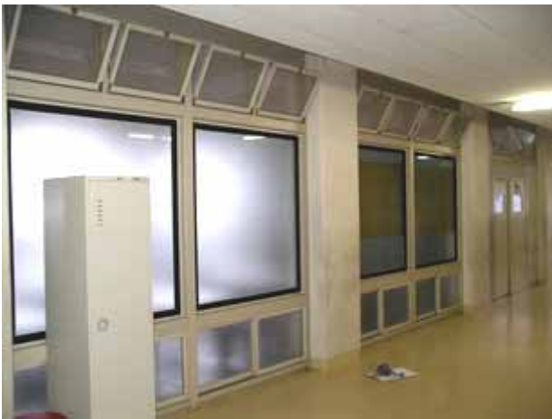
向かいの被服室はガラス面で長柱
