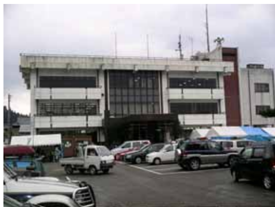
（被害なし：外観調査）
