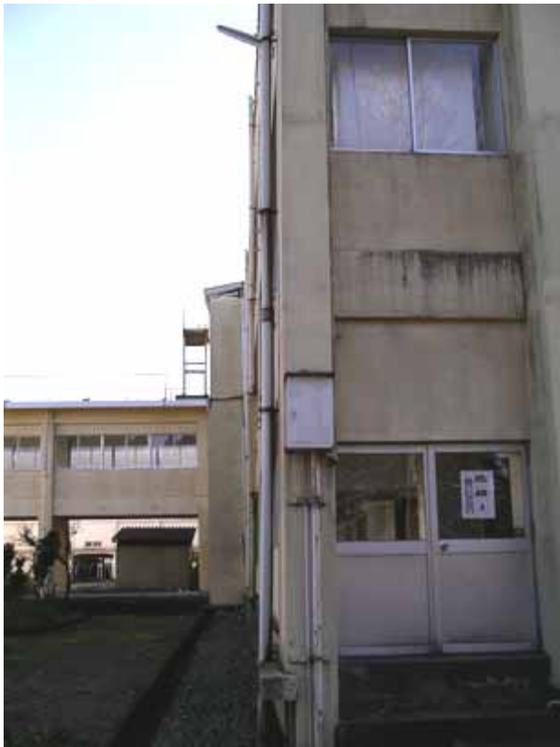
写真 11-5 校舎の傾斜
