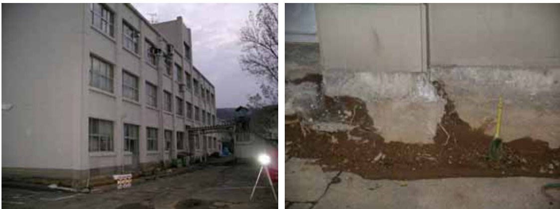
写真 9-5 3号館の露出した基礎梁
