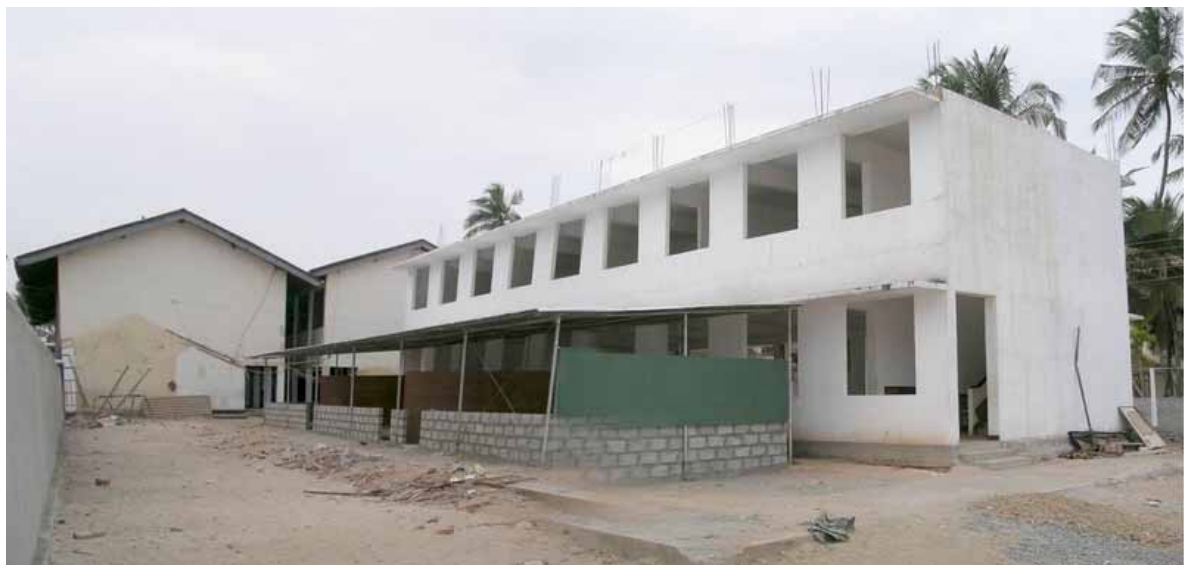
写真 4.20-2 : RC 造 2 階建て校舎（西立面）
