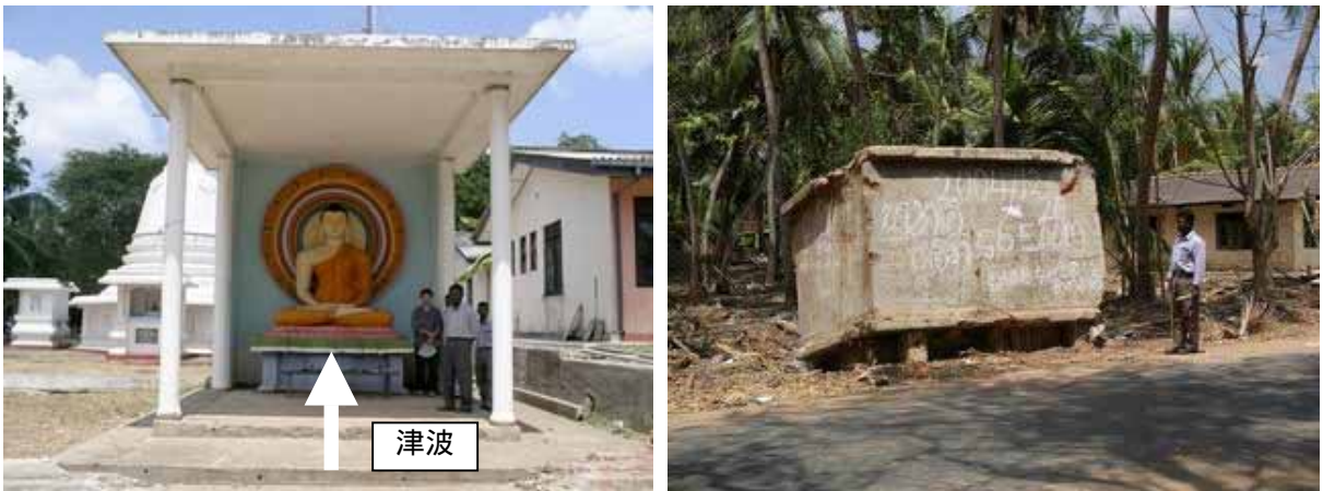
写真 4.17-5 : 仏廟 全景(左)と倒壊・漂流した水槽
