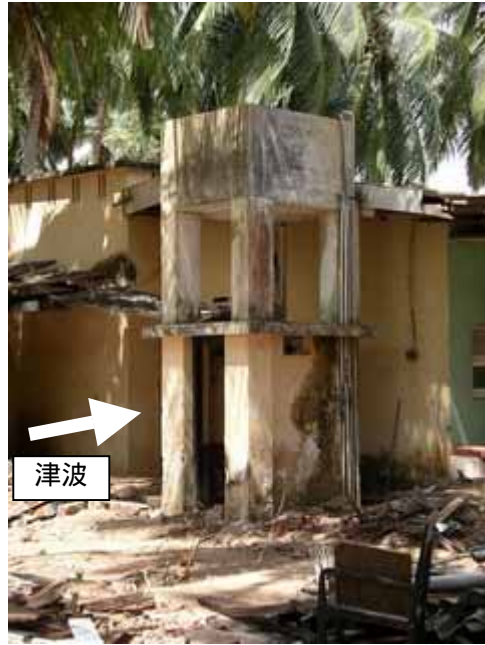
写真 4.16-8：道路脇の高架水槽
