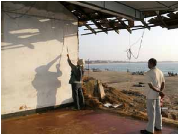
写真 4.14-3：建物内での津波計測（2.95m）
