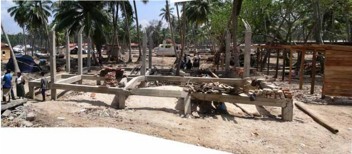
写真 4.23-3：建設途中の RC 造建物
