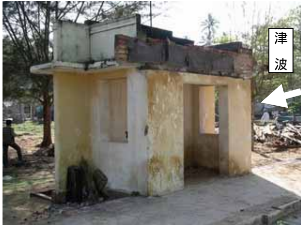
写真 4.9-2：屋外小屋（被害は見られない）
