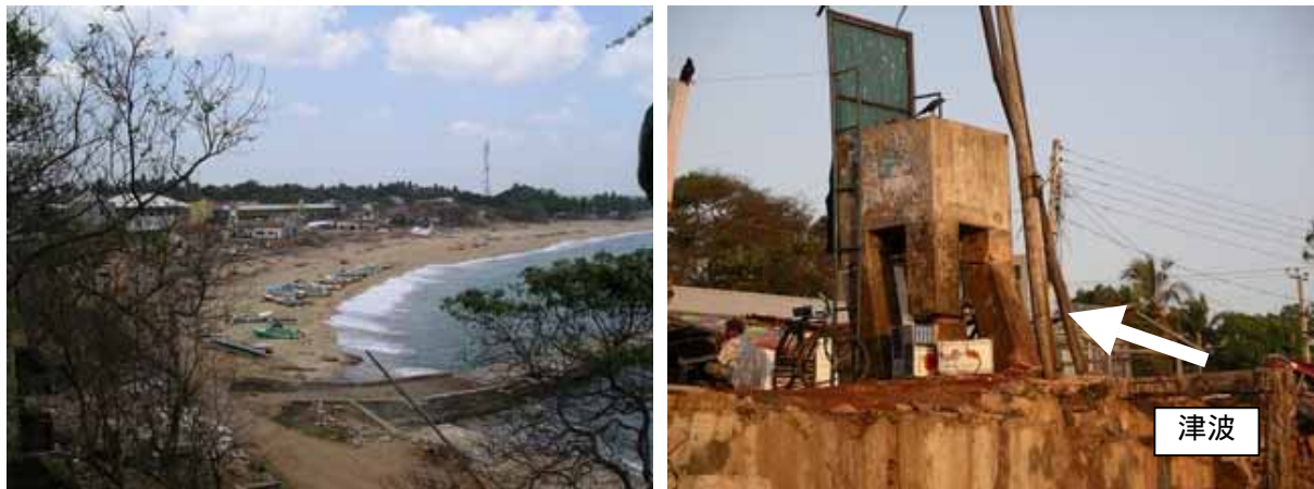
写真 4.14-1 : Hambantota の海岸と大破した高架水槽
