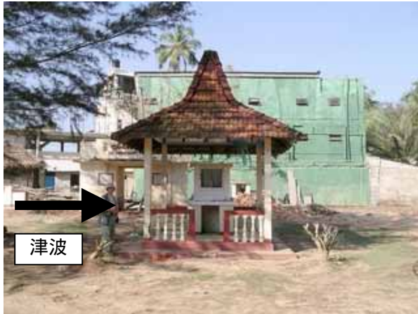
写真 4.11-1 : 仏廟 （被害は見られない）
