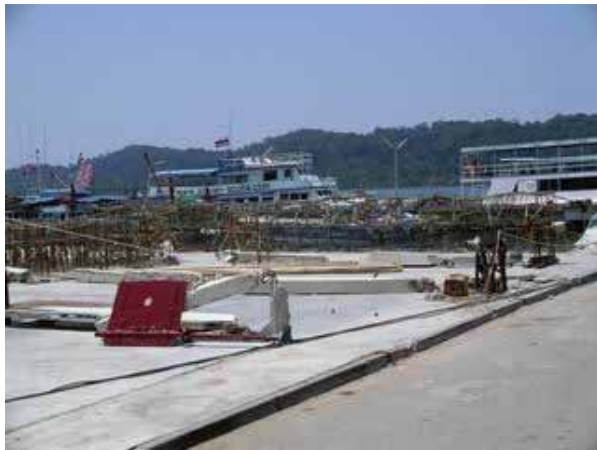
写真 5.6-1：海軍基地近くの栈橋での倒壊柱
