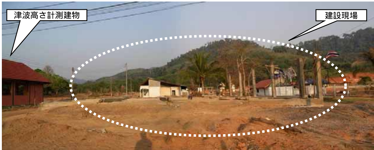
写真 5.9-1：建設現場全景
