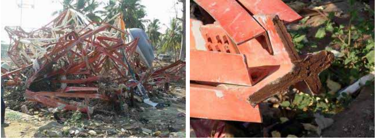
写真 4.17-4 : 大破した鉄塔とすみ肉溶接部で破断したその柱脚部
