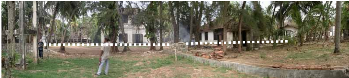
写真 4.19-5 : 崩壊した石造隣地境界塀
