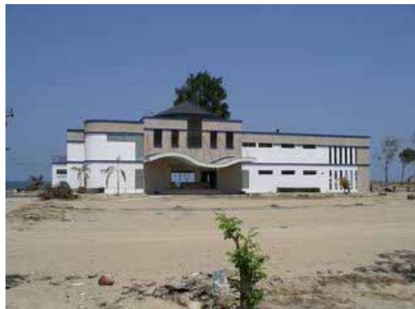
写真 5.5-5：クラブハウス（構造被害は無い）
