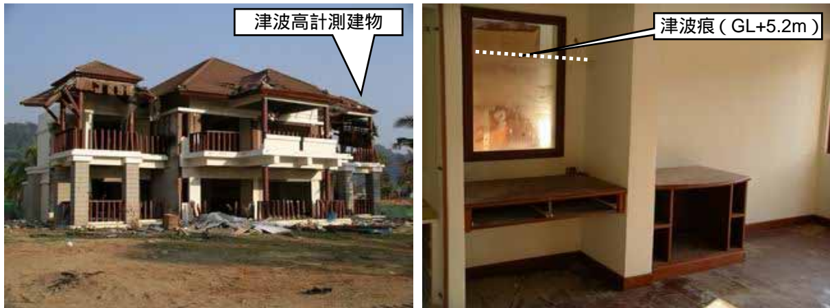
写真 5.8-3 : やや内陸側の建物と 2 階の鏡に残る津波痕 (GL+5.2m)
