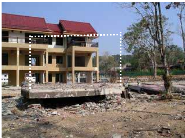
写真 5.7-7：建物群 の倒壊した平屋コテージ（左）と残存したコテージ（右）
