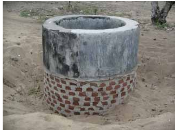
写真 4.2-4: 一般的な井戸 (洗掘が著しい)
