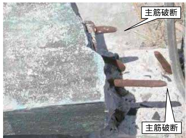
写真 5.6-3：主筋破断を伴う柱の破壊
