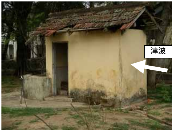
写真 4.19-3 : 調査した小屋 とその近くの建物での津波高さ実測 (GL+2.05m)
