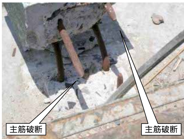
写真 5.6-3：主筋破断を伴う柱の破壊
