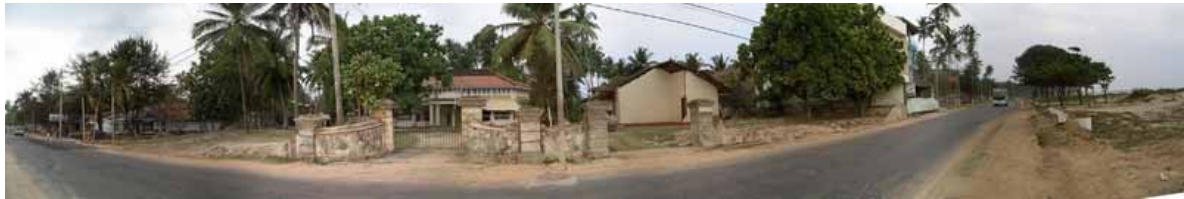
写真 4.19-1 : 海岸通りから調査地域を望む (中央が High Court Judges Residence)
