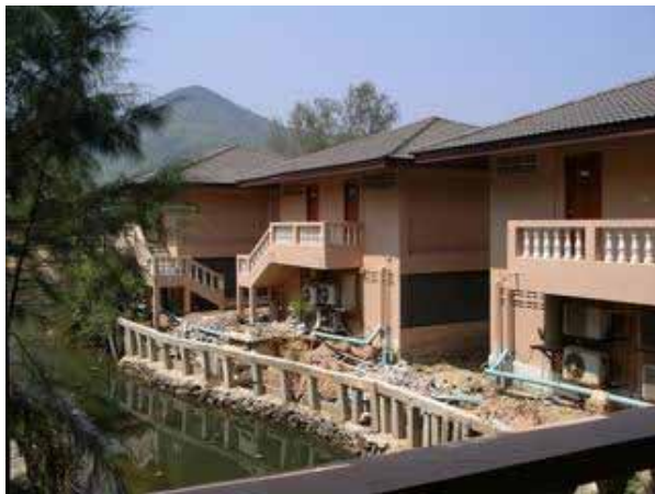
写真 5.2-5：詳細調査建物の背面
