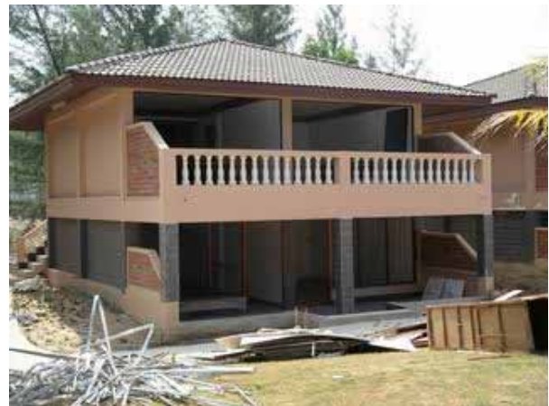
写真 5.2-3：詳細調査を行った建物
