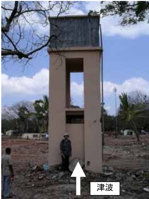
写真 4.17-1：水運河口付近の高架水槽
