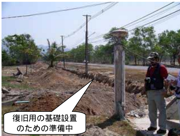
写真 5.5-4：正面ゲート横の被害の様子
