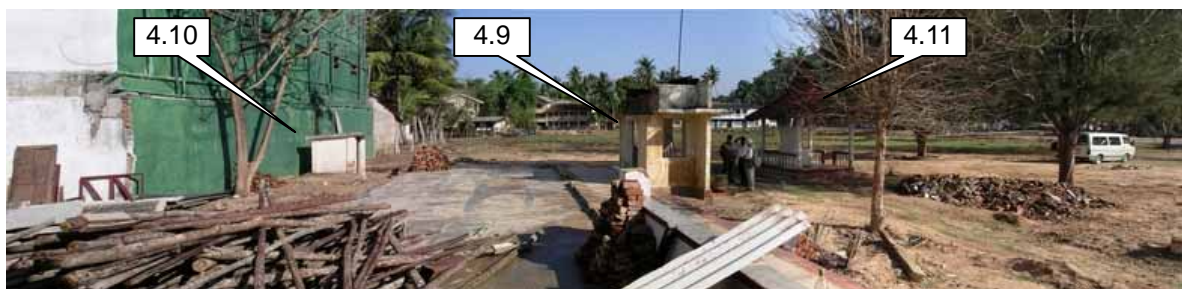
写真 4.9-1：「4.8 レンガ造の学校教室」裏側の全景
