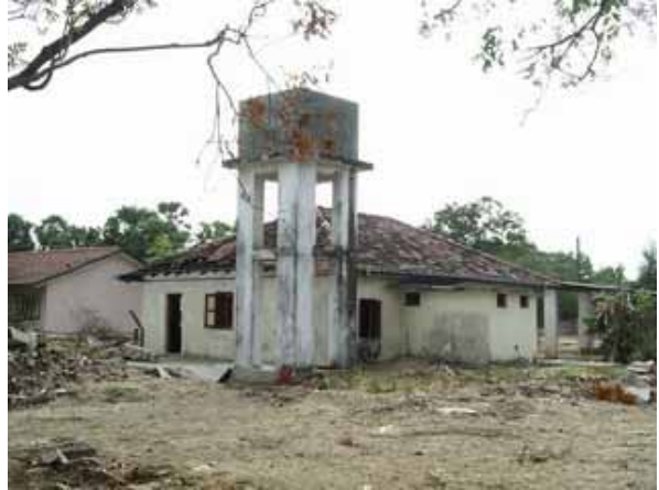
写真 4.1-5：高架水槽（無被害）
