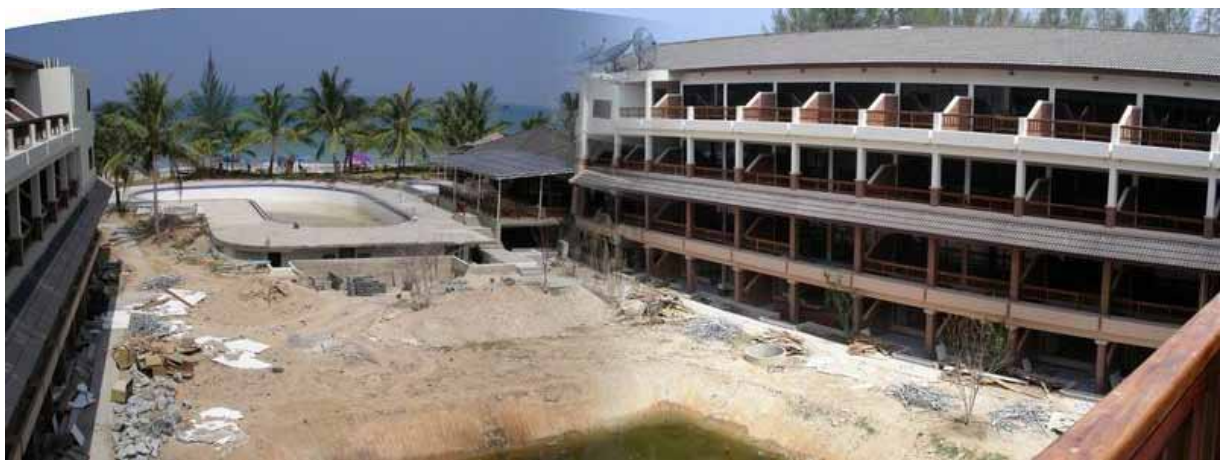
写真 5.2-1：ビデオに記録されたプール周辺を望む
