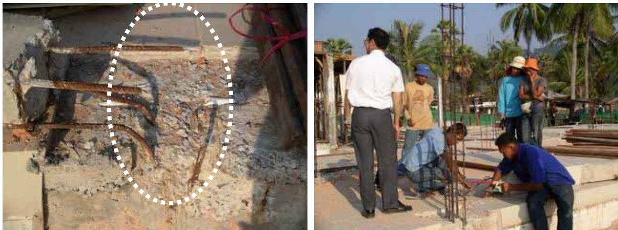
写真 5.8-2：主筋の破断を伴い曲げ破壊した柱と既存柱からの主筋サンプルの採取の様子
