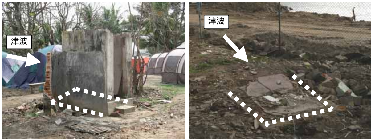
写真 4.7-5 : 津波の来襲方向と開口方向により被害程度の異なる屋外トイレ （左：屋外トイレ / 右：屋外トイレ）
