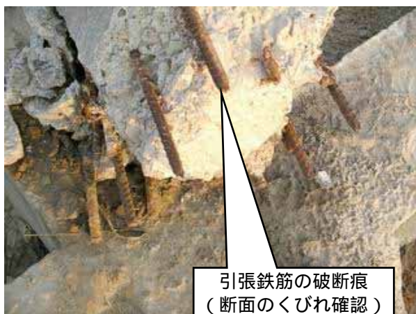
写真 5.9-4 : 倒壊した柱の破壊面 (左: 破断痕 / 右: 溶断痕)
