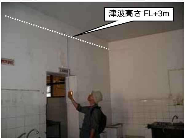
写真 4.16-4：砂丘を越流した津波による被害（基礎の洗掘と厨房での津波高さ計測）
