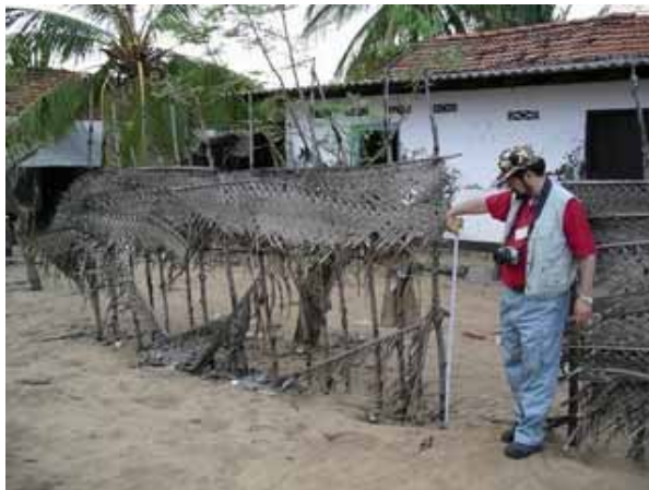
写真 4.2-3: 津波高さの計測 ( GL+0.9\text{m} 程度)
