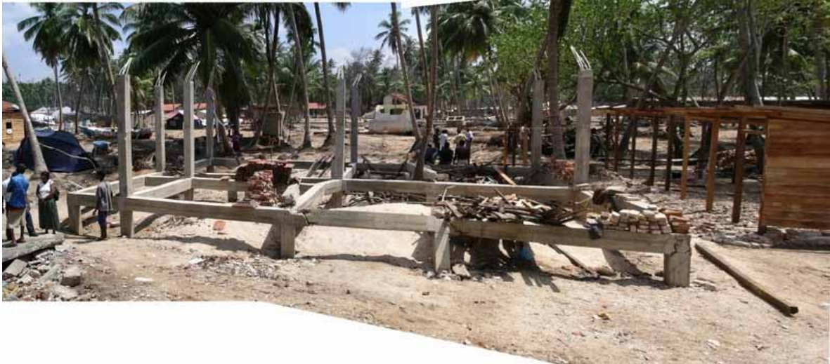
写真 4.23-3：建設途中の RC 造建物
