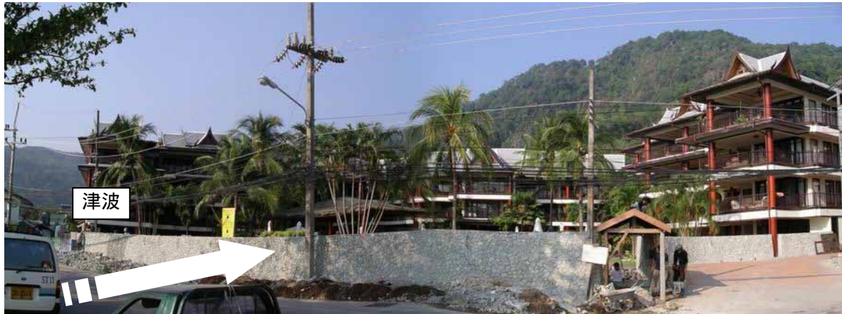
写真 5.4-1：Residence Kalim Bay ホテル全景
