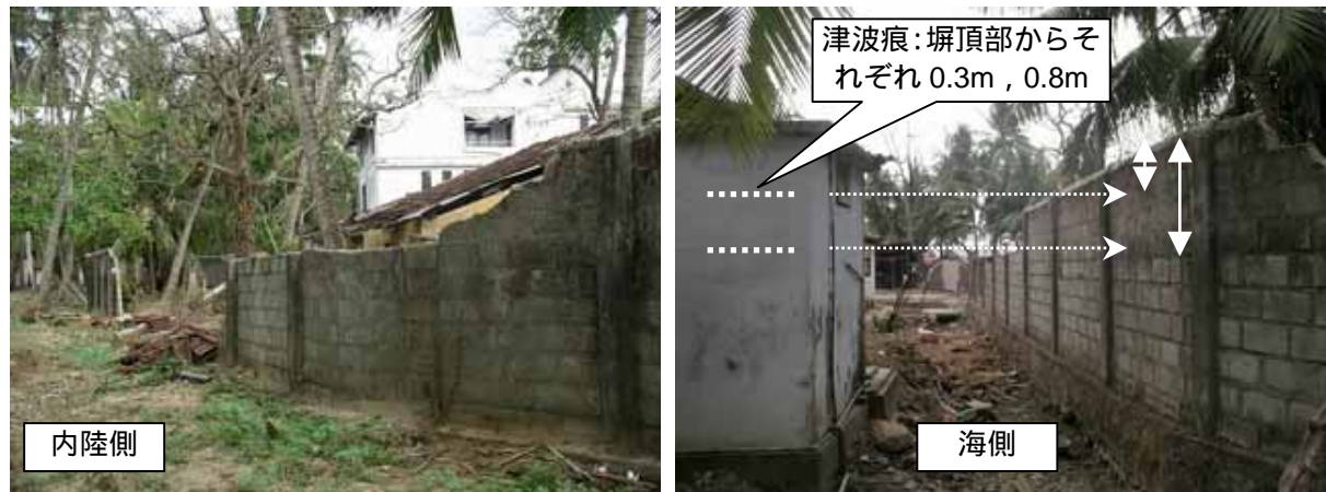
写真 4.7-2：ブロックの被害の詳細（上3段のみが破壊している箇所も見られる）
