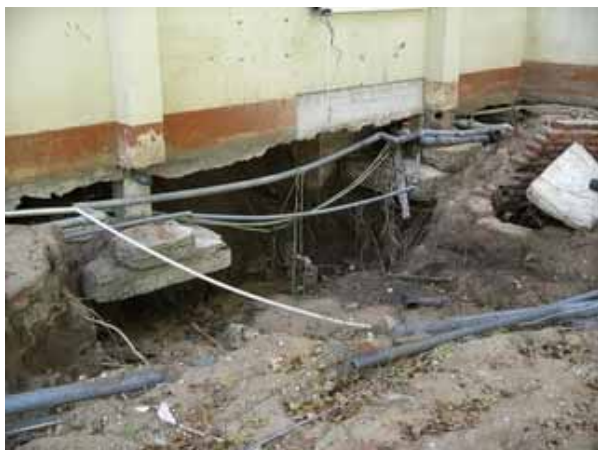
写真 4.16-4：砂丘を越流した津波による被害（基礎の洗掘と厨房での津波高さ計測）
