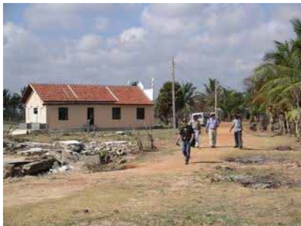
写真 4.3-2 : 津波で屋根が被害を受けたイスラム教会
