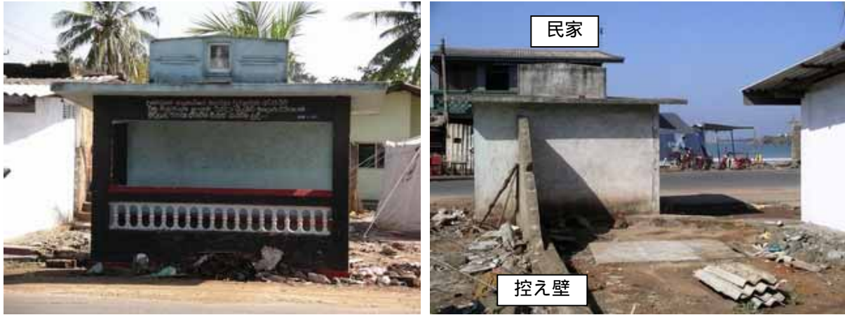
写真 4.12-1 : バス停 （海側には民家が建つ）
