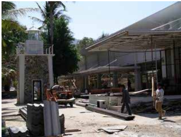
写真 5.1-2 : Wine Cellar の外観
