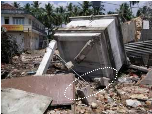
写真 4.5-2：折損した柱の断面（重ね継手にはフックは設けられていない）
