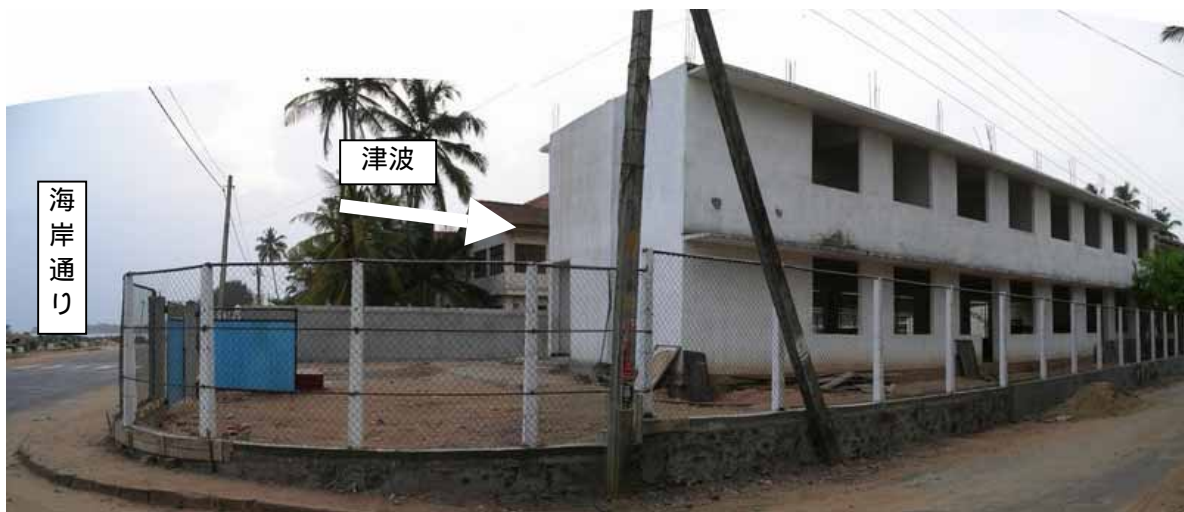
写真 4.20-1 : RC 造 2 階建て校舎（東立面）
