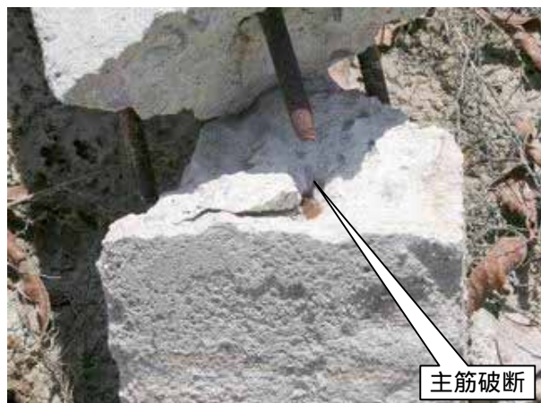
写真 5.5-6：主筋の破断を伴う RC 造フェンス柱の転倒
