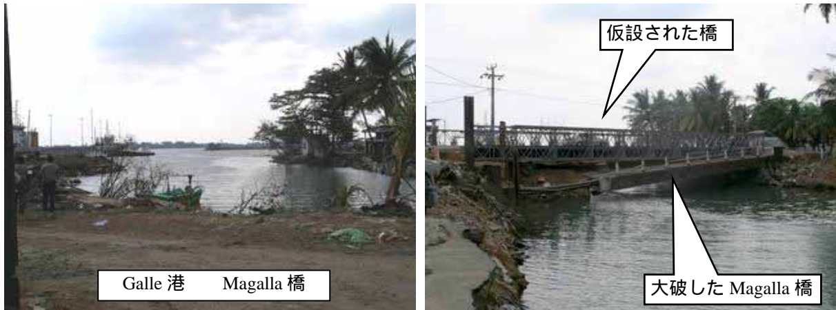
写真 4.7-4 : Galle 港と被害を受けた Magalla 橋
