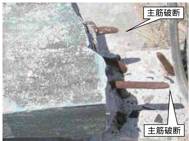
写真 5.6-3: 主筋破断を伴う柱の破壊
