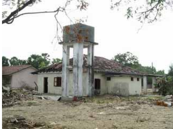
写真 4.1-5：高架水槽（無被害）
