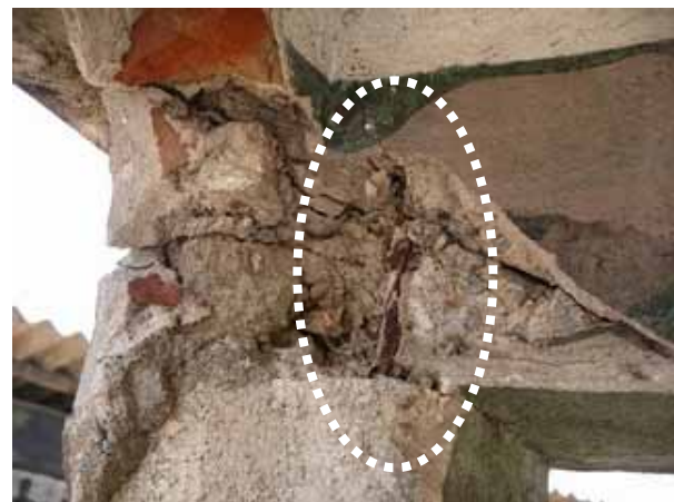
写真 4.13-3 : RC 造柱における鉄筋の露出
