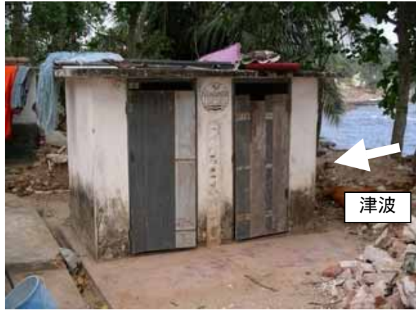
写真 4.18-2：レンガ造の屋外トイレ（無被害）
