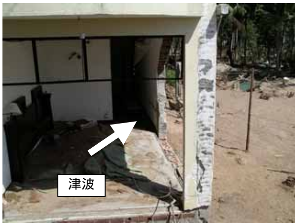
写真 4.16-3：津波により崩壊した東側妻面のレンガ壁（右壁中央には内圧によるひび割れ）
