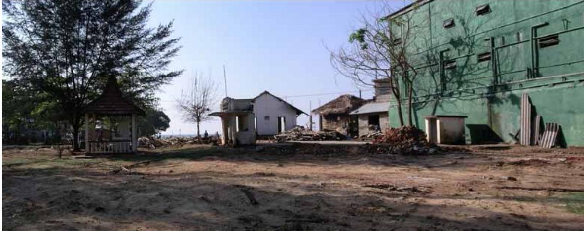
写真 4.8-2：調査建物（中央）を含む内陸側からの周辺の様子
