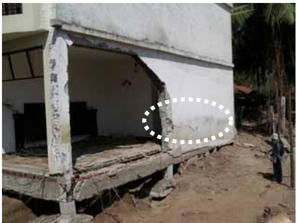
写真 4.16-3：津波により崩壊した東側妻面のレンガ壁（右壁中央には内圧によるひび割れ）
