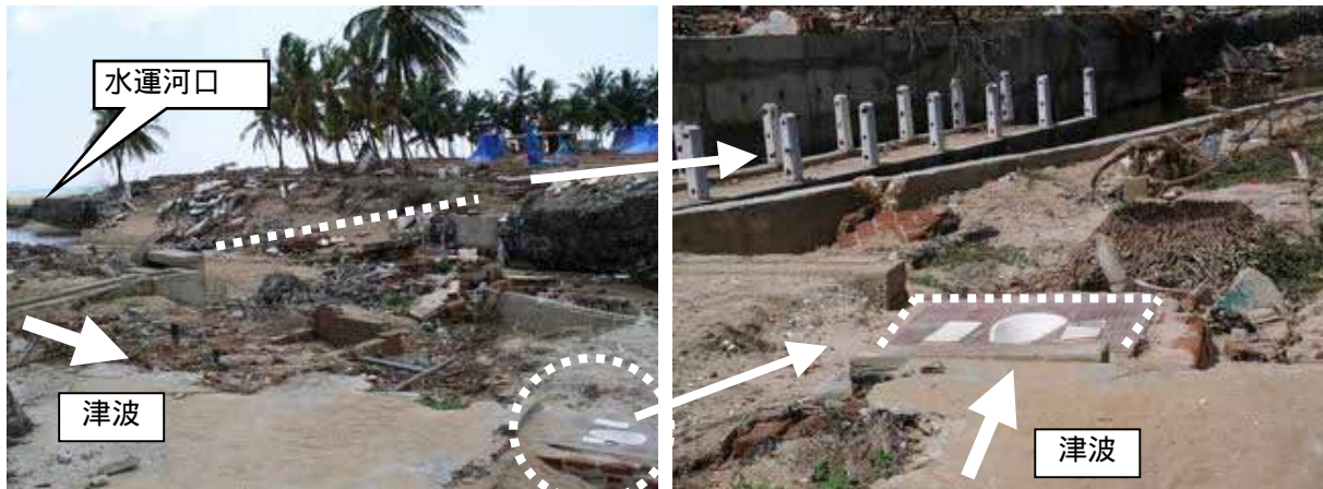
写真 4.17-3：崩壊・流失した橋（左上）と崩壊した屋外トイレ
