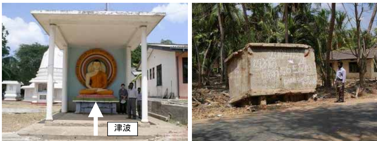
写真 4.17-5 : 仏廟 全景(左)と倒壊・漂流した水槽
