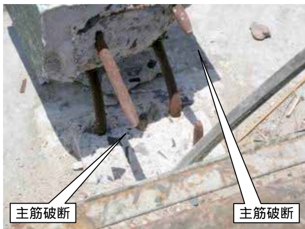
写真 5.6-3: 主筋破断を伴う柱の破壊
