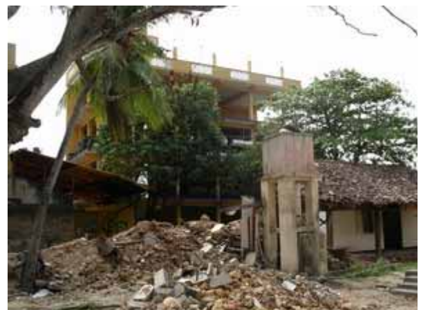
写真 4.5-4：隣接敷地内の高架水槽は被害無し
