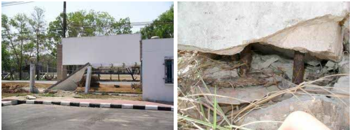
写真 5.5-2：正面ゲートのブロック塀の被害とその柱脚部（丸鋼主筋の抜け出し）
