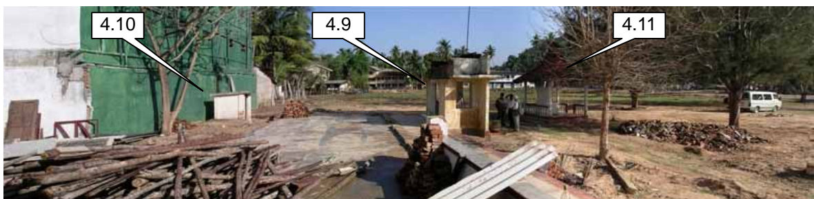
写真 4.9-1：「4.8 レンガ造の学校教室」裏側の全景
