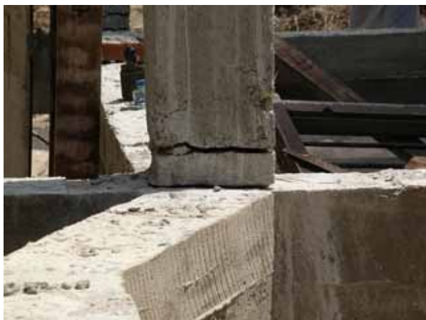
写真5：転倒していない柱でも大きな曲げひび割れ，露出主筋の湾曲が見られる
