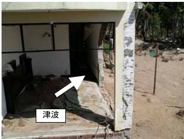
写真 3：津波により崩壊した東側妻面のレンガ壁(右壁中央には内圧によるひび割れ)
