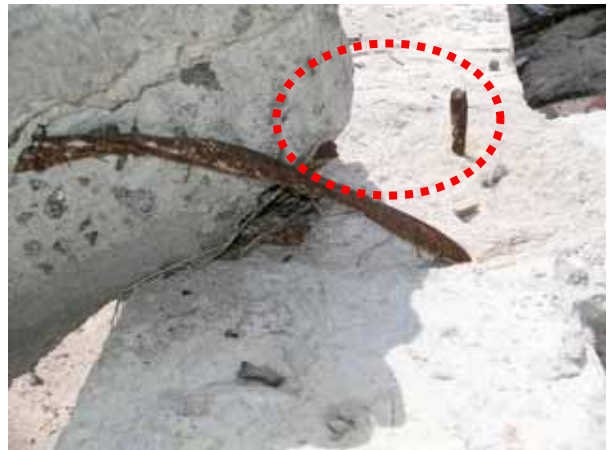
写真4：破断した主筋（くびれが確認された）
