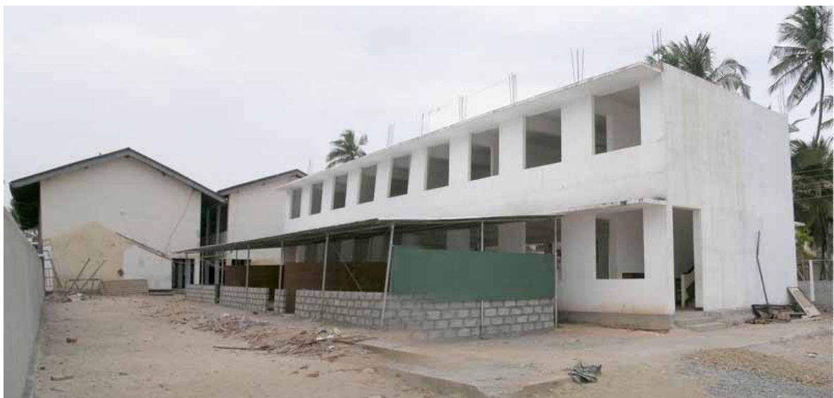
写真 2：RC 造 2 階建て校舎（西立面）
