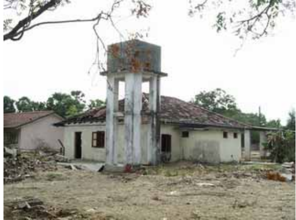
写真5：高架水槽（無被害）
