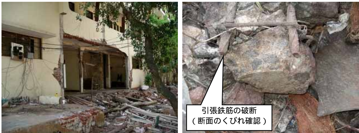
写真5：建物西側廊下側レンガ壁（4スパン）の被害（左：内観／右：外観）
