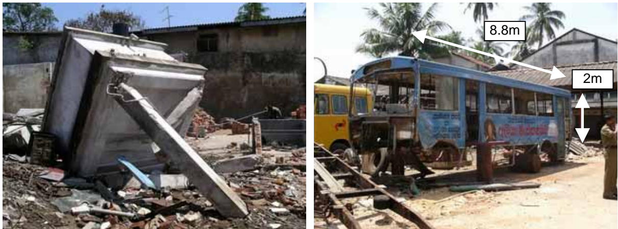
写真 1：転倒した高架水槽 と衝突したバス
