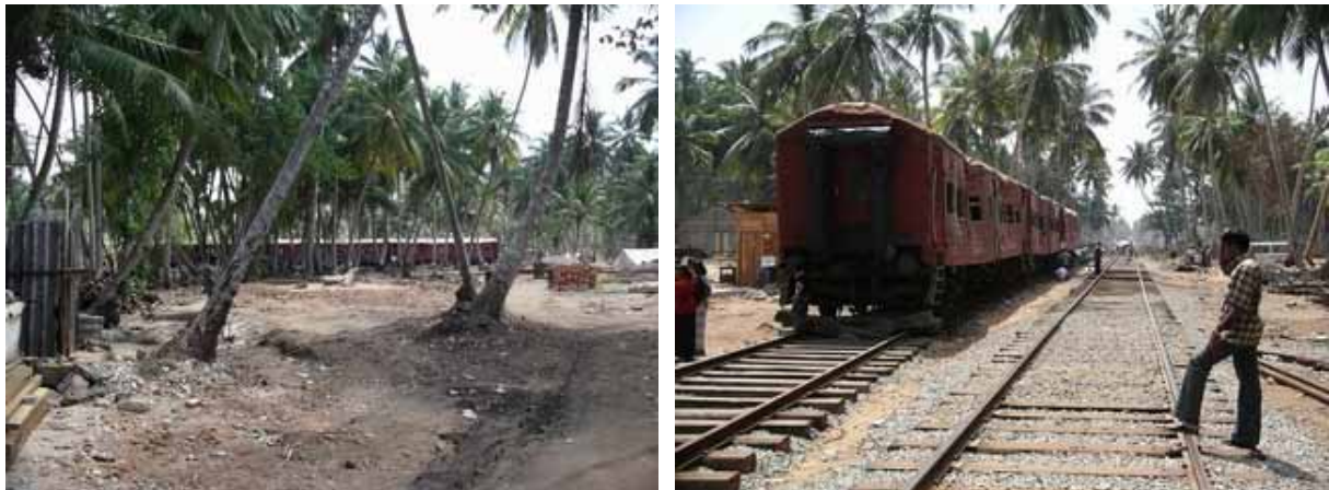
写真2：列車転覆現場と原位置に戻された列車
