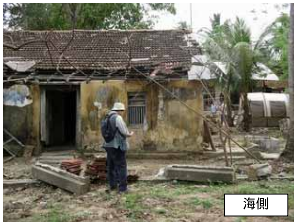
写真3：倒壊した RC 造柱と損傷断面（鉄筋の破断と断面のくびれを確認）
