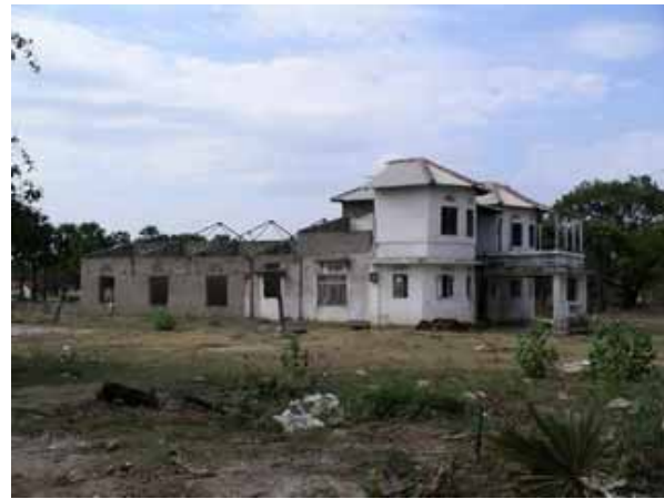
写真2：近くの住宅の被害
