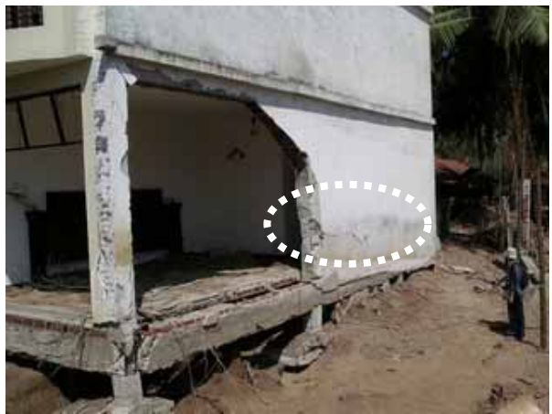
写真 3：津波により崩壊した東側妻面のレンガ壁(右壁中央には内圧によるひび割れ)
