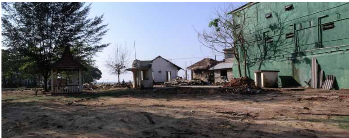
写真 2：調査建物（中央）を含む内陸側からの周辺の様子
