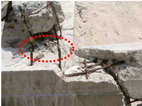
写真4：破断した主筋（くびれが確認された）
