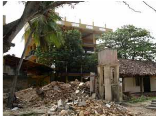
写真 4：隣接敷地内の高架水槽は被害無し
