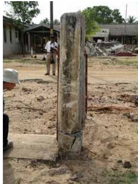
写真3：傾斜した門柱には衝突痕が見られる
