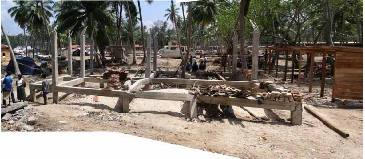
写真3：建設途中のRC造建物
