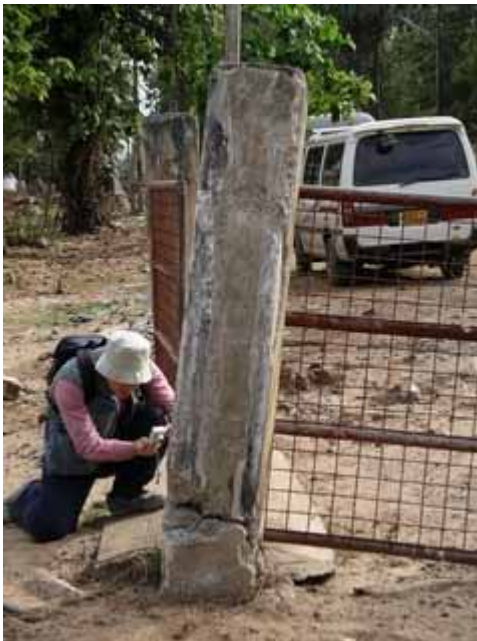
写真3：傾斜した門柱には衝突痕が見られる
