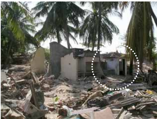
写真 1：無被害の屋外トイレ
