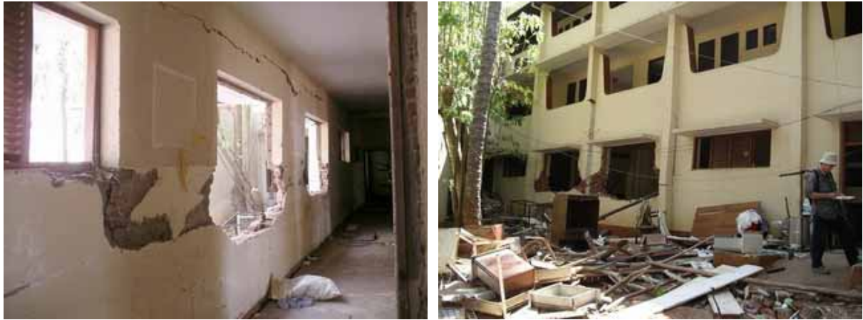
写真5：建物西側廊下側レンガ壁（4スパン）の被害（左：内観／右：外観）
