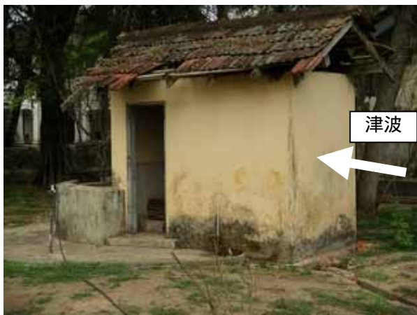
写真 3 : 調査した小屋 とその近くの建物での津波高さ実測 (2.05m)
