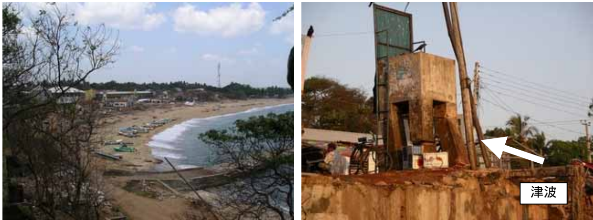
写真 1：Hambantota の海岸と大破した高架水槽
