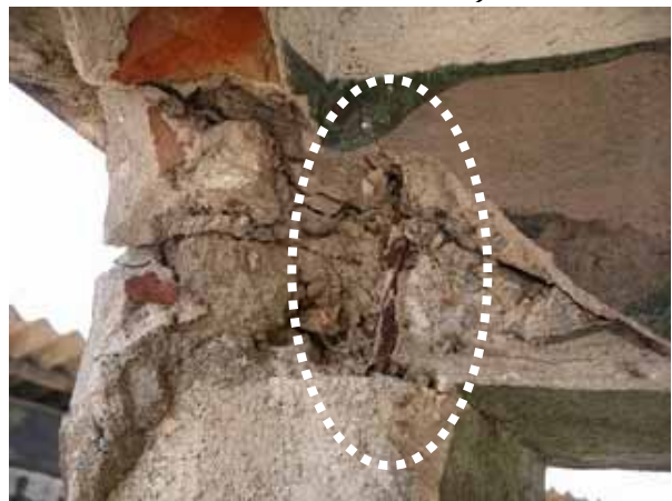
写真 3：RC造柱における鉄筋の露出
