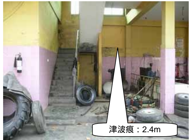
写真 5：敷地前を通る海岸道路と近接する工場での津波痕
