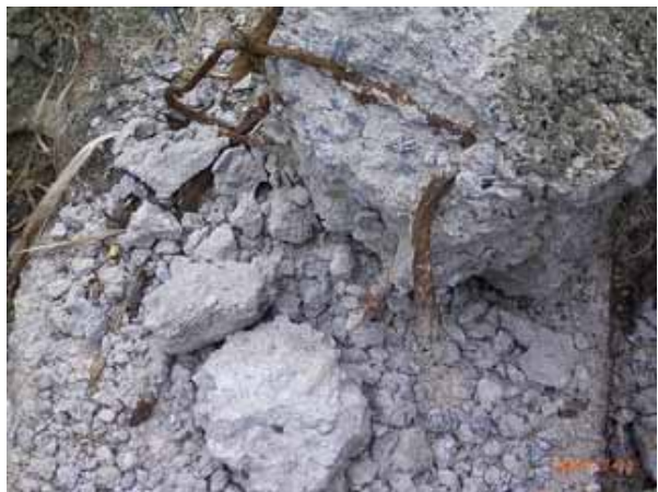
写真3：倒壊した RC 造柱と損傷断面（鉄筋の破断と断面のくびれを確認）
