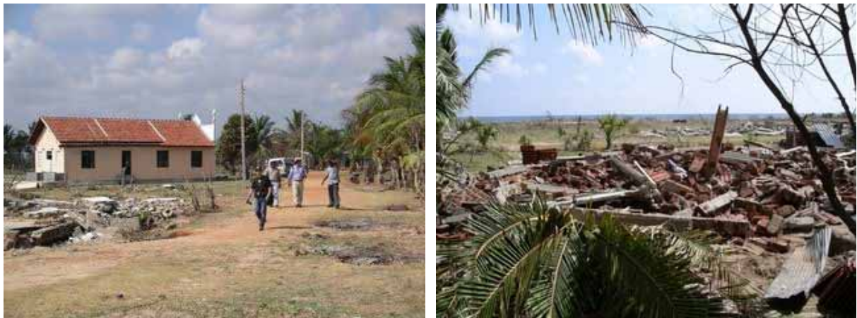
写真2：津波で屋根が被害を受けたイスラム教会 写真3：集落は壊滅状態
