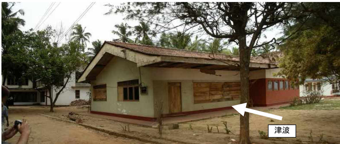
写真4：津波高さの実測を行った郵便局（左）と住宅（右）
