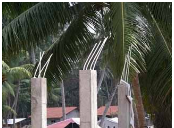
写真5：転倒していない柱でも大きな曲げひび割れ，露出主筋の湾曲が見られる
