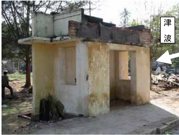
写真 2 : 屋外小屋 （被害は見られない）
