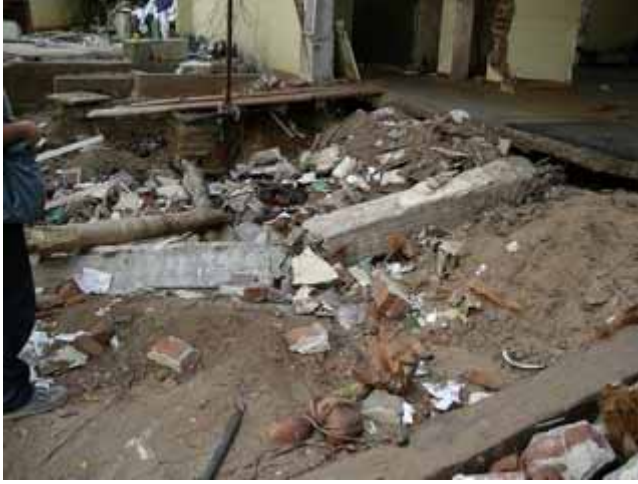
写真7：写真6の柱（中央で折損）
