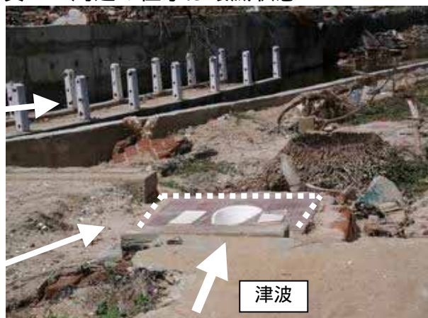
写真2：崩壊・流失した橋（左上）と崩壊した屋外トイレ
