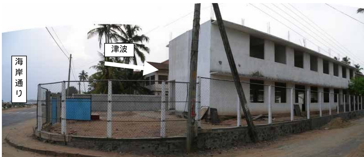
写真 1：RC 造 2 階建て校舎（東立面）
