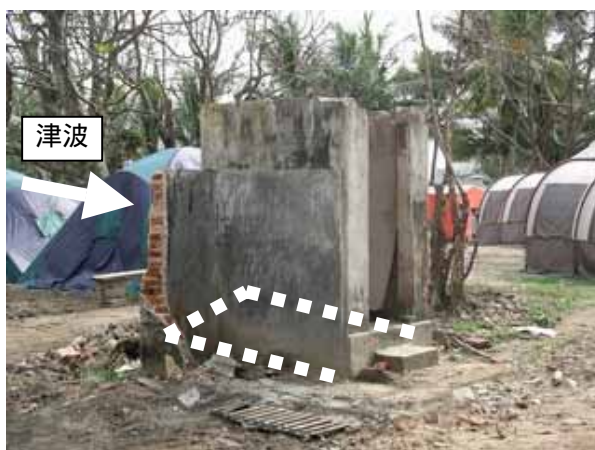
写真5：津波の来襲方向と開口方向により被害程度の異なる屋外トイレ （左：屋外トイレ / 右：屋外トイレ）
