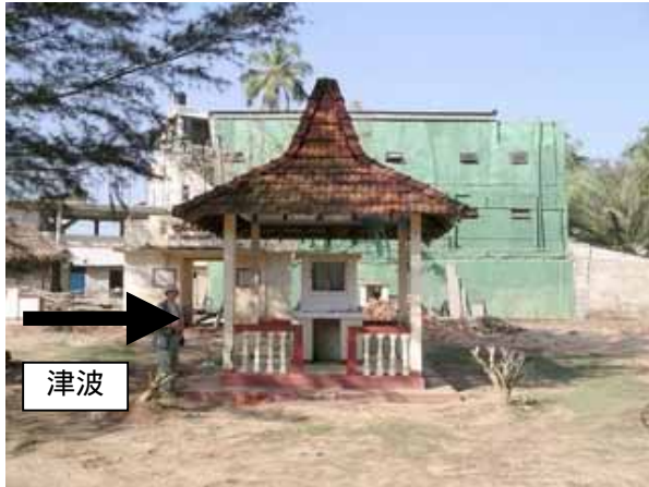
写真 1：仏廟（被害は見られない）
