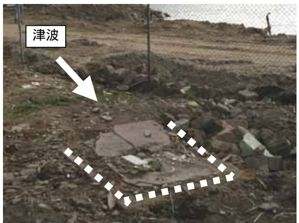
写真5：津波の来襲方向と開口方向により被害程度の異なる屋外トイレ （左：屋外トイレ / 右：屋外トイレ）
