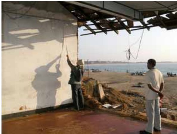
写真3：建物内での津波計測（2.95m）
