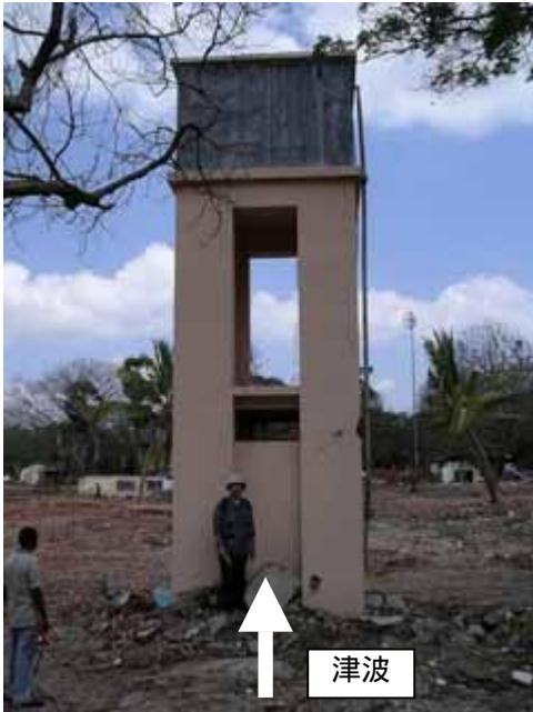
写真1：水運河口付近の高架水槽
