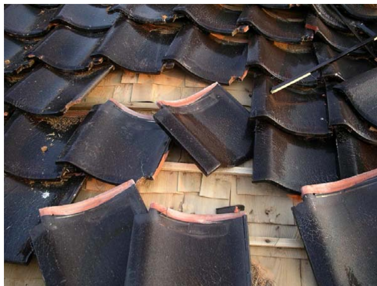
写真 33 道下地区で一般的に使用されている瓦
