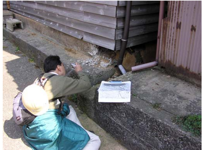
写真2 基礎の詳細な被害状況調査
