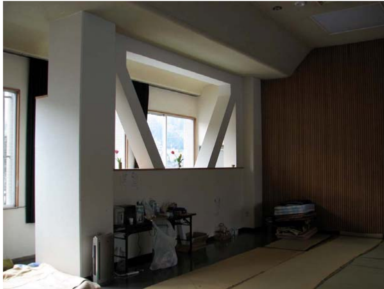
写真 何故か3階のみに設置されているブレース
