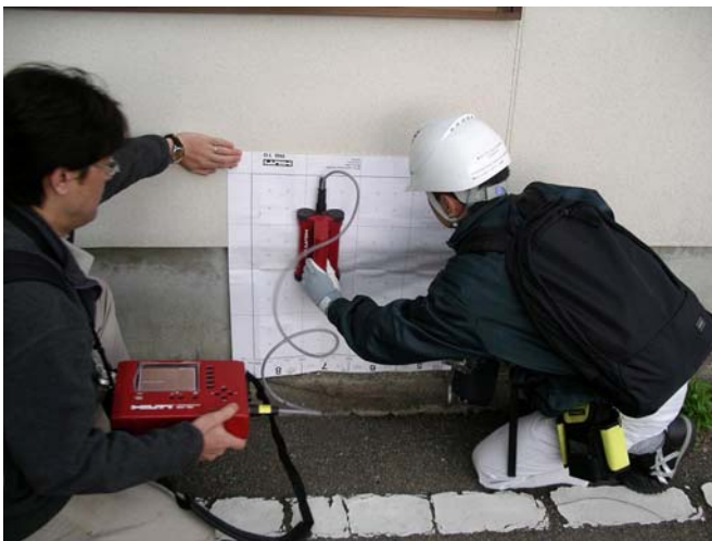
写真3 基礎の鉄筋探査の様子
