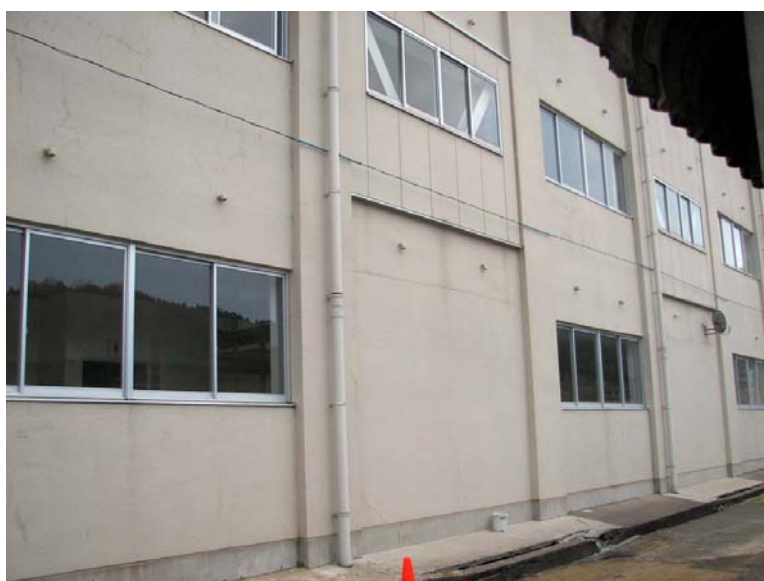
写真 1階が耐震壁/2階がブレース補強
