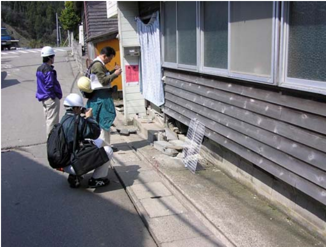
写真1 基礎の被害状況調査
