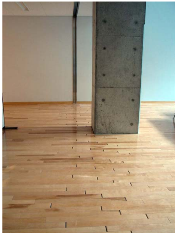
写真 エキспанションジョイント部にあるフローリングの目地開き
