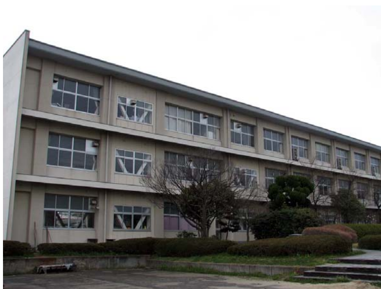
写真 ブレースが設置された校舎
