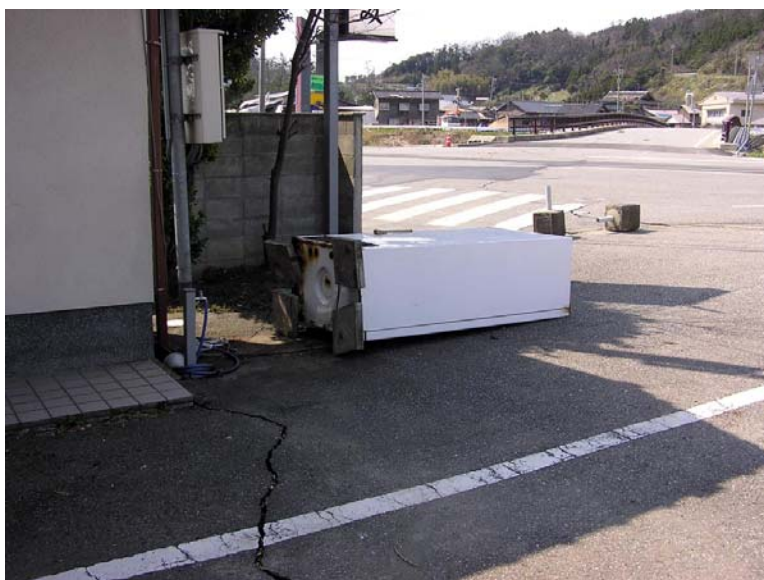
写真 6 入口に設置されていた足元の固定されていない自動販売機が転倒
