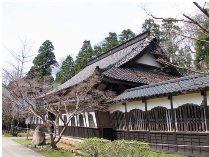
写真 著しく傾斜した回廊
