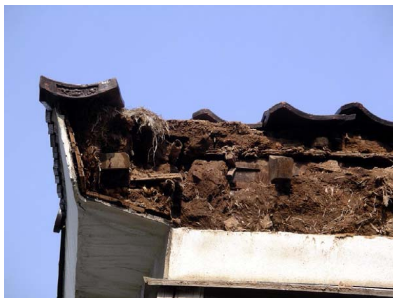
写真 18 屋根を覆う土とスサ
