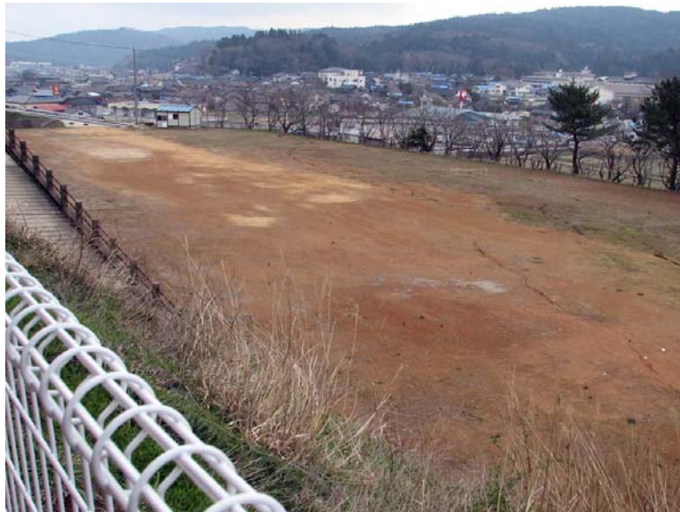
写真 盛土した校庭に亀裂
