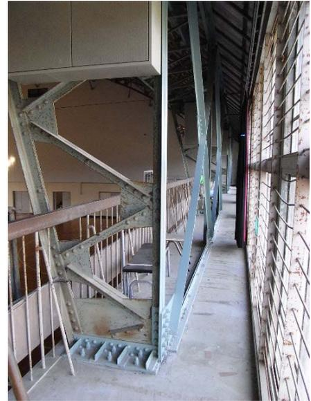
屋体は鉛直ブレースによる補強がなされている（色の鮮やかなブレースが増設要素）
