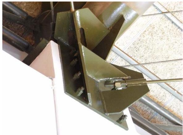
既存の鉄筋ブレースの下に鉄筋ブレース（写真右）を増設した模様
