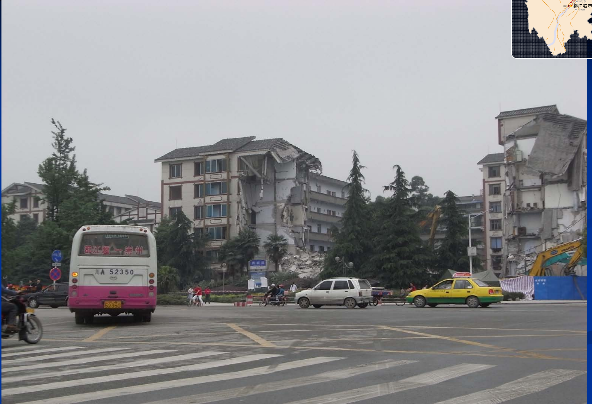
都江堰市内の倒壊建物
