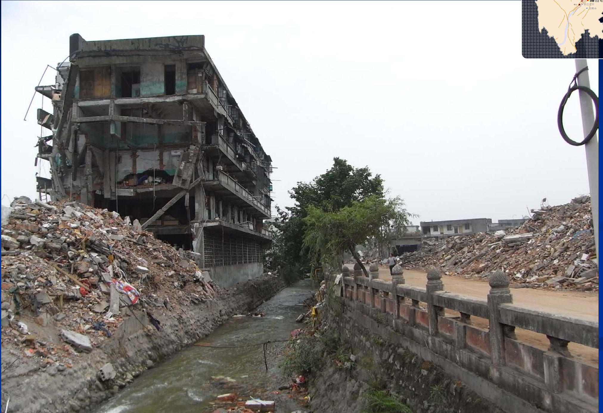
綿竹市・漢旺／大破した建物
