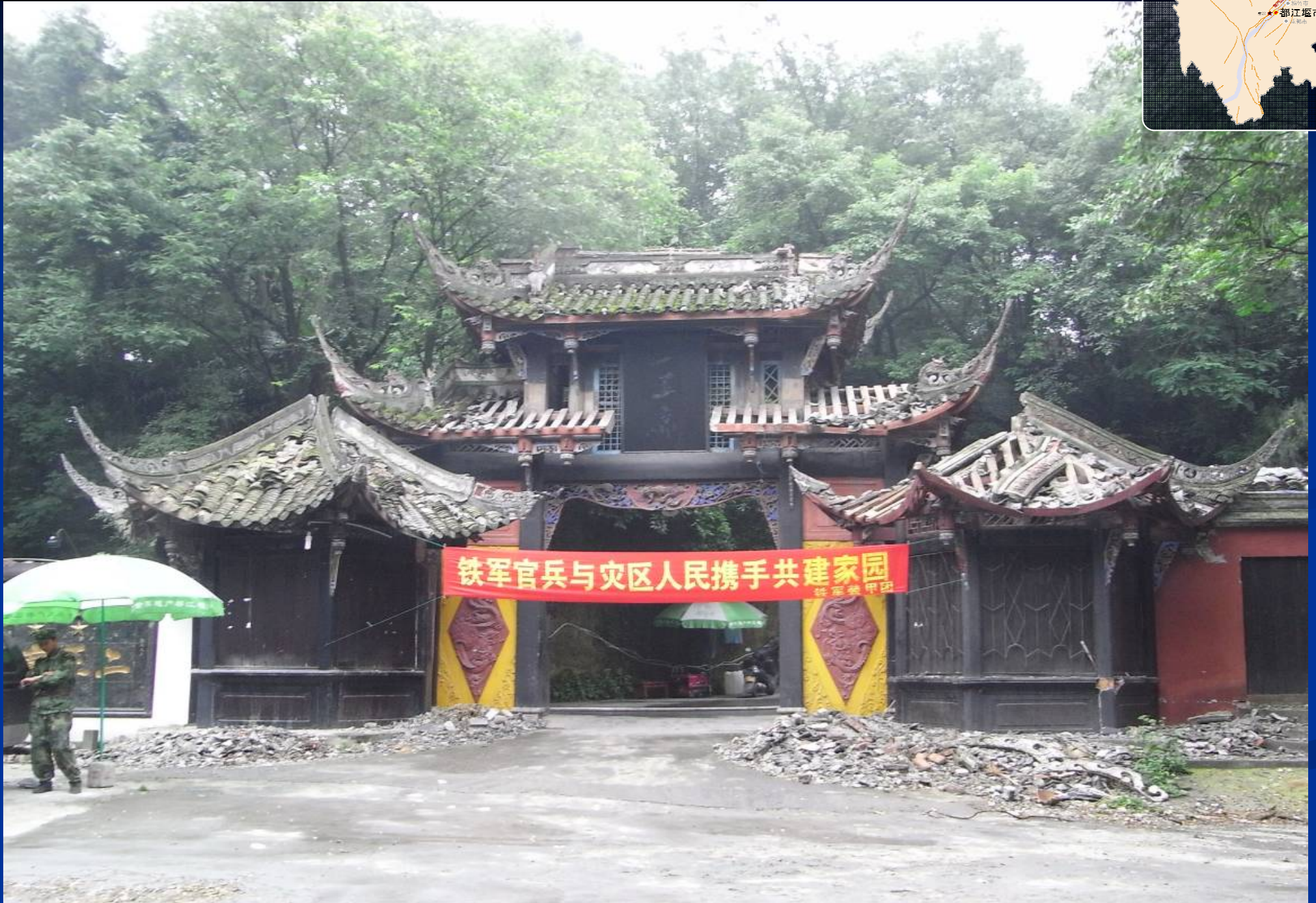
都江堰(世界遺産)での被害
