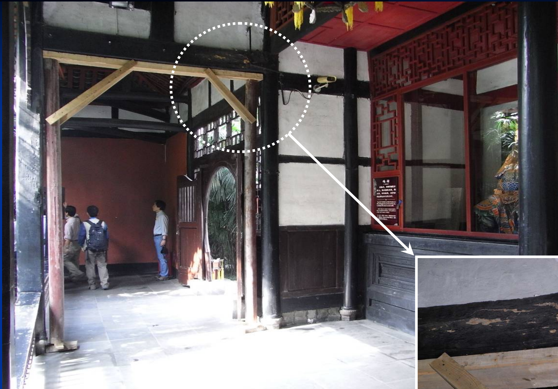
武侯祠博物館(成都市内) / 折損した梁のための補強
