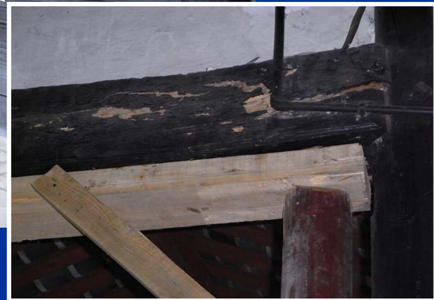
武侯祠博物館(成都市内) / 折損した梁のための補強
