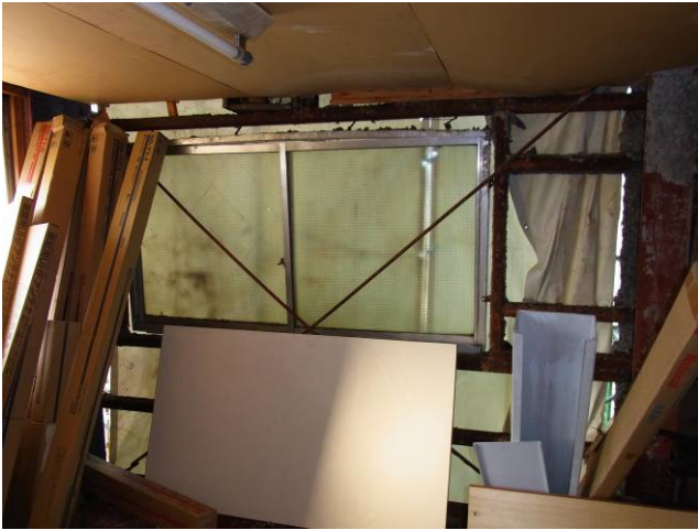
写真 6-19-2 壁材の脱落
