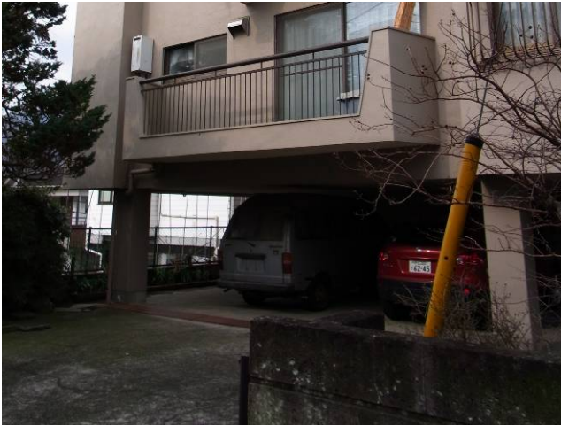
写真 6-23-2 建物のピロティ柱
