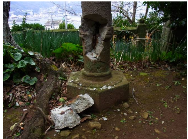
写真 6-31-3 石灯籠の軸骨が露出
