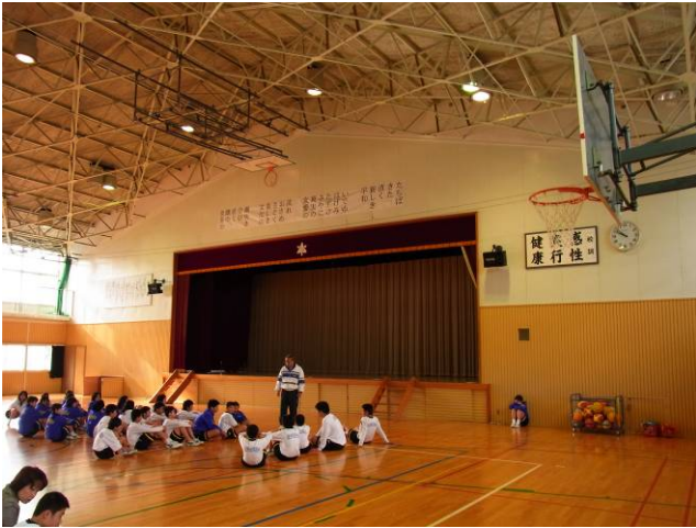
写真 6-8-4 スピーカーの付いている体育館妻壁
