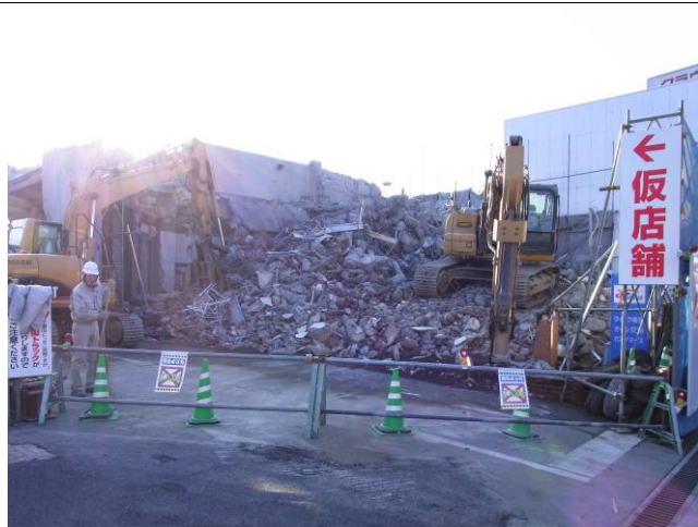
写真 6-22-1 建物全景 (解体中)
