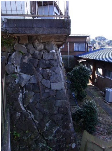
写真 6-24-2 擁壁の亀裂
