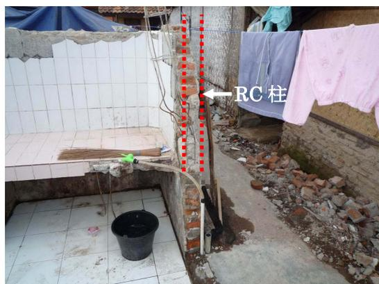
写真 4.2.4 CM 住宅の柱寸法 (壁厚と同じ)
