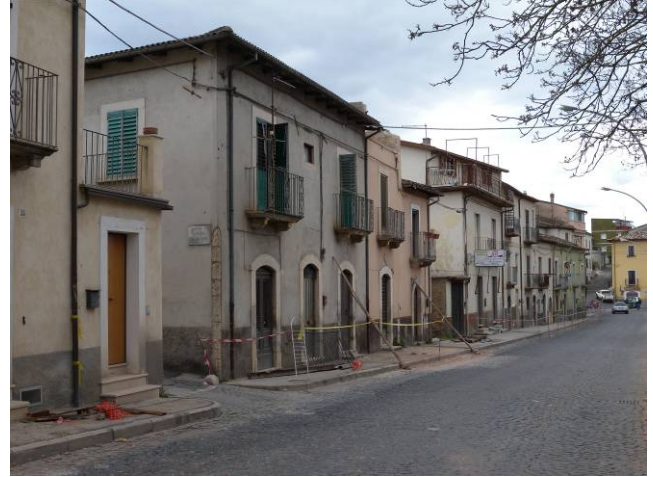
写真 26 歩道部分を封鎖している例
