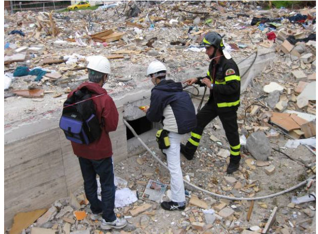
写真4 シュミットハンマー調査 ：建物基礎部分にて
