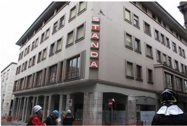
写真9 隅角部の柱の損傷と壁のひび割れ(4)
