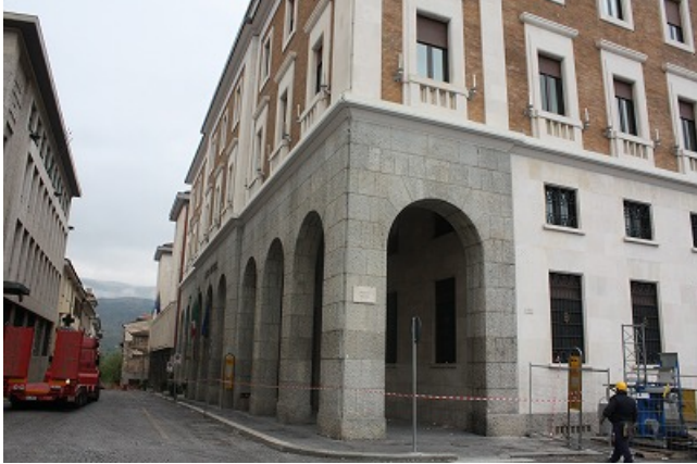
写真1 広場に面して立つ建物(1)
