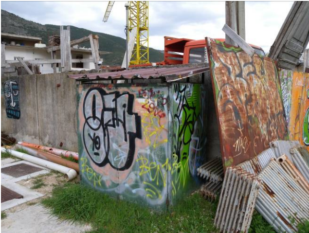
写真31 強震計 S05 の設置状況
