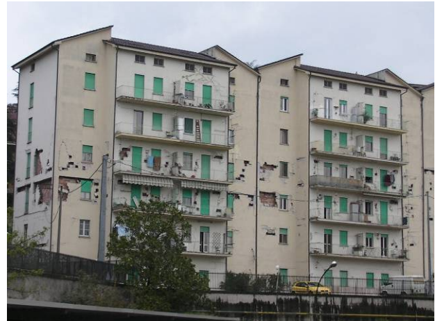
写真 15 建物⑤：3階、4階での被害が目立つ
