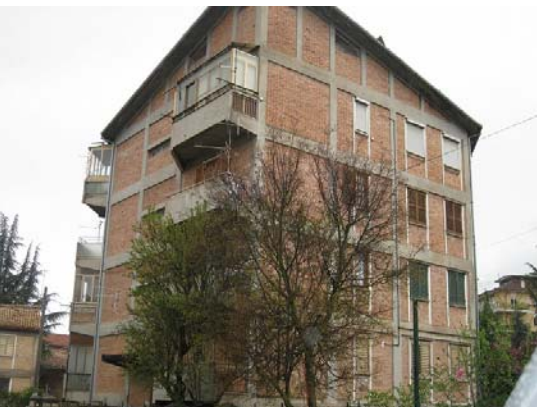
写真 24 4階建て RC 造集合住宅
