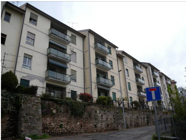
写真 20 建物⑦：全景
