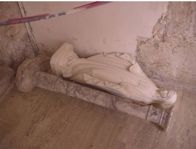
写真17 飾り柱, マリア像の落下
