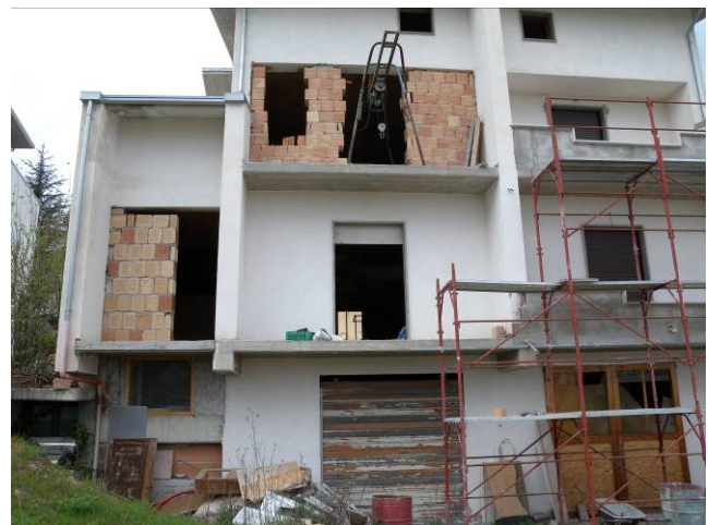
写真 24 Coppito の丘の頂上付近の建設中分譲住宅
