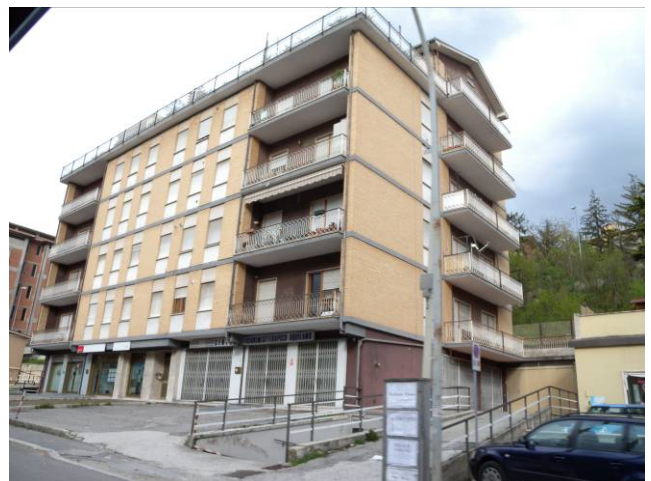
写真34 封鎖地域周辺道路沿いのRC造集合住宅
