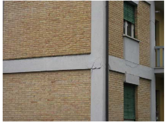
写真 27 4階建てRC住宅
