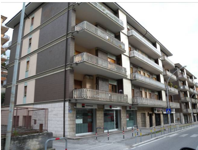
写真33 封鎖地域周辺道路沿いのRC造集合住宅
