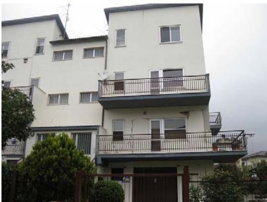
写真 16 4階建て RC 住宅
