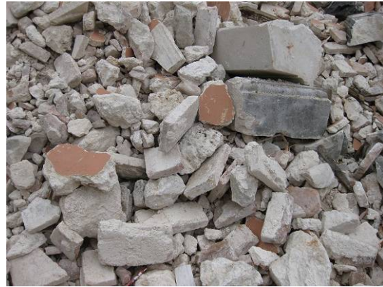
写真31 崩壊した組積材と仕上の残骸
