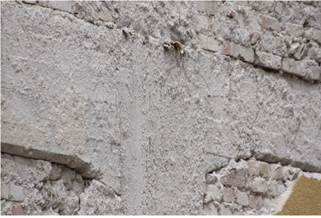
写真 15 接合部拡大：柱左右で梁せいが異なる(5)
