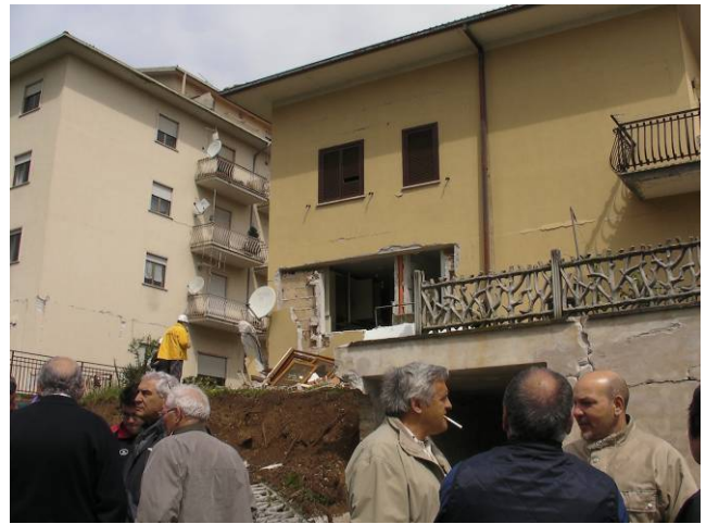
写真17 斜面崩壊の様子
