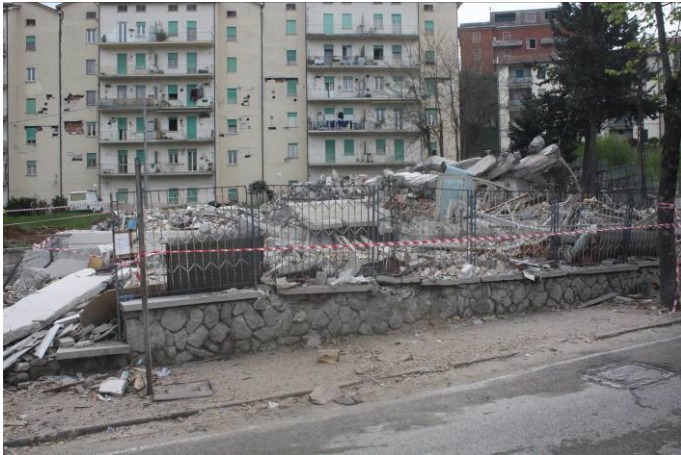
写真1 建物①：倒壊して瓦礫となっている
