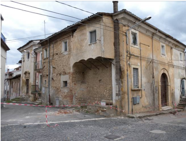
写真 27 自然石の石積み住宅
