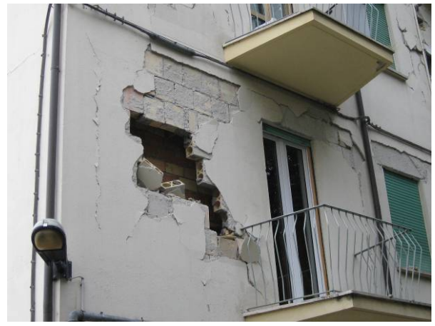
写真 17 建物⑤：空洞煉瓦壁を2重にして設置
