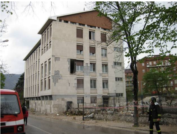
写真5 建物②：全景
