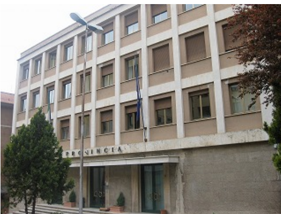
写真 21 行政関係の建物 損傷なし(11)
