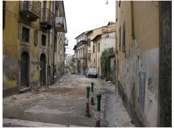
写真 23 Via Donadei 通りの仕上剥落
