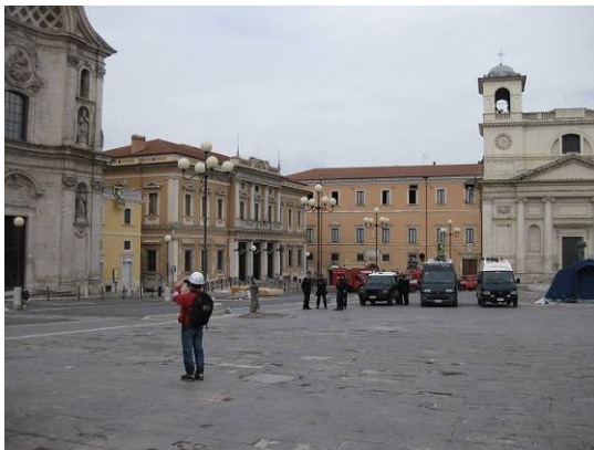
写真 14 広場の南西角
