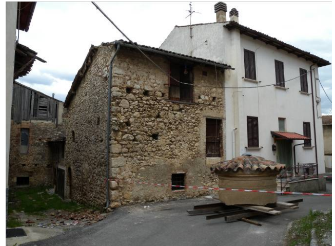
写真 28 自然石の組積壁が一部崩落したため、煙突を屋根から人為的に降ろした模様
