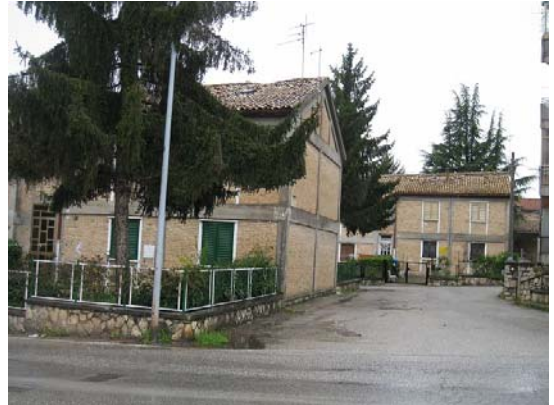
写真 21 低層 RC 造住宅
