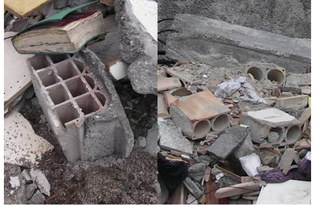
写真2 建物①：空洞煉瓦
