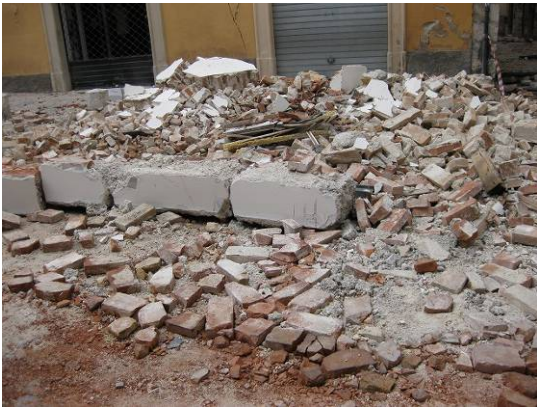
写真26 組積造3階の崩落した壁の残骸
