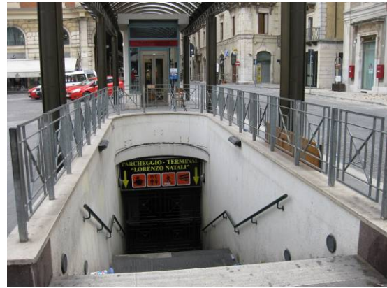
写真5 閉鎖されたドーム広場地下駐車場入口
