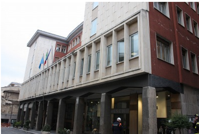
写真5 1階部分がピロティ形式の建物(2)
