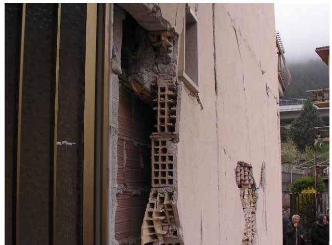
写真7 壁の構造
