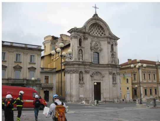
写真8 ドームが崩壊した教会
