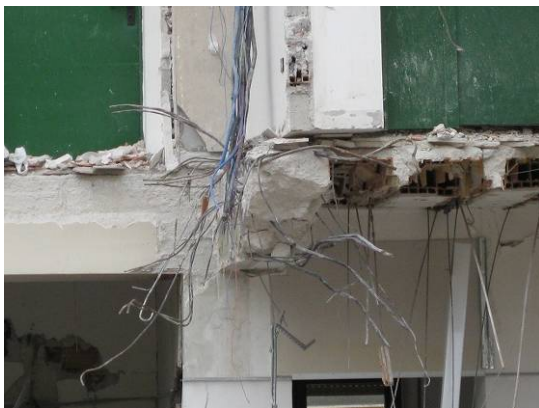
写真 36 2階梁とスラブ
