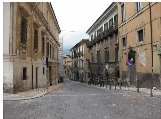
写真 15 南西角 Via dell'Arcivescovado 通り入口
