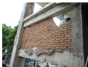
写真16 後打ち RC 柱梁の被害
