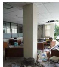
写真20 3階の損傷度Ⅳの柱
