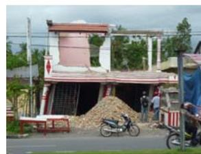
写真 24 枠組み組積構造の被害
