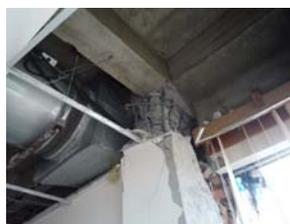
写真19 3階の損傷度Ⅴの柱
