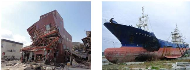
衝突により崩壊した建物 (気仙沼市, 鉄骨造3階) 町中に漂流した船舶 (気仙沼市, 総トン数330t)
