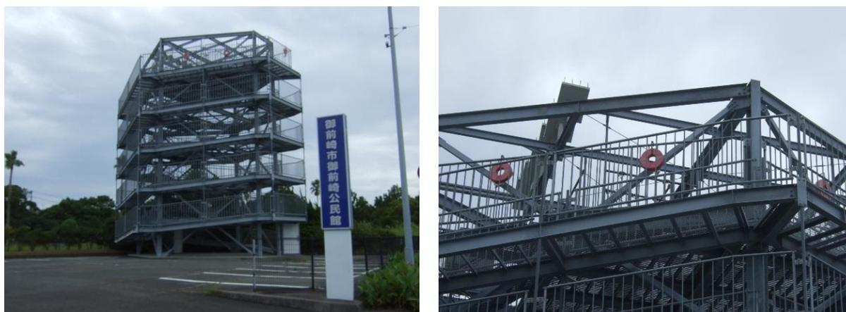
図 3.17 津波避難施設の全景と、最上部に設置された浮き輪
