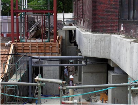
写真 2-2 地下1階ドライエリア部分
