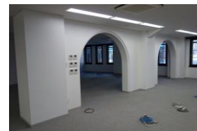
写真1 RC壁増設 (アーチ開口)
