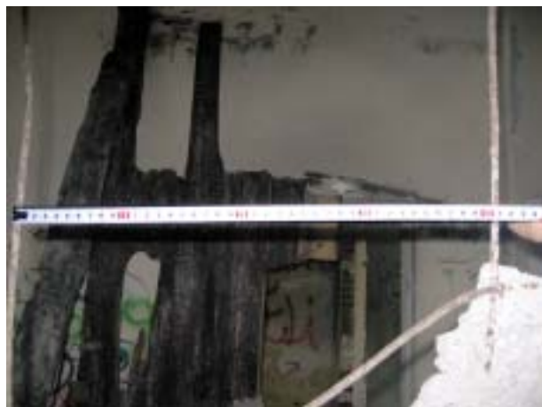
図 3-7 崩落箇所の壁の配筋間隔
