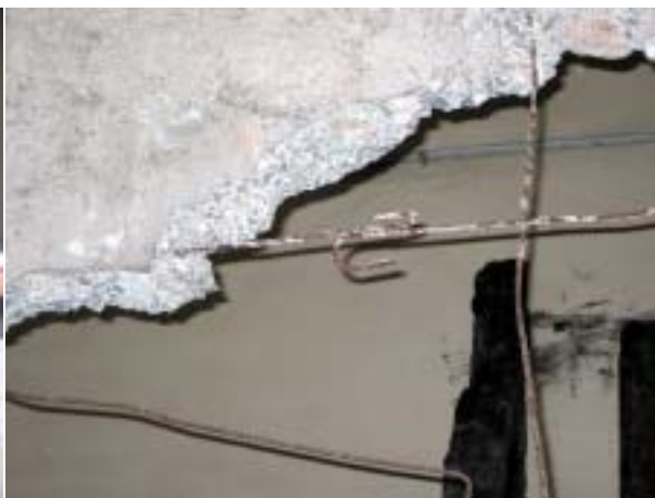
図 3-8 壁の配筋継ぎ手
