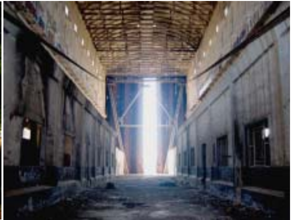
図 3-2 飛行船格納庫内観（北面より）
