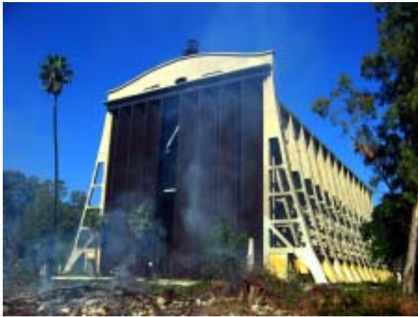
図 3-1 飛行船格納庫概観（南面より）
