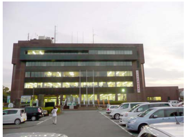
写真 2-2 市庁舎全景（北面）
