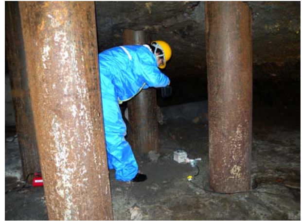
写真 2-4 ピックアップ設置の様子
