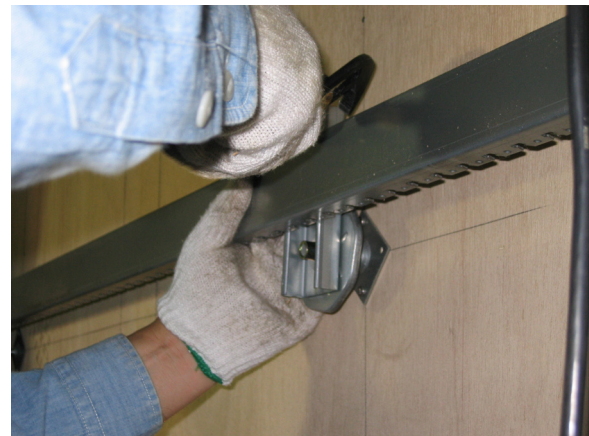
写真 3-10 落下防止措置不要の例 (ezBar CPon)
