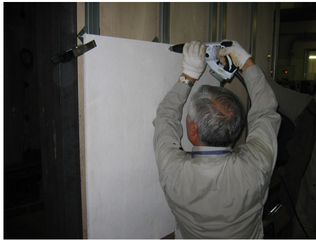
写真 3-13 外装材パネルの取付け
