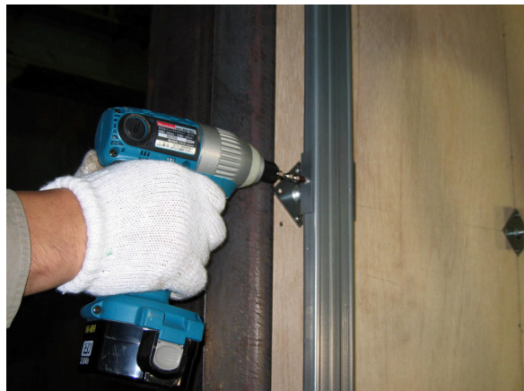
写真 3-9 落下防止用ビス止め (外装パネル割付に1箇所)
