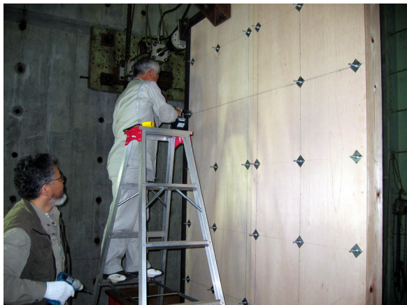
写真 3-2(A) 受け金物の取り付け（全景）
