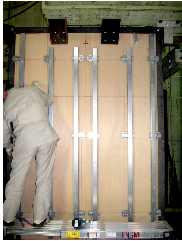
写真 3-12 胴縁取付け例 (ezBar CPon+縦胴縁)
