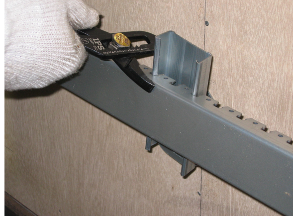
写真 3-8 胴縁の取付け (ezBar CPon の場合)
