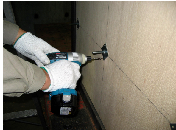
写真 3-2(B) 受け金物の取り付け（詳細）
