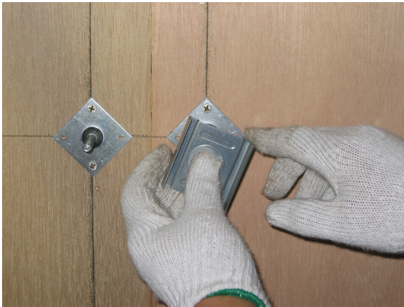
写真 3-5 ezWgrip の取り付け
