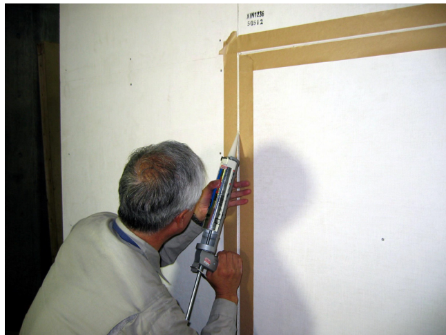
写真 3-14 外装材パネル目地のシーリング
