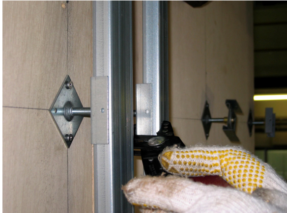
写真 3-7 胴縁の取付け (ezWgrip の場合)
