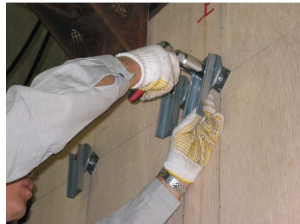
写真 3-6 ezBar CPon の取り付け
