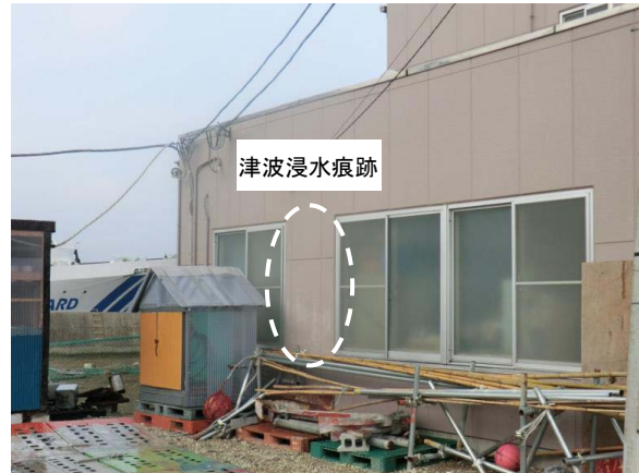
建物の外壁北西面
