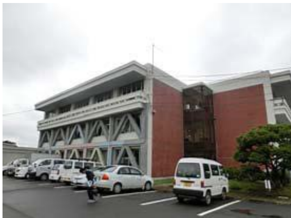
ピタコラムで補強された建物の背面
