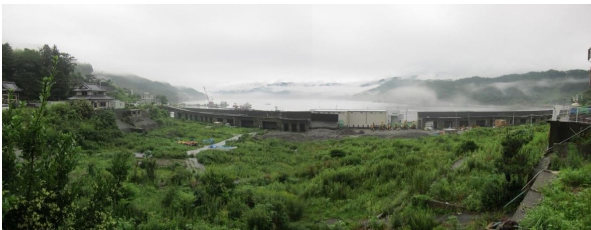
学校付近の堤防の補修様子
