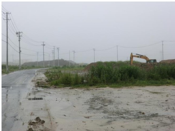
敷地周辺の整地作業
