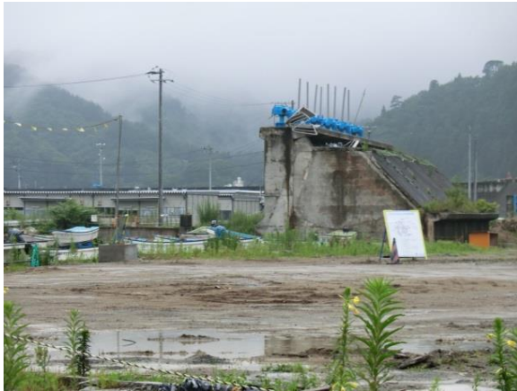
建物の敷地南側（海側）の様子（堤防復旧工事中）
