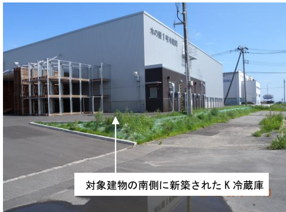
隣接建物の様子
