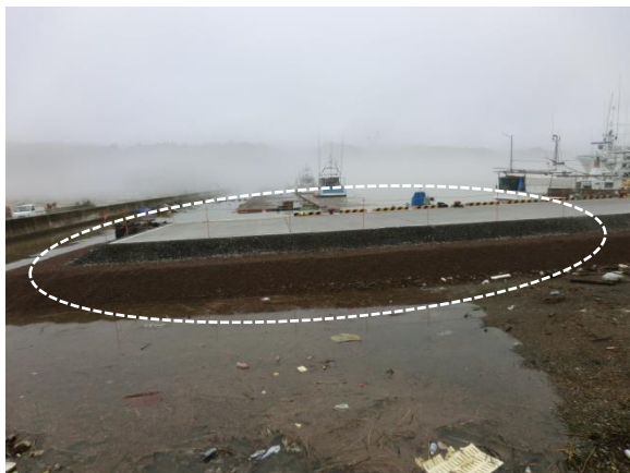
付近の漁港の補修状況
