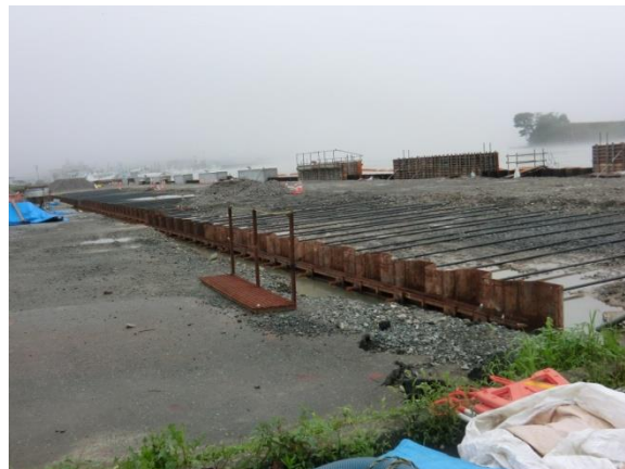
敷地近くの漁港の補修状況
