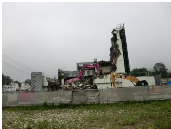
敷地傍の建物の撤去状況
