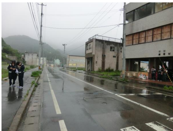
建物の敷地東側の様子
