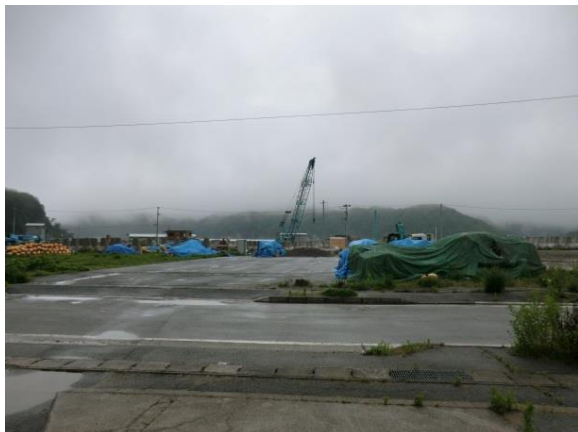
ホテル敷地南側の様子（堤防復旧工事中）
