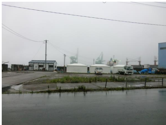
建物の敷地南側の様子
