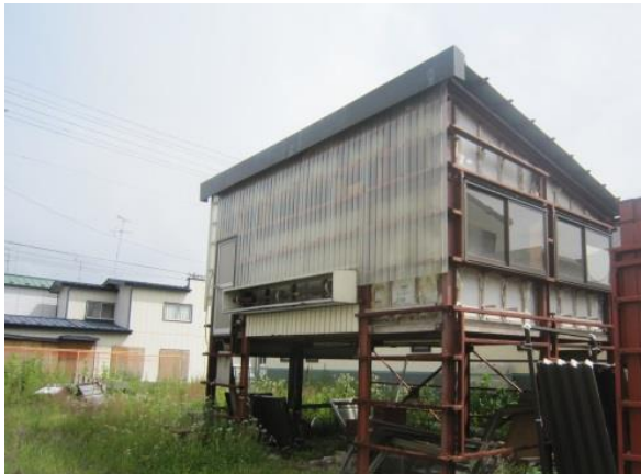
工場敷地内の建物
