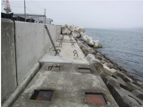
補修された部分の様子
