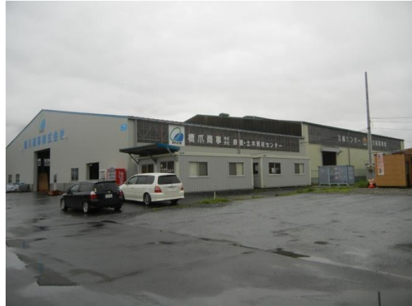
CB 塀裏側の倉庫
