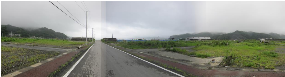
防潮堤周辺の復旧工事
