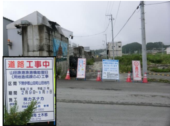
防潮堤敷地南側の復旧状況
