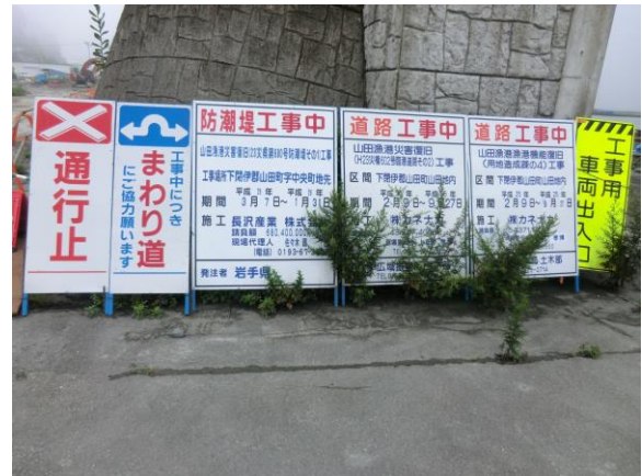
防潮堤付近の復旧工事案内版
