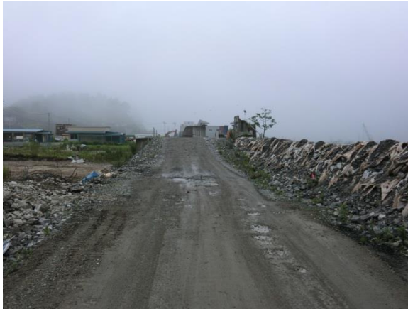
防潮堤敷地北側の復旧状況
