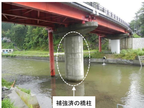
水門近くの補修・補強済みの橋
