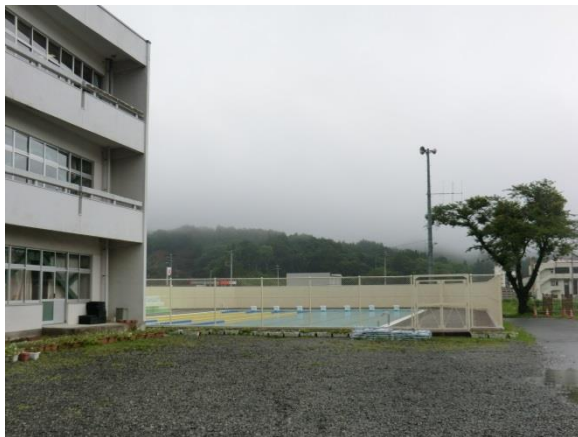
プールのフェンスの改築
