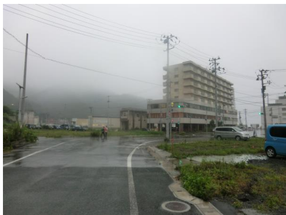
建物の敷地東側の様子
