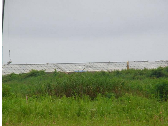
堤防の復旧工事
