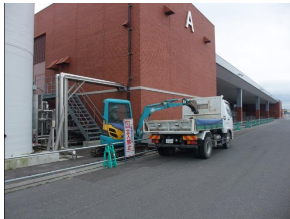
補修工事の様子
