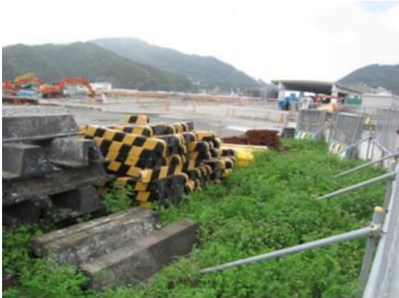
敷地前面の船着場（工事中）
