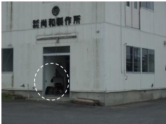
損傷が放置されている石膏ボード
