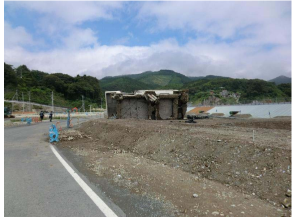
道路から建物遠景
