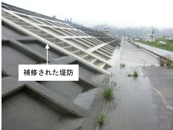
堤防の復旧状況
