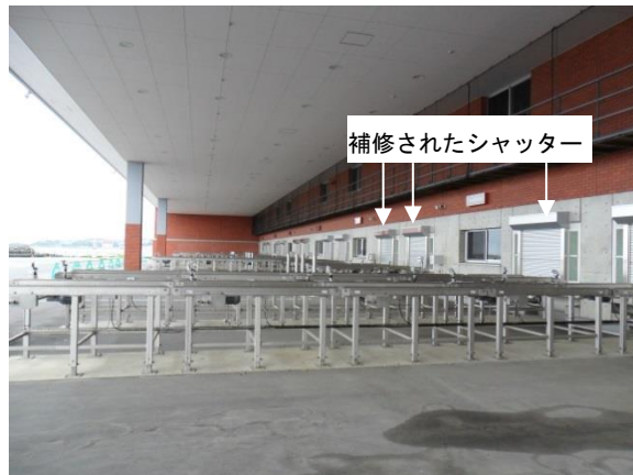
補修されたシャッター
