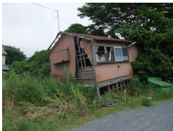
隣接敷地にある傾斜した木造建物
