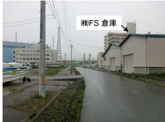
建物の敷地西側の様子
