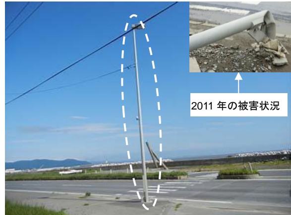
新設された電灯
