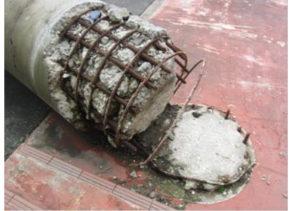
転倒した柱の柱脚
