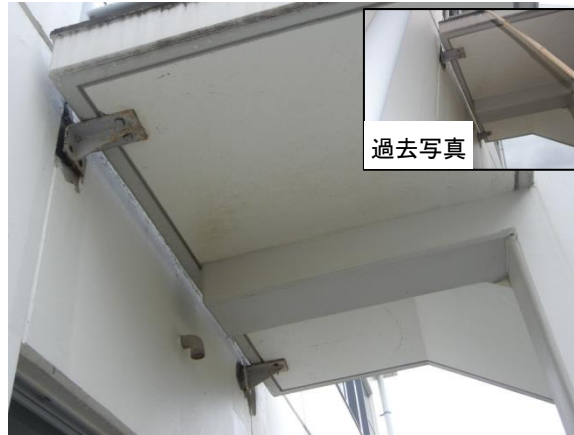
補修していない外付け階段室の定着ボルト
