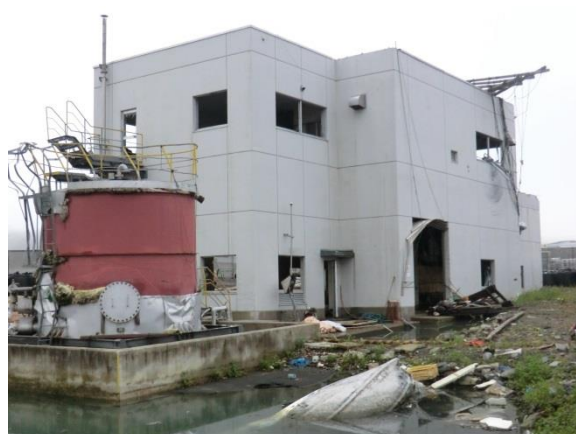
敷地近くの気仙沼清港会ビル
