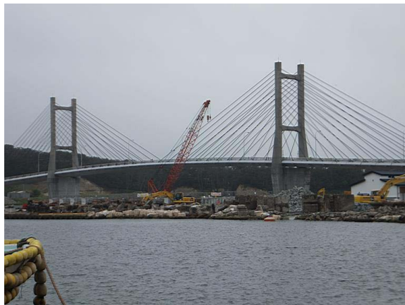
橋の補強工事の様子
