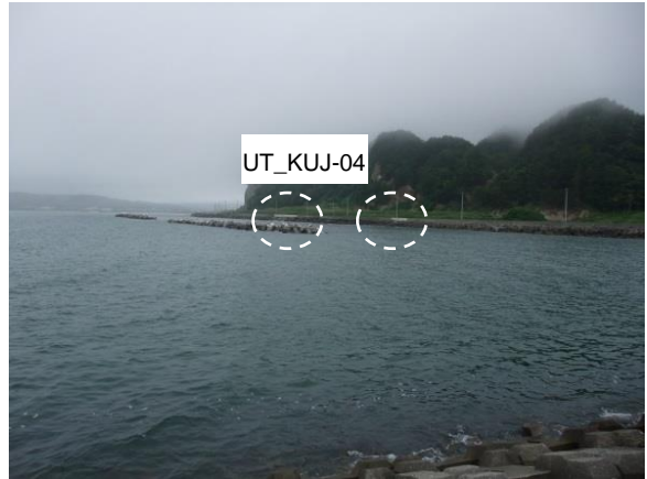
UT_KUJ-04（補修された堤防）方向の様子
