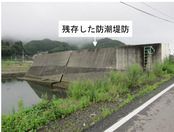
放置されている（残存した）防潮堤の様子
