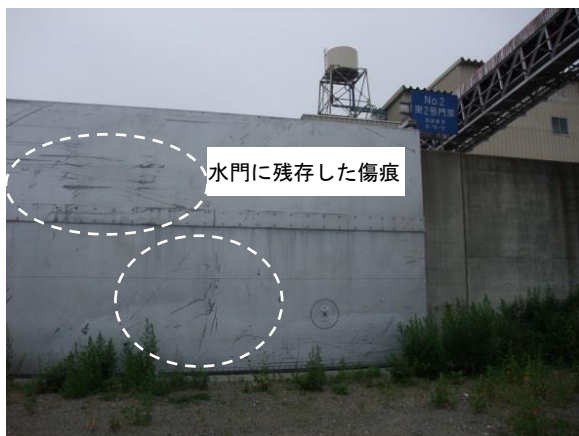
港に面する水門の傷痕
