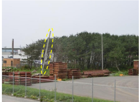
傾斜した電柱
