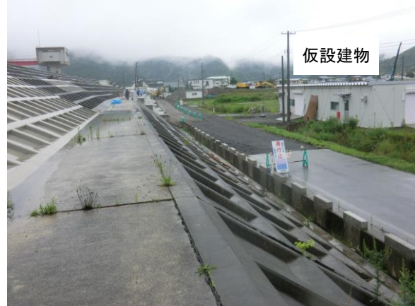
周辺道路の補修工事の様子
