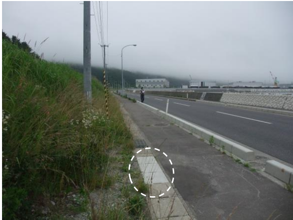
補修された一部の側溝蓋
