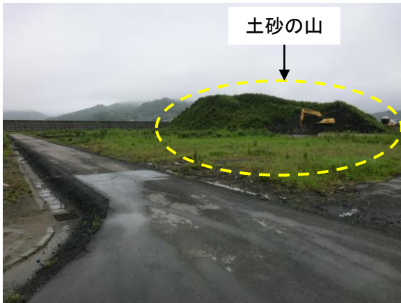
住宅敷地周辺の土砂集積場 (土砂の山)
