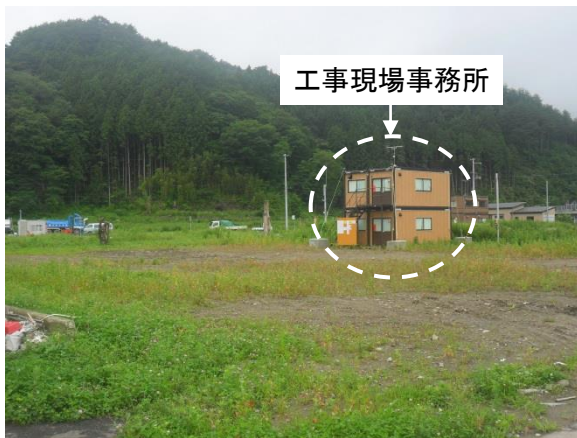
敷地内に設置された工事現場事務所
