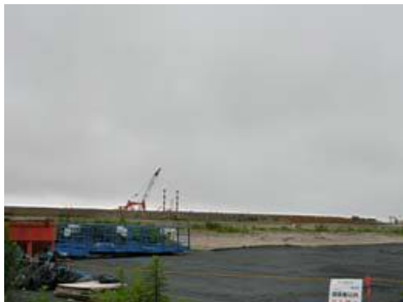
堤防工事の様子
