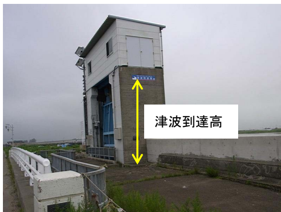
津波到達高を印した水門
