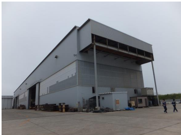
補修された外壁の様子
