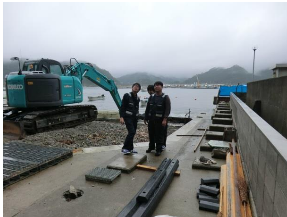
敷地東側（海側）の様子
