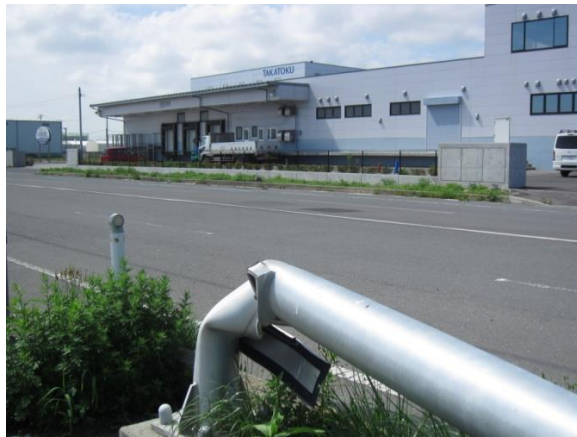
転倒している電灯
