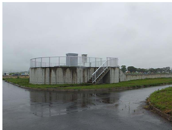
浄化設備は稼働中
