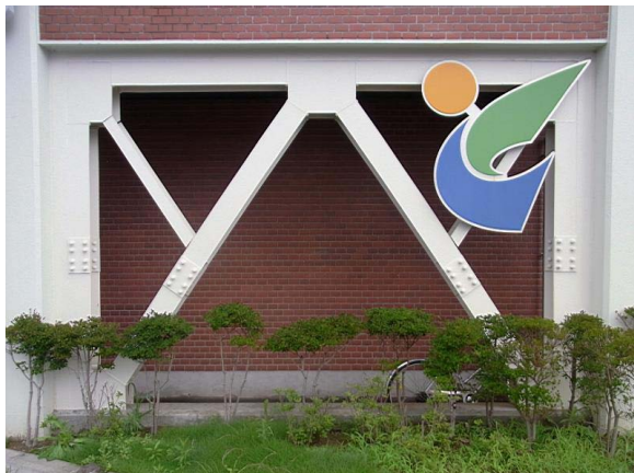
ブレース補強
