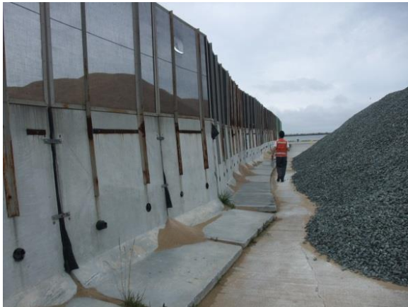
敷地外側からのRC塀
