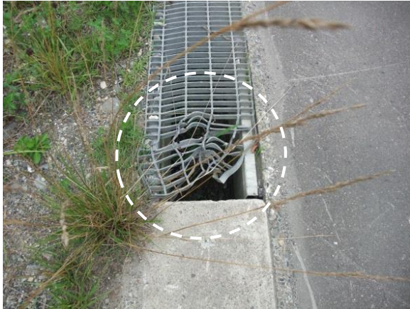
側溝蓋の損傷
