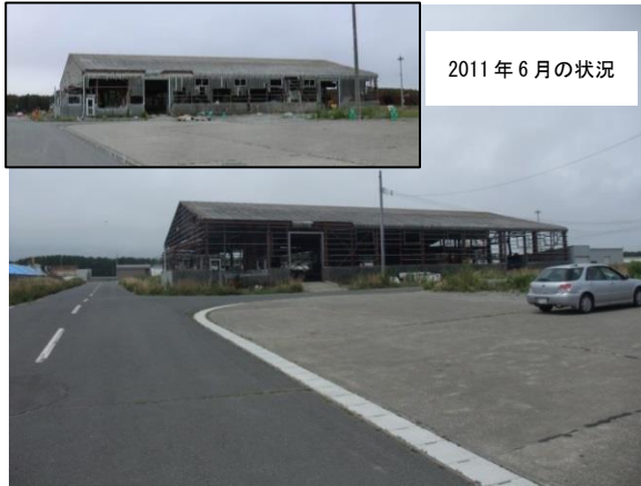
被害を受けた S+CB 造建物
