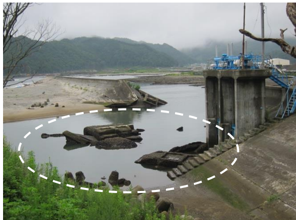
損傷を受けた堤防が放置
