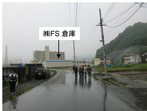
建物の敷地西側の様子
