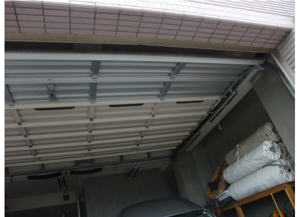
補修されたシャッター
