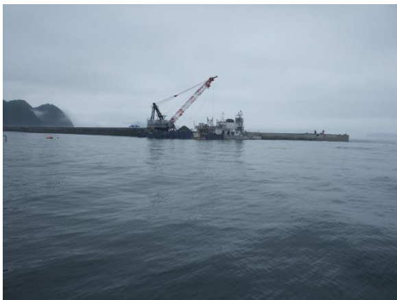
防波堤(南)の復旧工事状況
