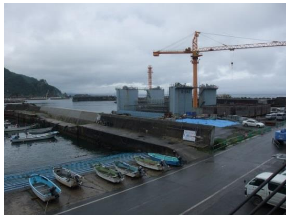
ケーソン工事中
