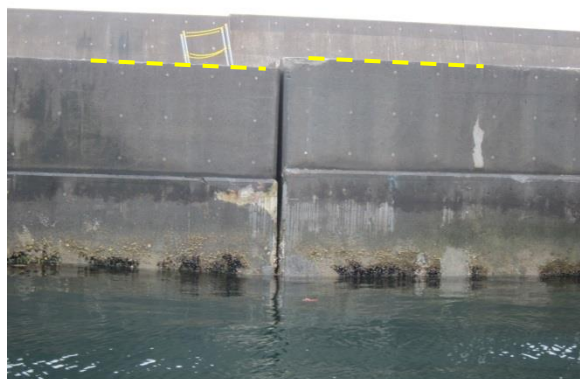
ケーソンの不同沈下（防波堤（南））
