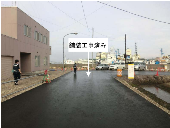
補修された道路の様子
