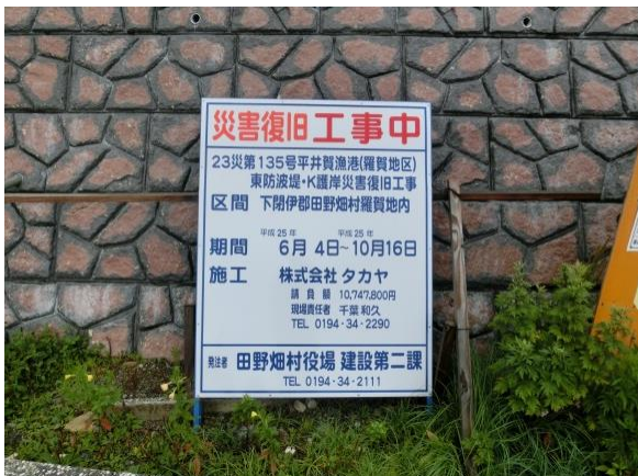
周辺施設の復旧工事が進行中
