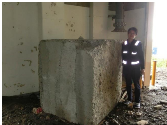
内部には土砂やコンクリート塊が堆積
