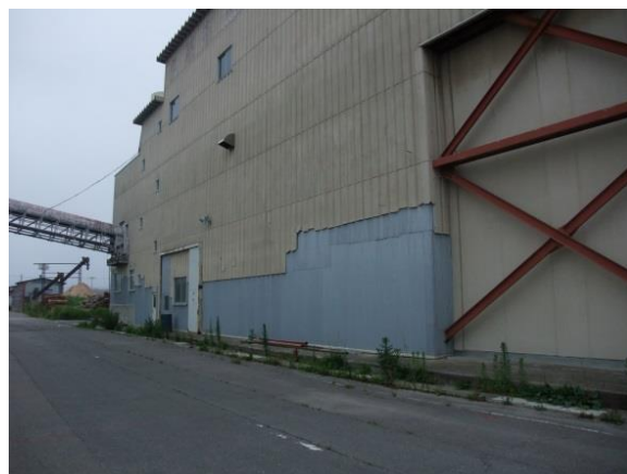
堤防外の外壁が損傷した製氷工場
