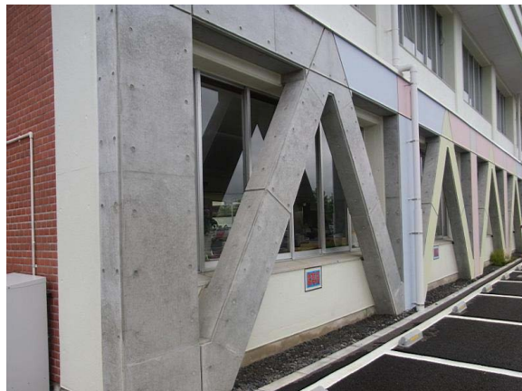
側面（南西方向）ピタコラム補強
