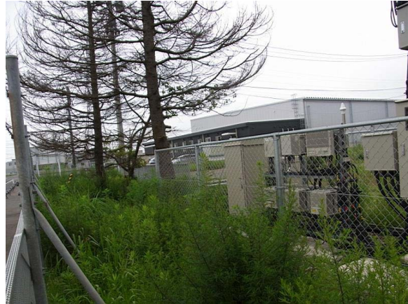
対象建物周辺の様子 2（南）
