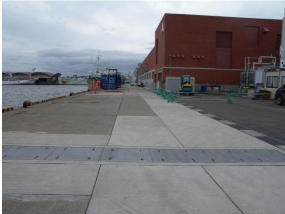
水産会館裏側の補修された地面
