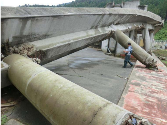
建物間の転倒した渡り廊下
