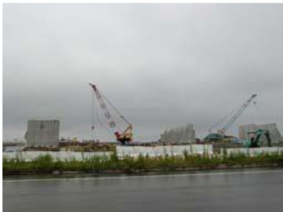
堤防が補修工事の様子
