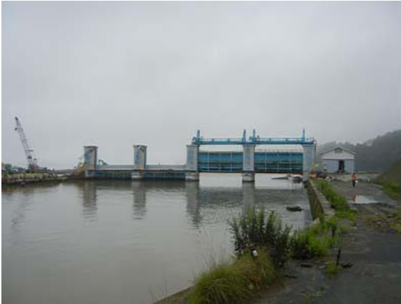
防潮堤水門（陸側）
