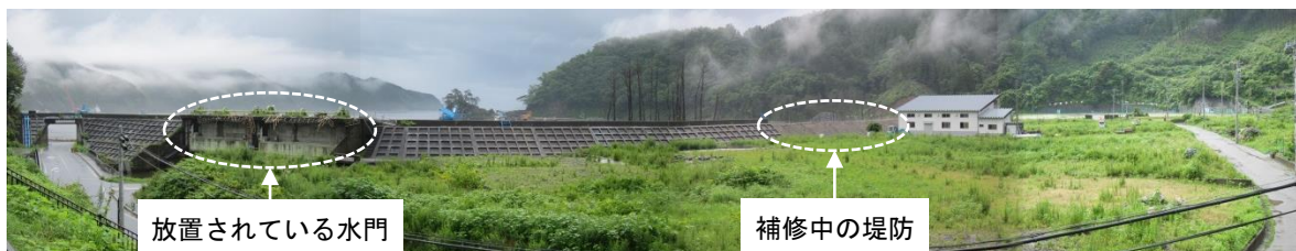
敷地隣の堤防と水門
