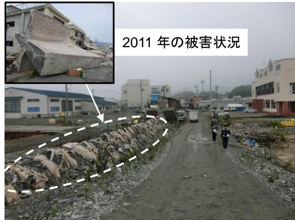
転倒した防潮堤は撤去
