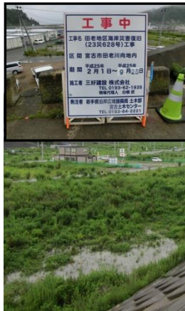
復旧工事案内および防潮堤陸側の様子
