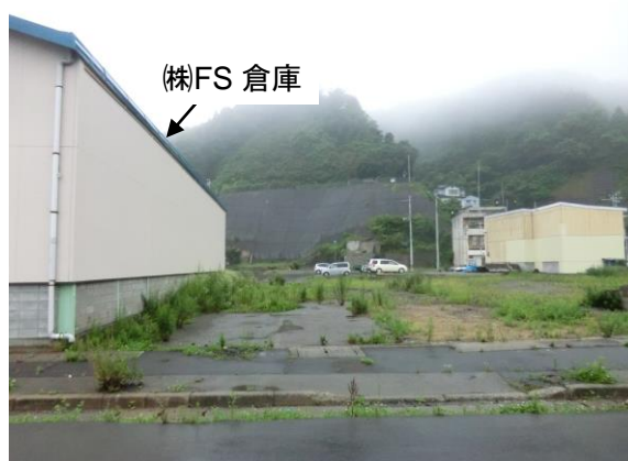
建物の敷地北側の様子
