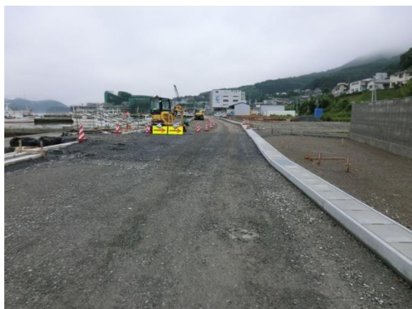
敷地前の道路の補修状況
