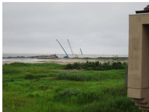
堤防の復旧工事の様子
