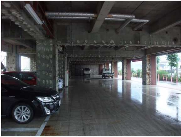
ピロティ内部の状況（柱仕上げは未補修）
