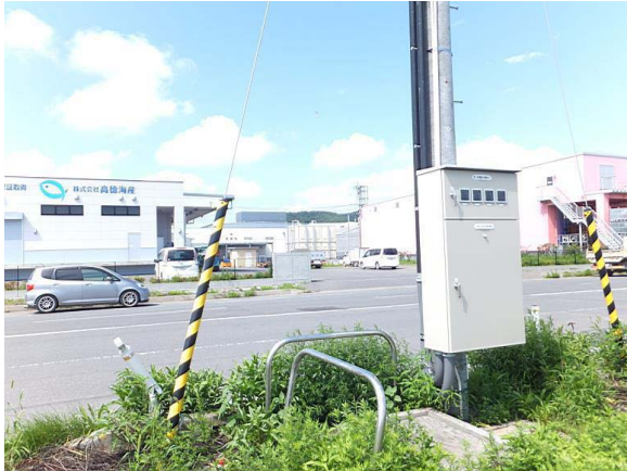
FRP 水槽周辺の様子
