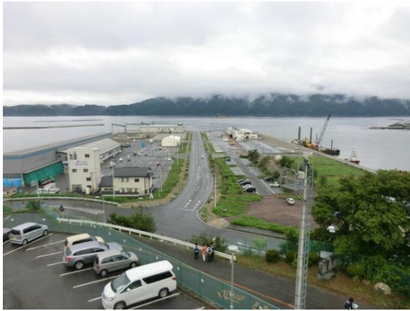
周辺（宮古漁協ビルの南東側）の復旧様子
