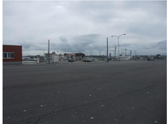
2011年調査時も構造体が打上げられていた道路
