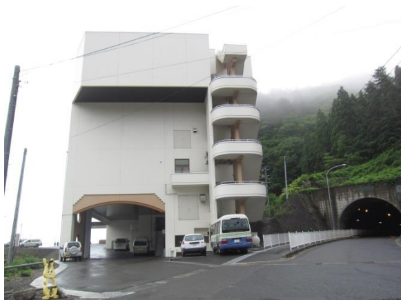
敷地入り口側からの様子
