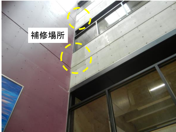
腰壁の補修状況
