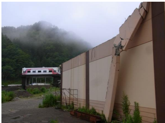
落下したコンクリート製パラペット
