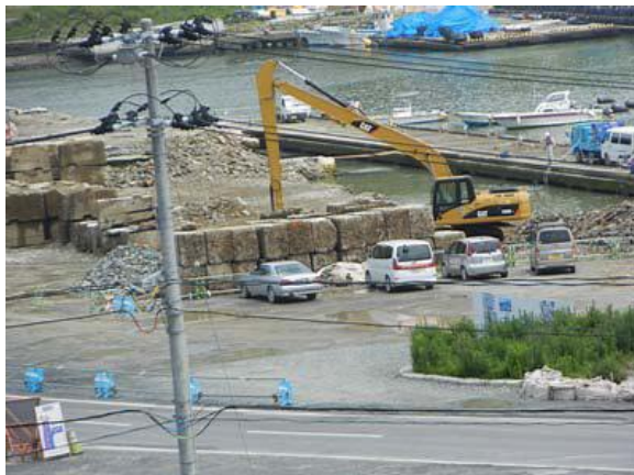
女川町立病院から見た様子
