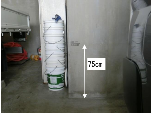
建物内部の浸水記録 (75cm)
