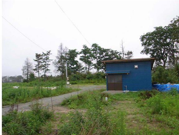
撤去された建物の敷地の周辺の様子
