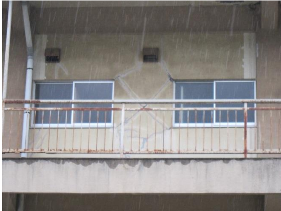
立て替え予定の3階雑壁の損傷状況
