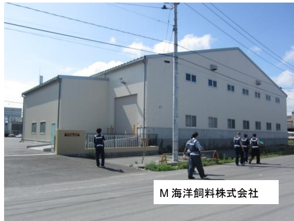
隣接する建物の様子 2
