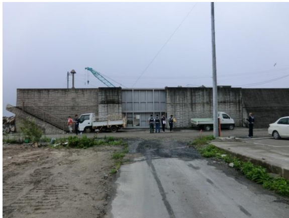
損傷した防潮堤付近の陸側
