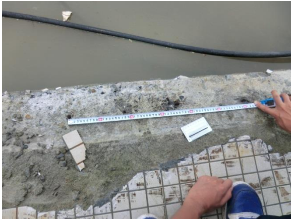
壁筋の間隔の計測
