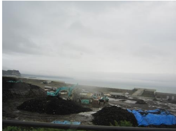
付近の堤防の様子（工事中）
