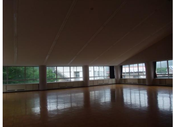
補修済みの多目的ホールの天井
