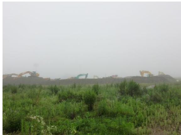
敷地周辺の整地作業
