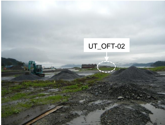
敷地から見た海側
