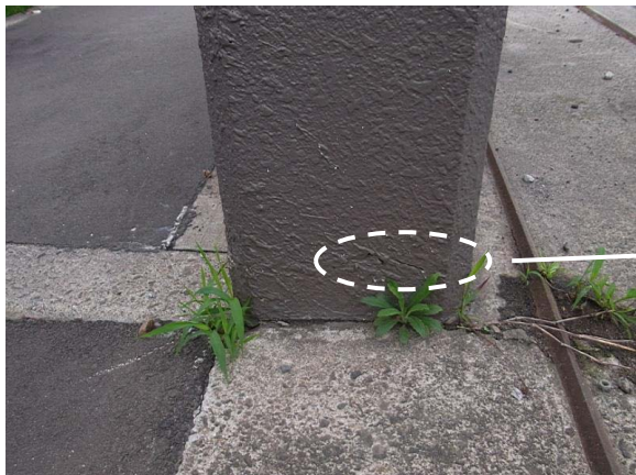
RC 塀に生じた曲げひび割れ
