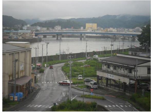
宮古市市街地（宮古漁協ビル南西側）の復旧様子
