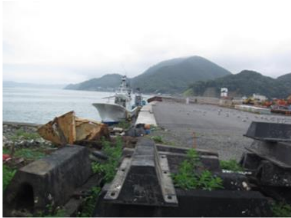
敷地前面の船着場
