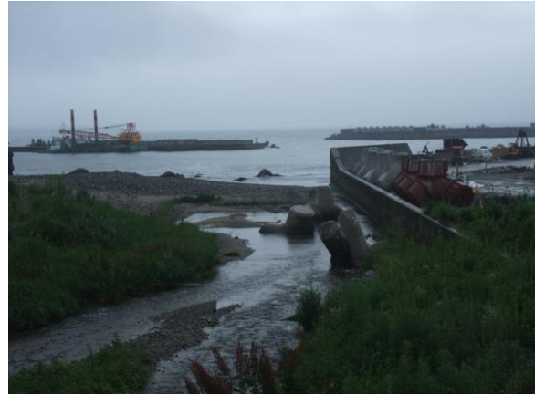
復旧工事中の防波堤
