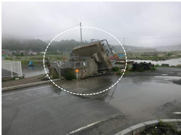
隣地の放置されている構造物
