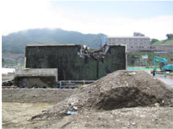
転倒した建物の屋上側の様子
