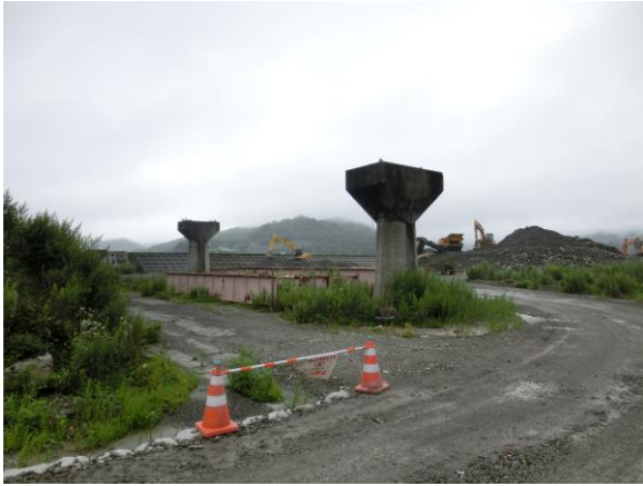
残存した橋脚部と落下した鉄橋は放置
