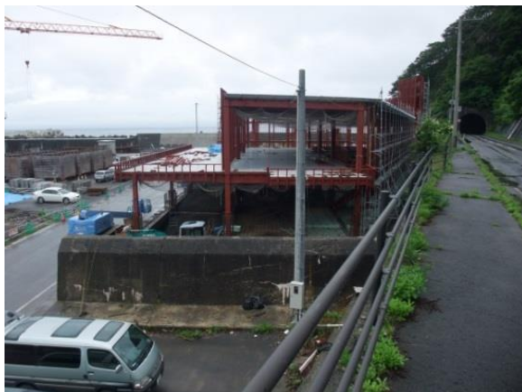
建設中の冷凍庫
