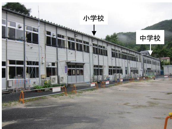
唐丹小学校・中学校の仮設校舎
