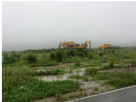
敷地周辺の整地作業
