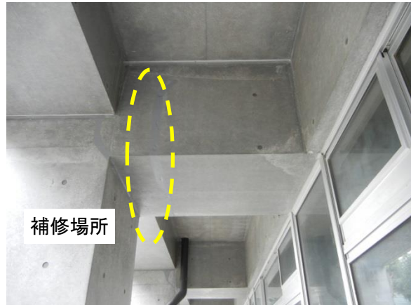
梁の補修状況
