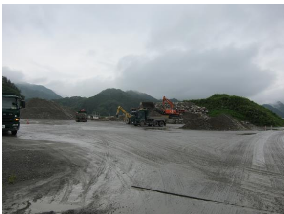
土砂の集積場として利用されている敷地
