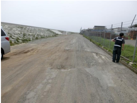
洗掘された道路の状況
