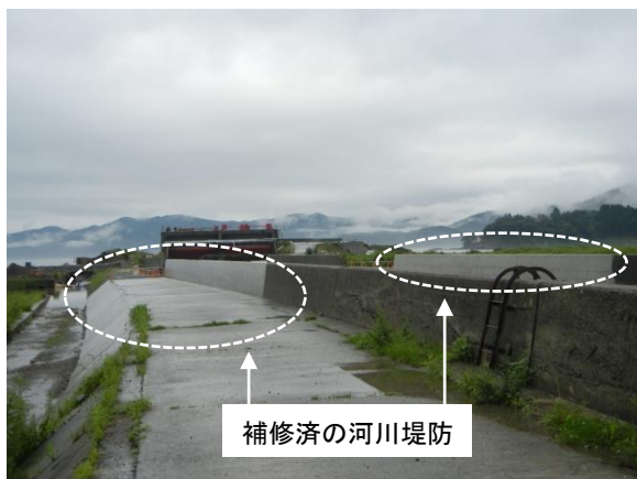
敷地から見た海側
