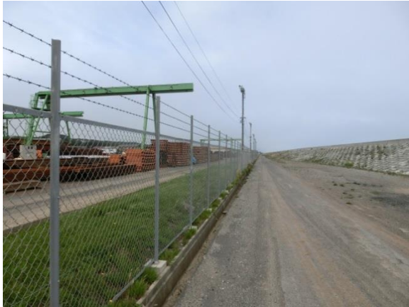
補修されたフェンス
