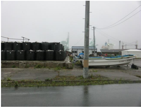
建物の敷地南側の様子
