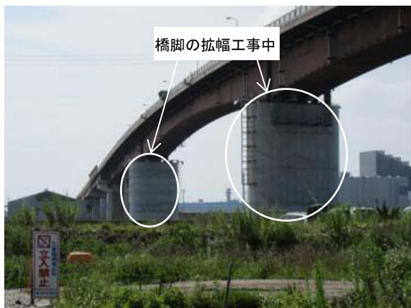
日和橋の状況
