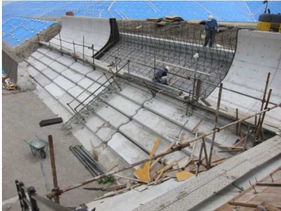
新設中の防潮堤
