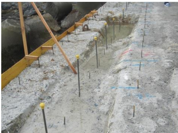
陸側の堤防補修工事状況 1
