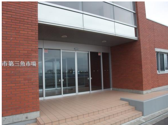
補修されたガラスドア
