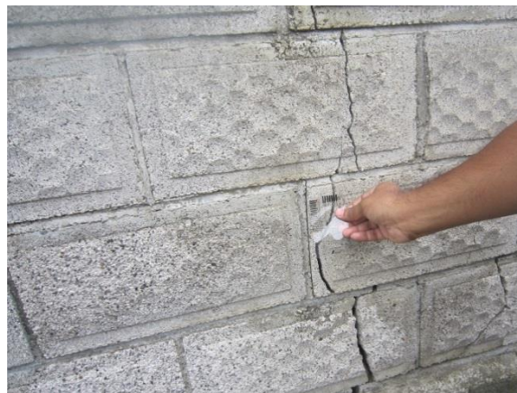
隣の敷地のCB塀に生じたひび割れ
