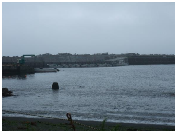
復旧工事中の堤防
