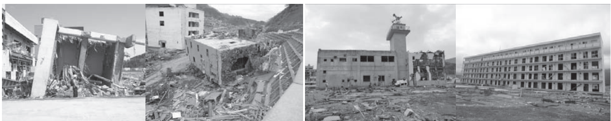
RC造2階建て建築物 女川町, 転倒
