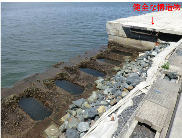
写真 3-2-5-3 構造体元設置場所
