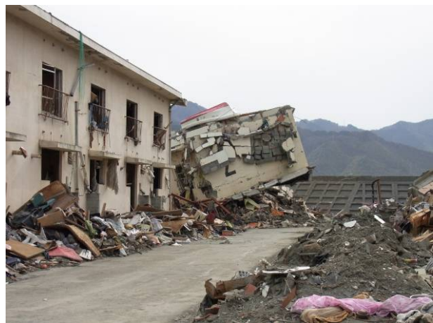
写真 3-12-3-4 転倒住宅 (7号棟) と その下敷きになった住宅 (5号棟)
