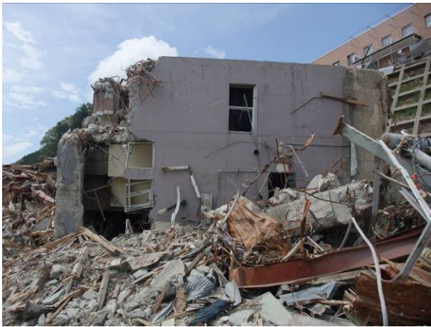
写真 3-18-4-3 南立面（通行のため4階部撤去済）
