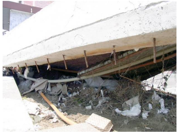
写真 3-22-3-4 CB 塀基礎のダボ鉄筋
