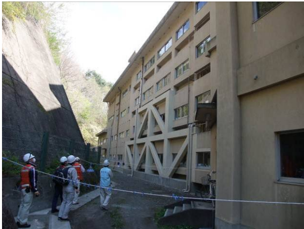
写真 3-13-22-3 建物背面の外付耐震補強の様子
