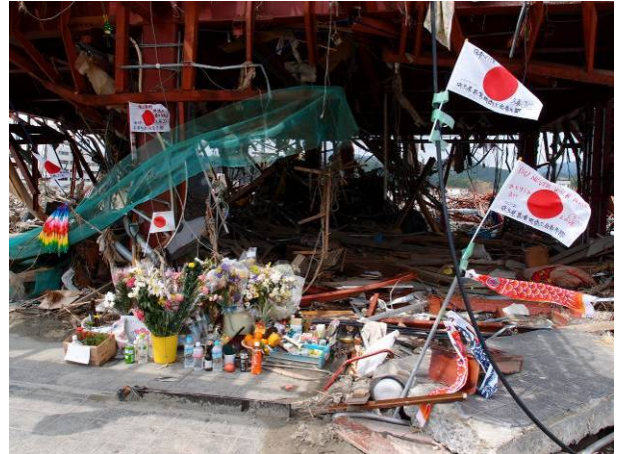
写真 3-17-1-2 防災対策庁舎の入口
