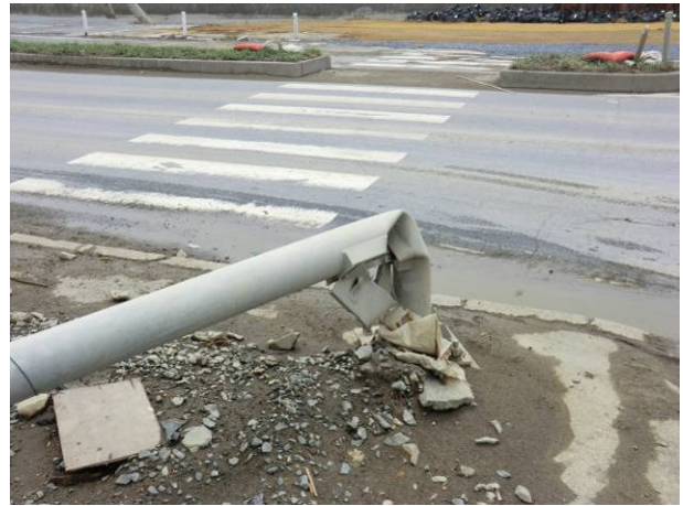
写真 3-19-3-6 直近の信号機（鉄柱）が折損
