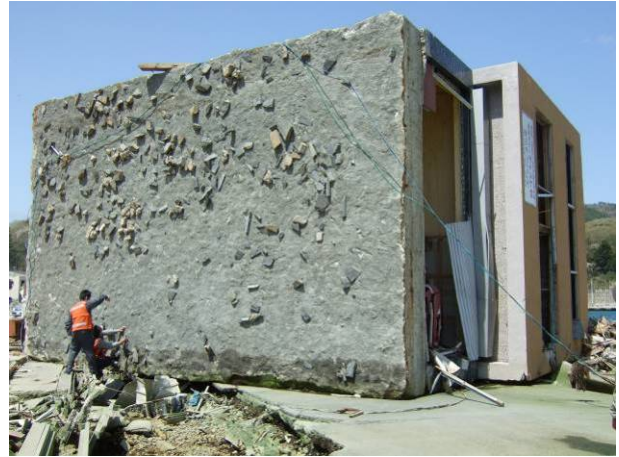
写真 3-18-5-2 底面 (直接基礎)
