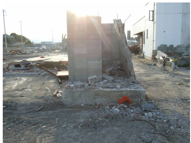
写真 3-31-2-2 CB 倉庫の東面
