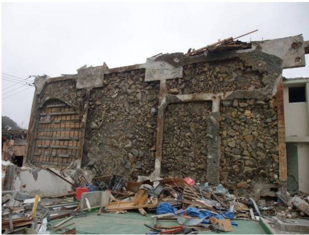
写真 3-18-1-3 冷凍倉庫底面（フーチングに杭頭跡有）
