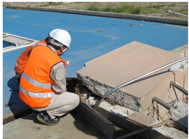
写真 3-30-17-2 転倒した東西方向の塀
