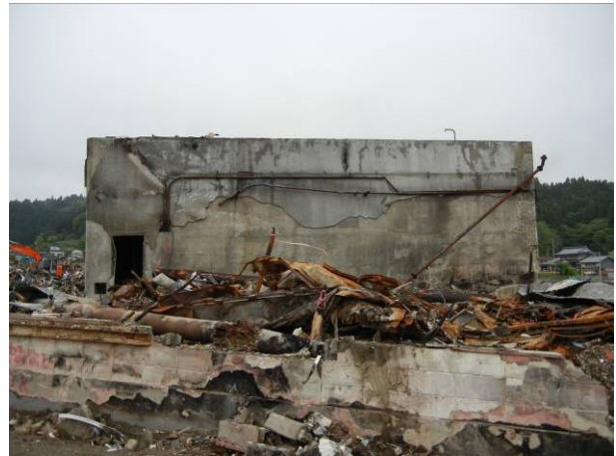
写真 3-16-1-2 汚水処理槽 (東立面)
