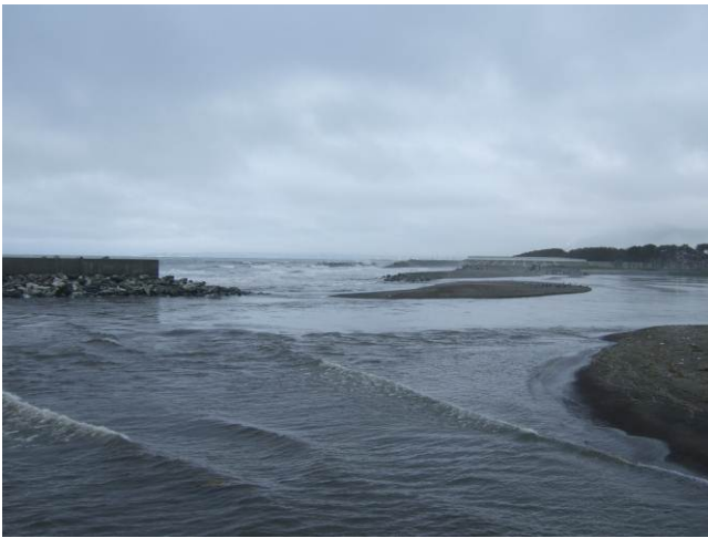
写真 3-1-2-1 堤防から南東
