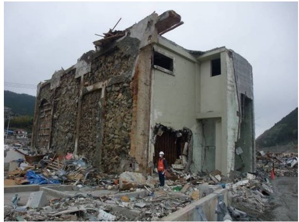
写真 3-18-1-2 冷凍倉庫北面と底面
