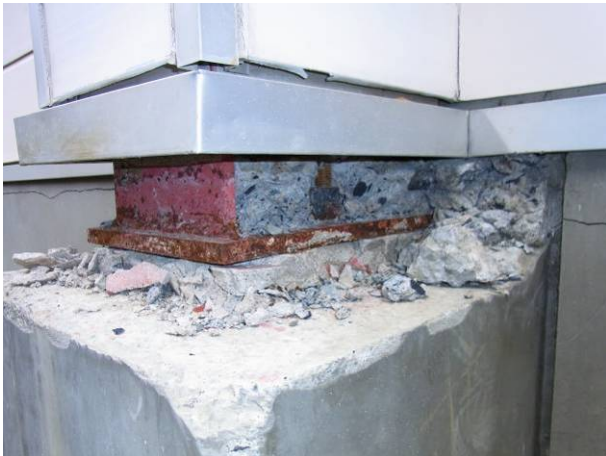
写真 3-32-2-9 柱脚部コンクリートをはつた跡
