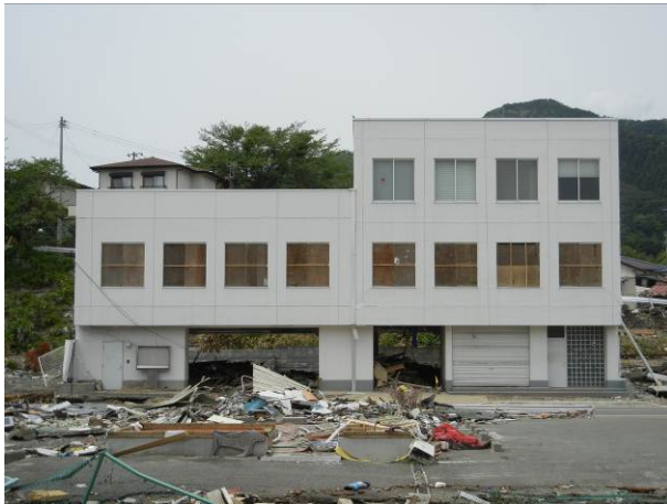
写真 3-14-14-1 建物正面の様子
