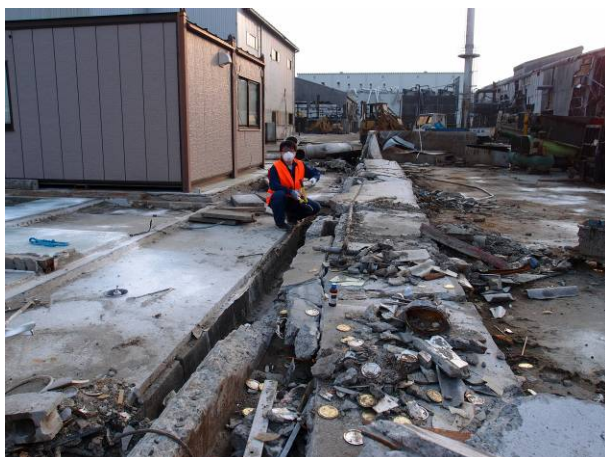
写真 3-19-6-1 転倒したRC塀
