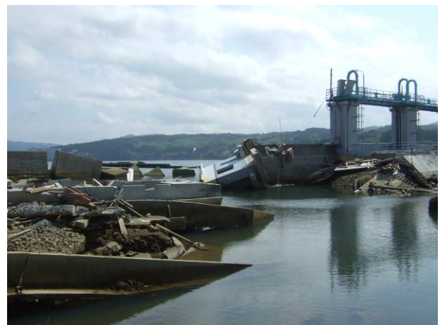
写真 3-17-7-1 建物の全景 (湾西端の河口位置) 写真 3-17-5-2 建物の転倒の様子 (湾東端の河口位置)
