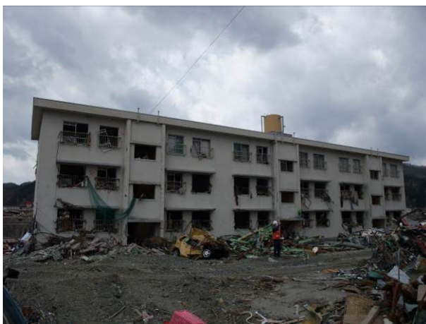
写真 3-13-3-1 片岸市営住宅の全景
