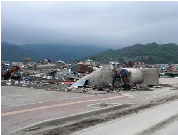
写真 3-12-5-1 なぎ倒される橋脚
