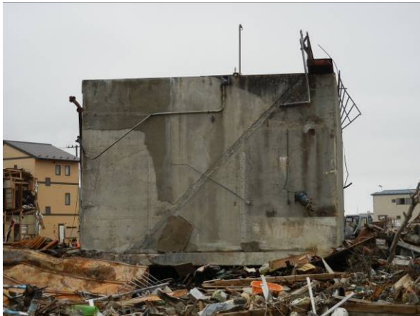
写真 3-16-1-1 汚水処理槽 (北立面)
