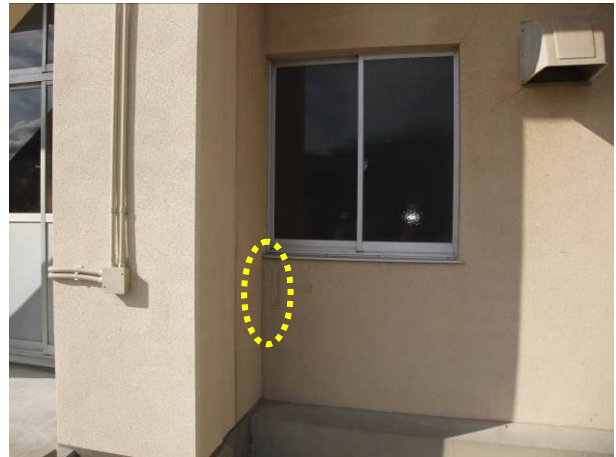
写真 3-13-22-4 耐震スリット設置の様子
