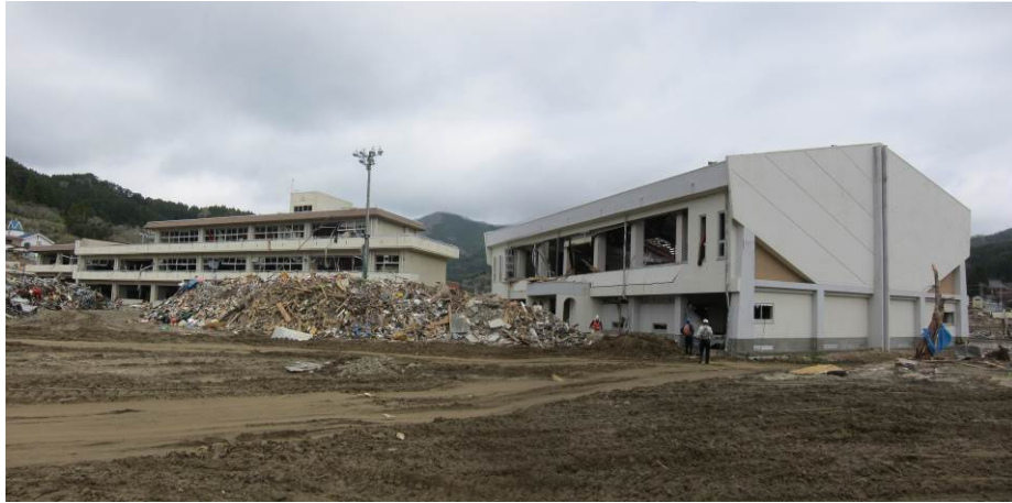
写真 3-14-1-1 建物全景（左：教室棟，右：体育館）
