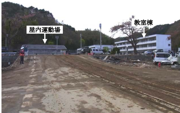
写真 3-9-2-1 田老第一中学校は僅かな高台にある
