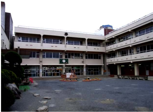
写真 3-32-1-1 山ノ目小学校校舎入口（東側）
