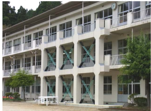
写真 3-32-2-4 校舎棟は耐震補強済み
