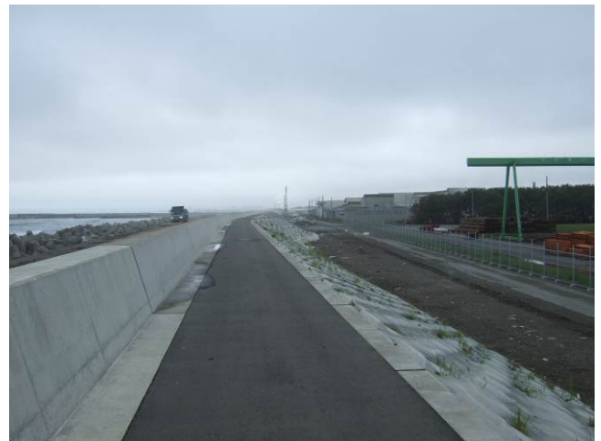
写真 3-1-1-2 堤防から南側
