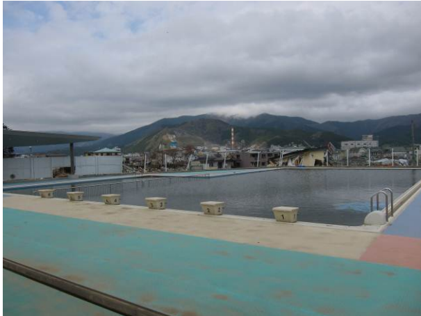
写真 3-14-5-1 プールとフェンスの様子
