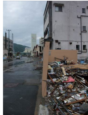
写真 3-13-11-2 CB 塀の傾斜の様子 (3°)
