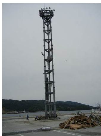
写真 3-14-24-1 港湾照明用鉄塔の全景
