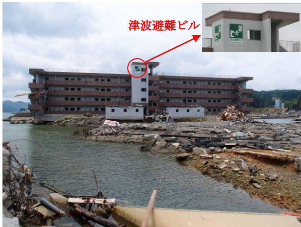
写真 3-17-3-1 町営住宅の全景および周辺の冠水の様子
