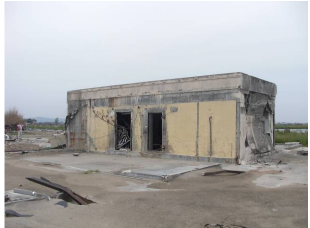
写真 3-29-1-2 CB造冷凍庫の南東面
