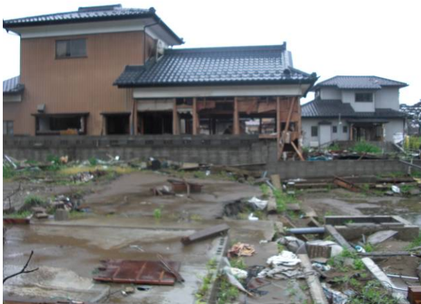
写真 3-20-site2-1 骨組が残存した木造住宅
