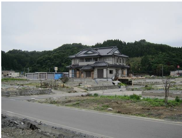
写真 3-11-3-1 残存した木造住宅
