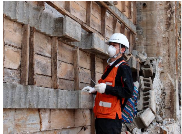
写真 3-18-1-6 冷凍倉庫基礎部材寸法計測中
