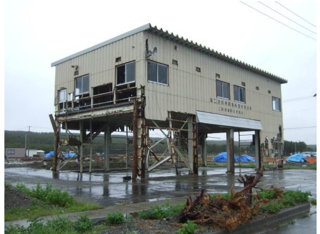
写真 3-1-site1-2 三沢漁港の建物
