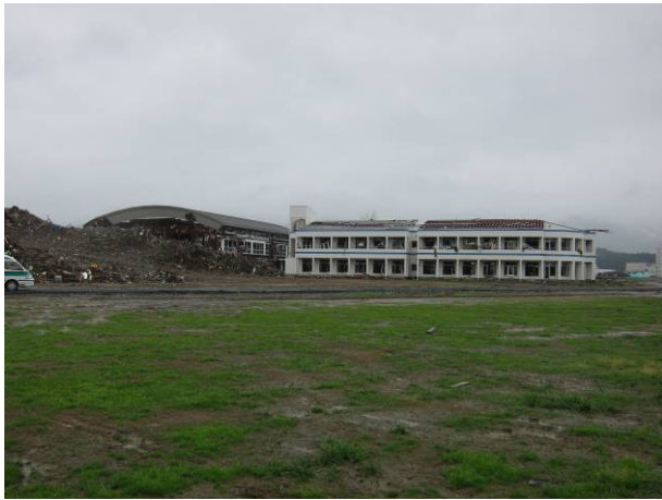
写真 3-15-9-1 周囲が洗掘された野外活動センター
