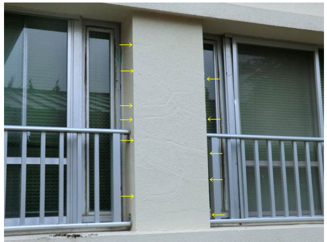
写真 3-2-11-2 ひび割れ補修跡
