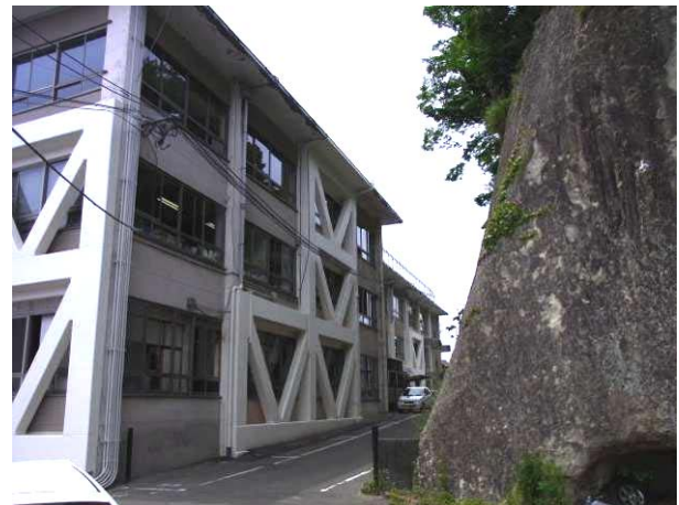
写真 3-22-4-2 市役所裏に崖がある傾斜地
