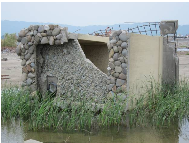
写真 3-29-2-1 転倒した平屋の底面
