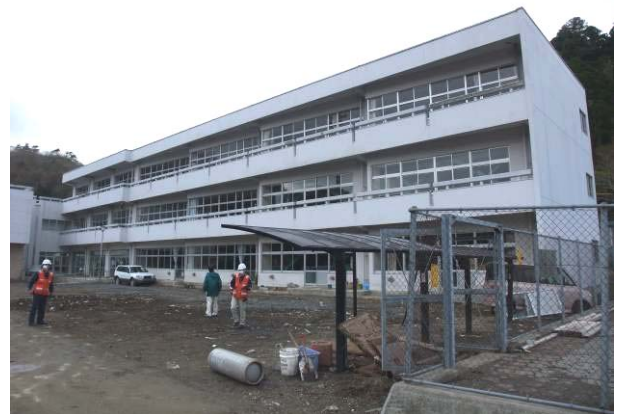
写真 3-9-2-2 田老中学校教室棟全景
