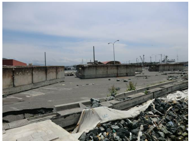
写真 3-2-5-4 構造体3ユニット分
