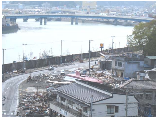
写真 3-10-site1-2 越流による被害があるも沿岸部のみ
