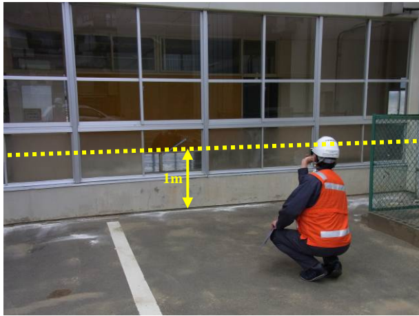
写真 3-14-4-3 1階の床上1mから水痕観測
