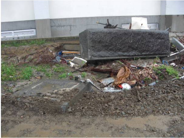
写真 3-14-31-1 転倒した門柱
