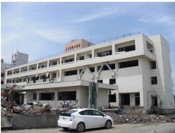
写真 3-17-4-1 志津川病院の全景および被害状況
