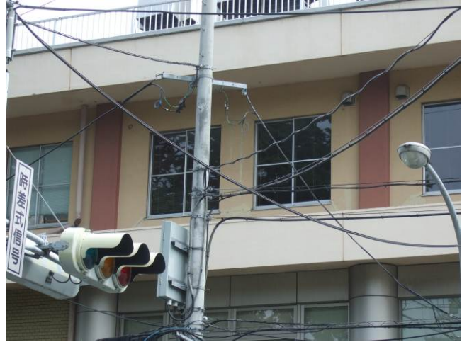
写真 3-2-15-4 定着破壊補修跡
