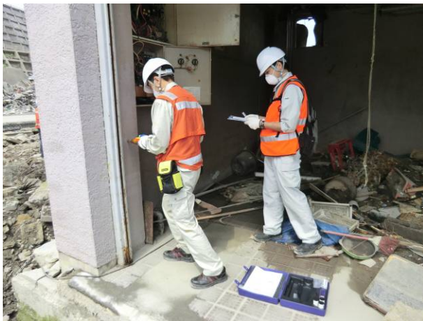
写真 3-18-3-3 柱部材のシュミット試験
