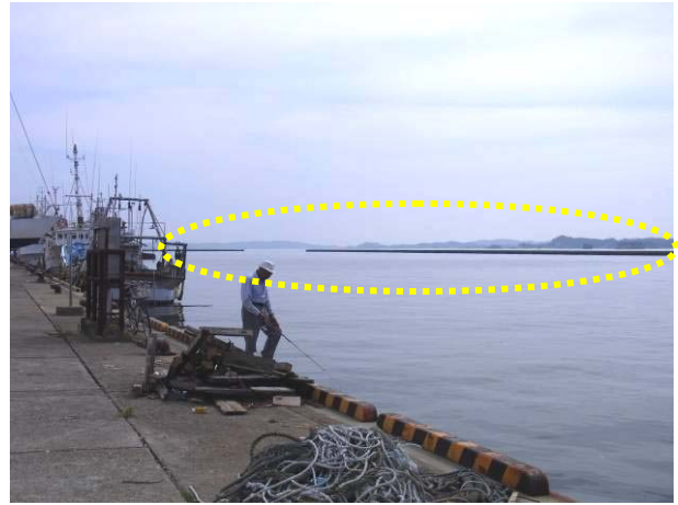
写真 3-22-site1-2 チリ地震後に設置された防波堤
