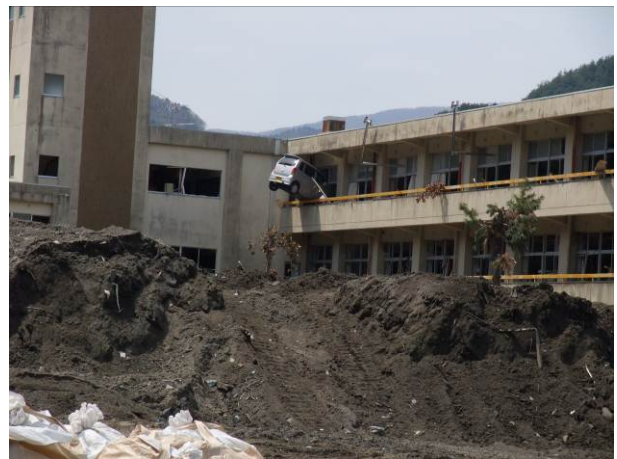
写真 3-13-7-2 津波により3階に突っ込んだ車
