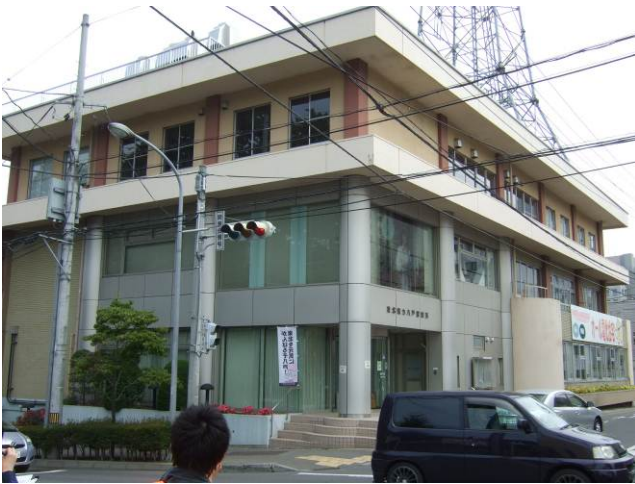
写真 3-2-15-1 TH 電力八戸営業所
