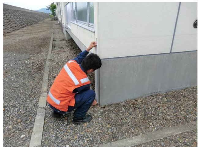
写真 3-3-1-2 浸水深の計測
