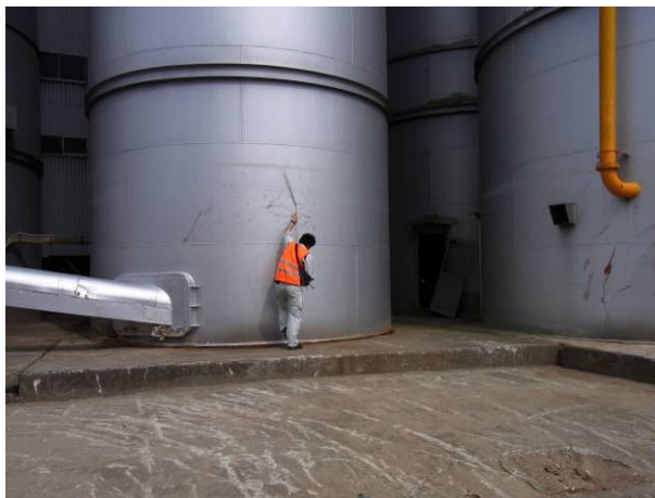
写真 3-25-5-5 浸水深の計測
