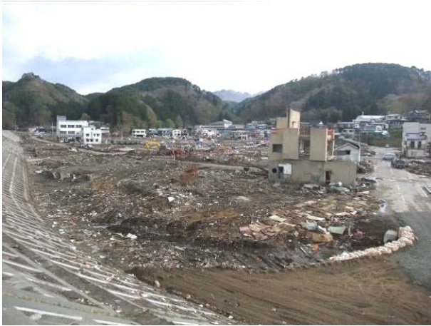
写真 3-9-1-3 防潮堤を越流した津波による被害
