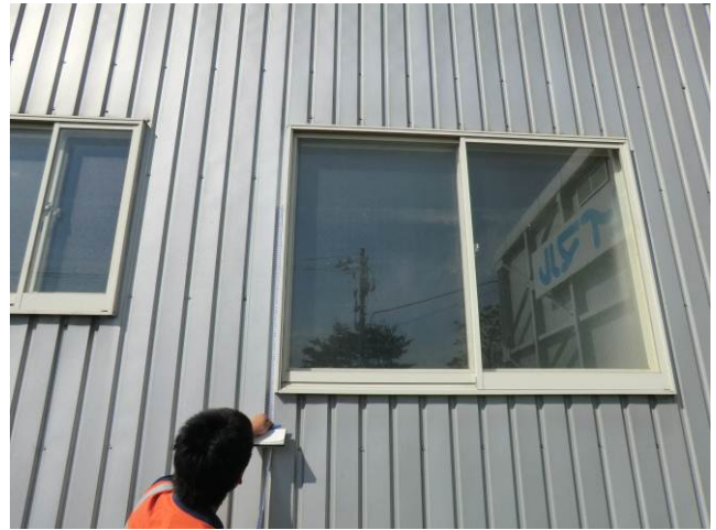
写真 3-2-8-4 浸水深の計測
