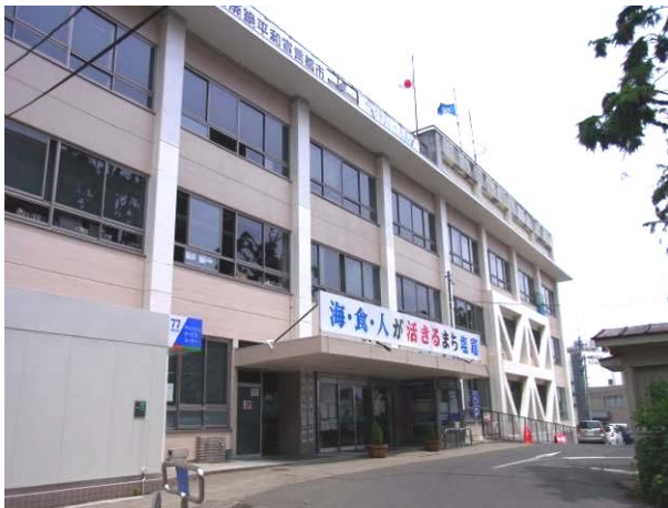
写真 3-22-4-1 塩竈市役所全景
