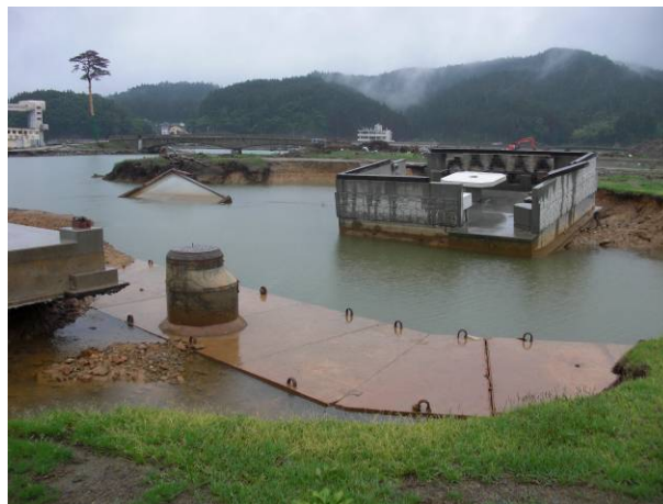
写真 3-15-9-3 転倒したバーベキュー広場
