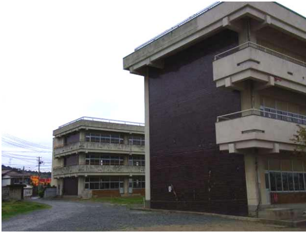
写真 3-32-1-3 山ノ目小学校校舎（西側）
