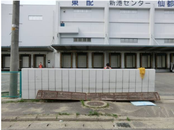
写真 3-25-3-1 ST 冷蔵前 RC 塀 (西)
