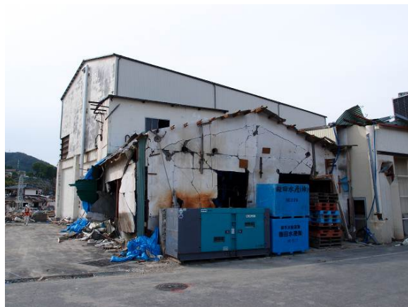
写真 3-14-28-1 KT 水産工場の全景
