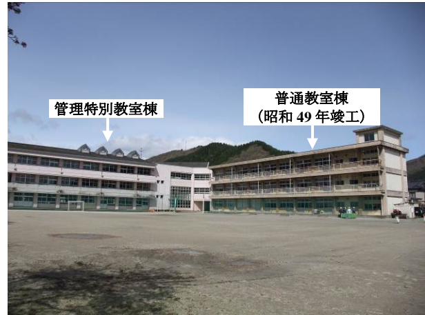
写真 3-13-19-2 運動場から見た建物の全景
