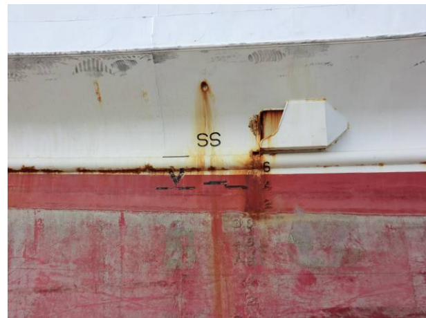
写真 3-19-4-2 通常時海面下部分の深さ=約 3.1m
