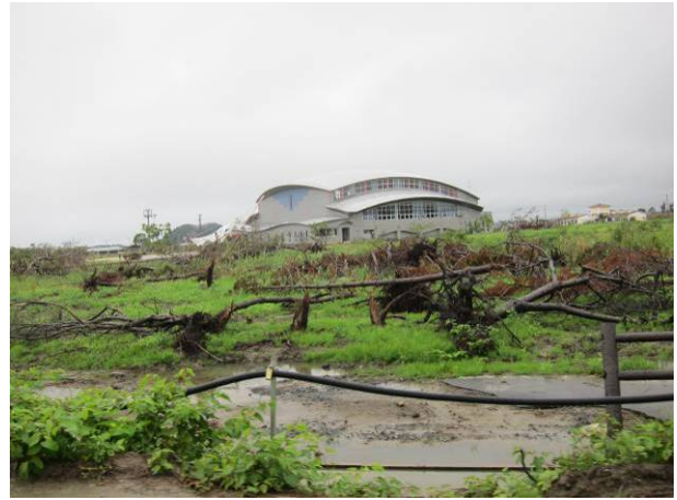
写真 3-20-site1-2 周辺の被災状況
