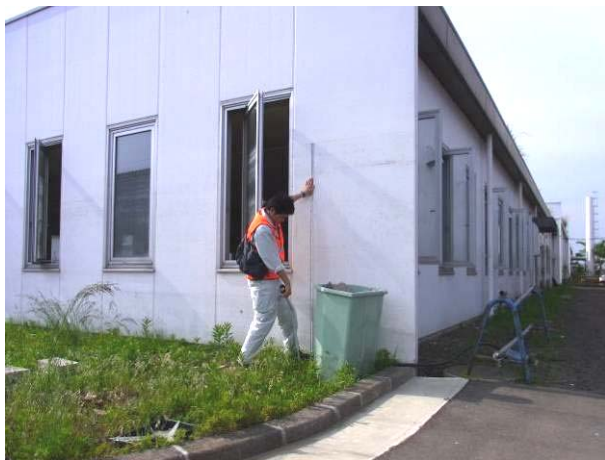
写真 3-25-8-1 浸水深の計測
