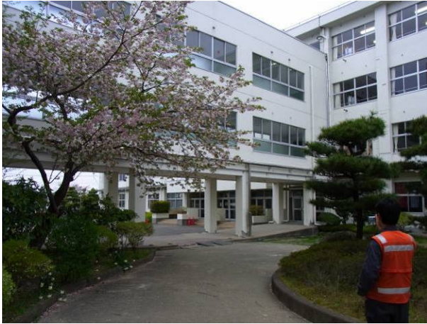
写真 3-33-2-3 ピロティ形式の渡り廊下部分
