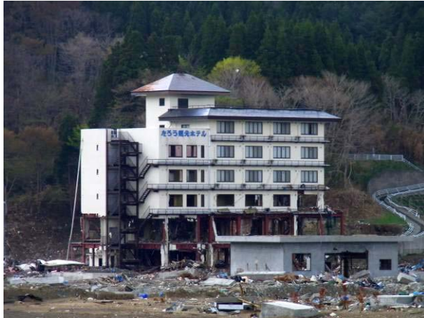
写真 3-9-3-1 T観光ホテル全景
