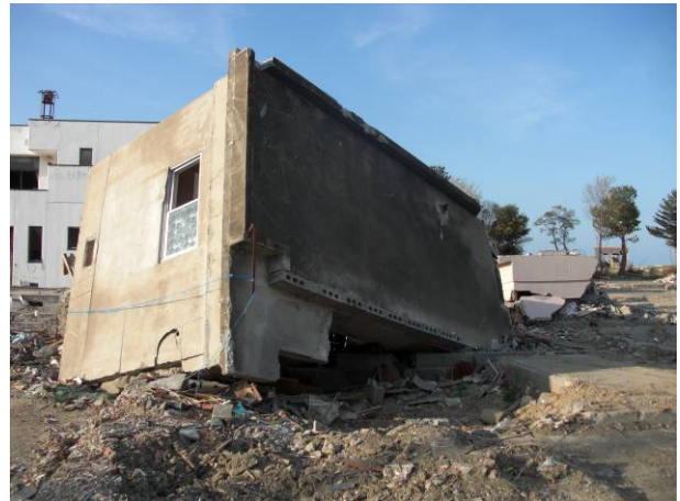
写真 3-31-3-2 平屋住宅の屋根面
