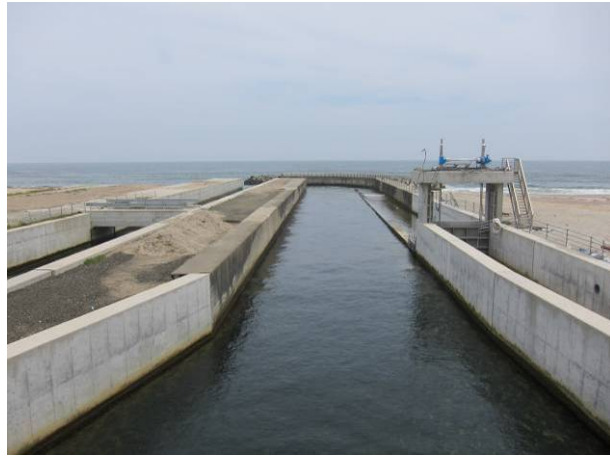
写真 3-30-23-3 水門と海の間にある構造物
