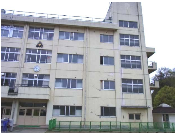
写真 3-33-3-1 西山中学校・教室棟
