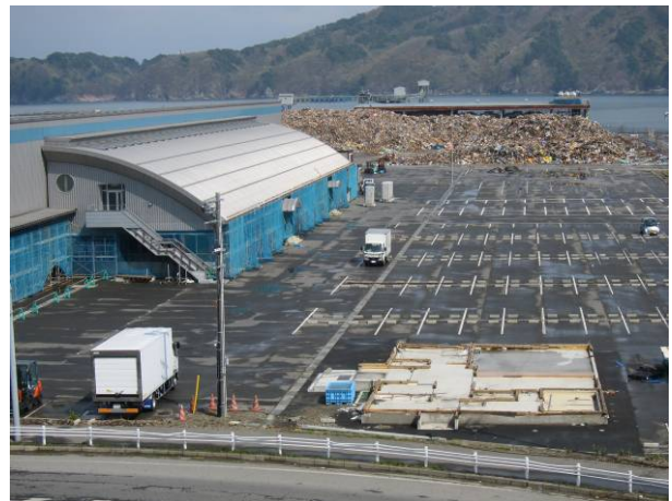
写真 3-10-site1-4 左の鉄骨造残存／右の木造流失
