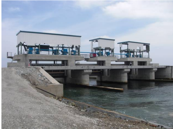
写真 3-30-23-1 牛橋河口の水門
