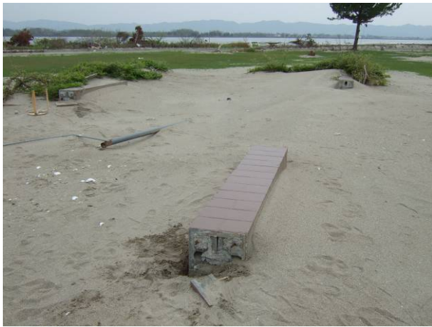
写真 3-29-7-1 転倒したCB柱
