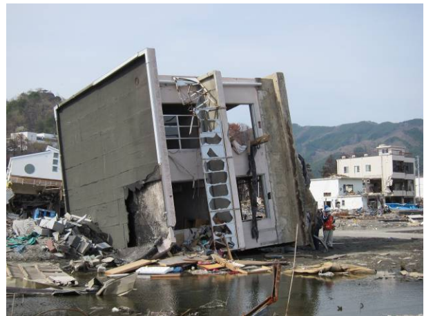
写真 3-12-2-2 転倒した RC 住宅（南面）
