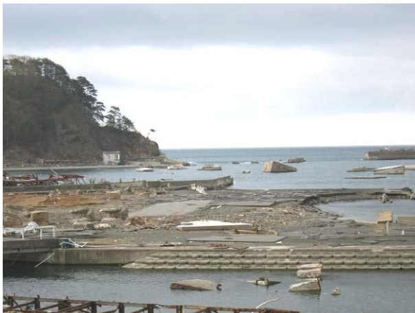
写真 3-9-1-1 沖合の堤防がいくつも倒されている
