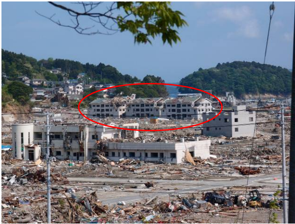
写真 3-17-7-1 RC造3階建て集合住宅の全景
