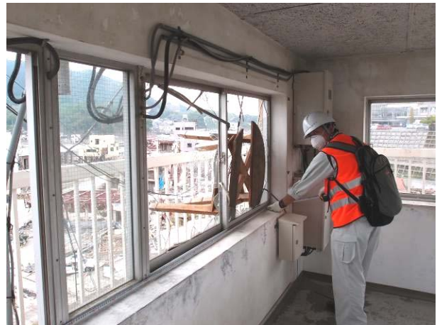
写真 3-18-9-6 開口寸法計測中
