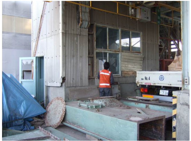
写真 3-2-6-4 浸水深の計測
