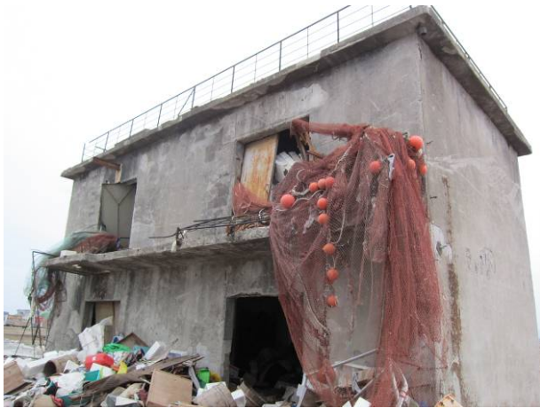
写真 3-27-5-1 残存した CB 造 2 層建物の南東面
