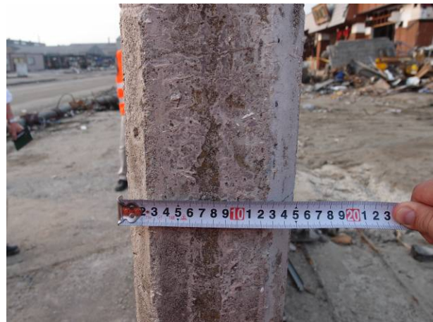
写真 3-19-7-2 塀の厚さ計測 (150mm)
