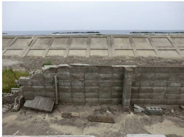
写真 3-26-1-4 CB 塀には控え壁がある
