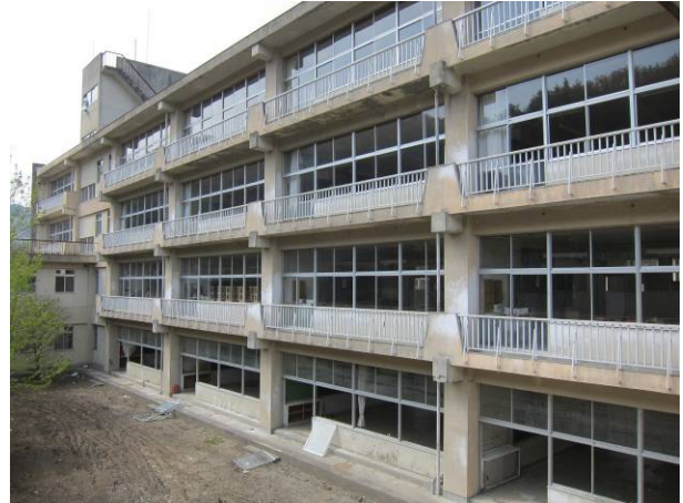
写真 3-12-1-2 RC造4階建て教室棟
