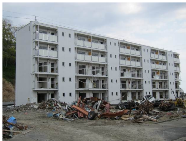
写真 3-13-1-1 雇用促進住宅片岸宿舎の全景
