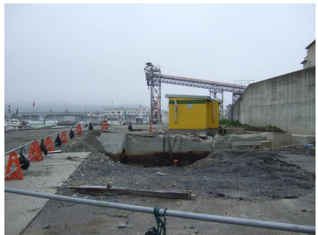
写真 3-3-site1-2 久慈港の湾奥
