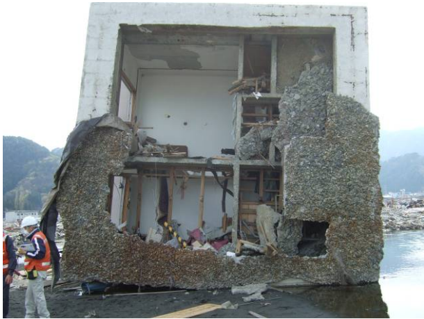
写真 3-12-2-3 転倒した RC 住宅（底面）
