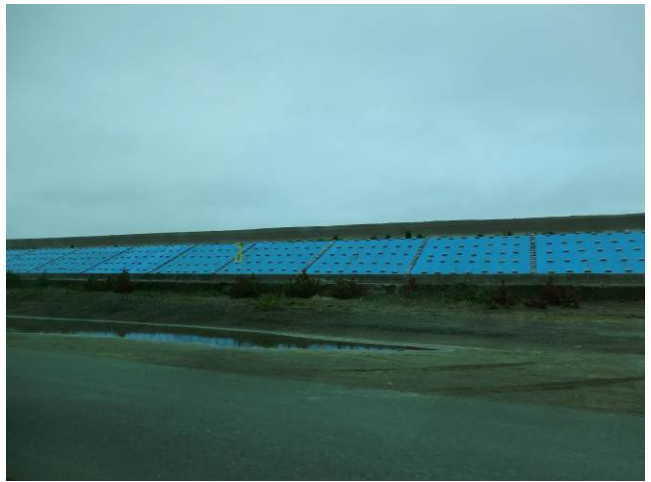
写真 3-1-3-4 堤防復旧工事
