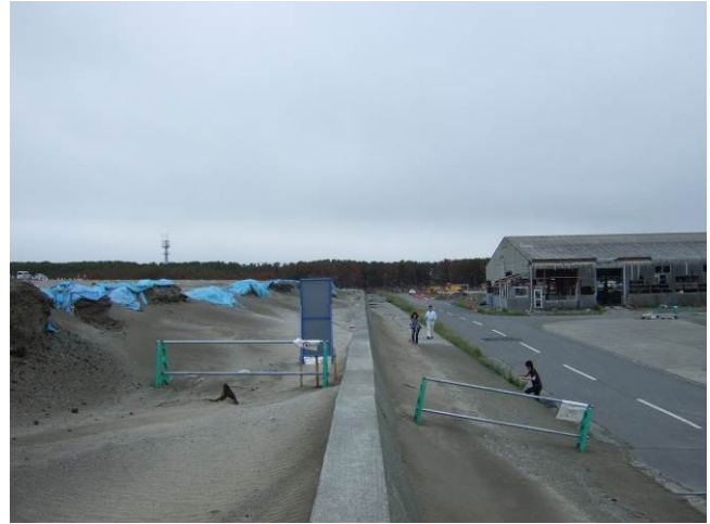
写真 3-1-3-2 堤防から陸地側の津波通過跡
