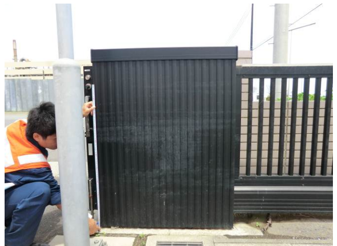
写真 3-2-3-2 浸水深の計測
