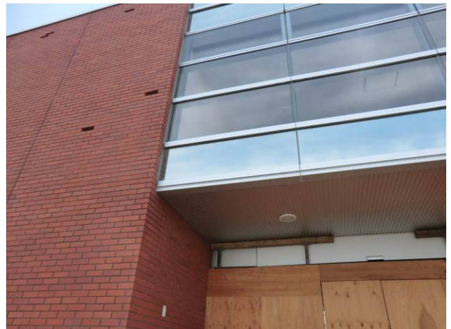
写真 3-2-4-2 受圧面水痕と跳ね
