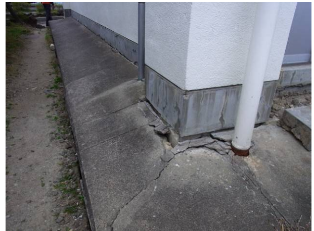
写真 3-33-2-6 地盤変状に伴う犬走りの被害
