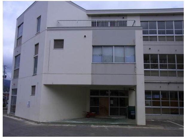
写真 3-14-4-4 耐震スリット施工済み
