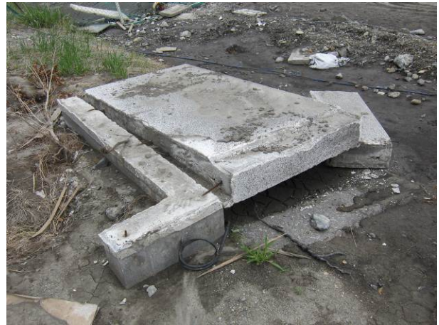
写真 3-14-19-2 転倒した方の塀
