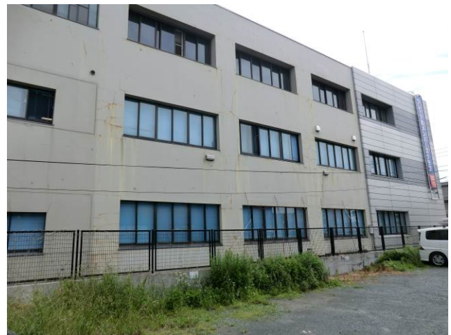
写真 3-2-19-2 NTT 八戸支店第2棟
