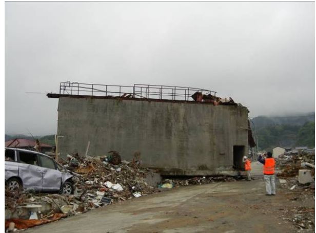
写真 3-16-1-4 汚水処理槽（西立面）
