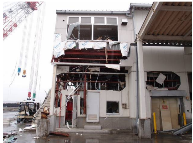
写真 3-16-2-4 隣接建物から浸水深を計測
