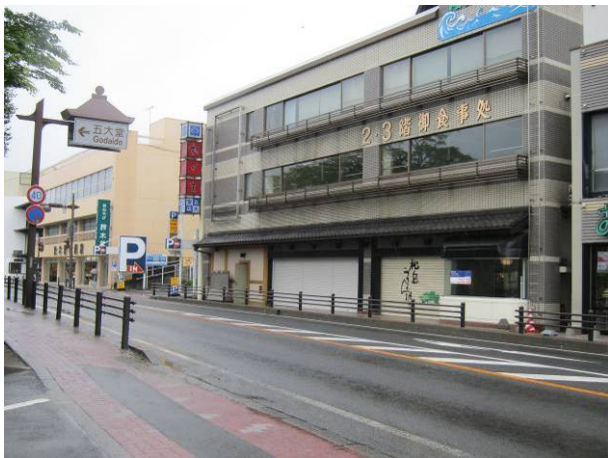
写真 3-21-site1-1 国道45号線沿いの様子
