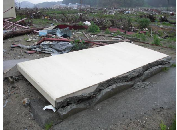
写真 3-15-1-6 転倒した RC 塀
