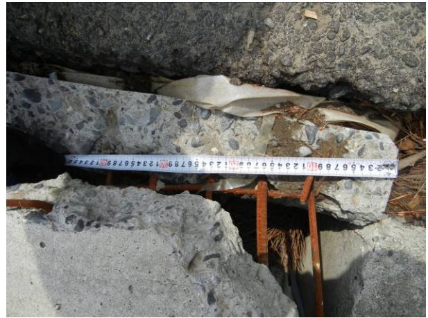
写真 3-19-2-2 擁壁縦筋径の計測
