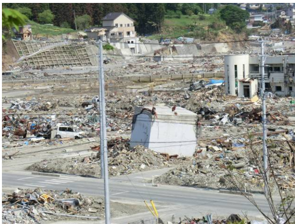
写真 3-17-6-1 RC 造平屋構造物の全景
