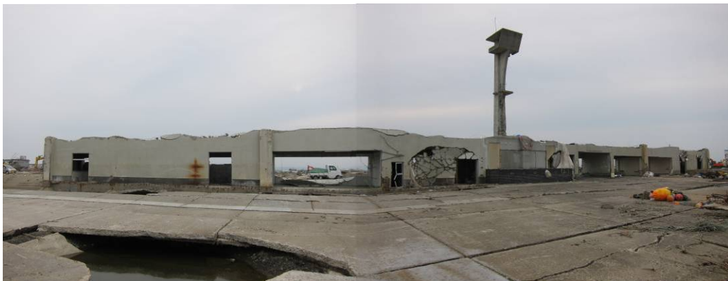
写真 3-27-2-1 東 (海側) から見た魚市場全景
