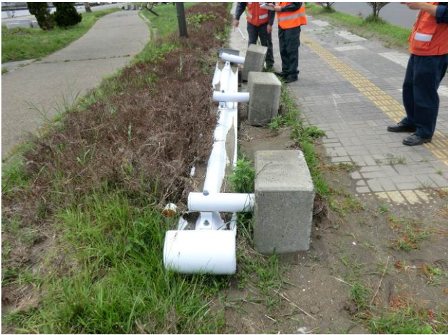
写真 3-2-2-1 転倒したガードレール
