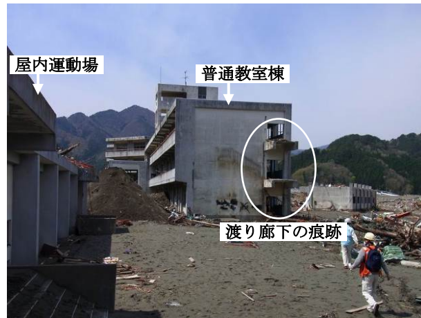
写真 3-13-6-8 普通教室棟と屋内体育館の渡り廊下の流失
