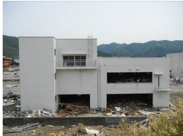
写真 3-14-14-2 建物背面の様子
