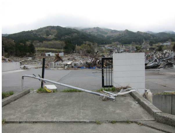
写真 3-14-3-1 ブロック塀の被害の様子
