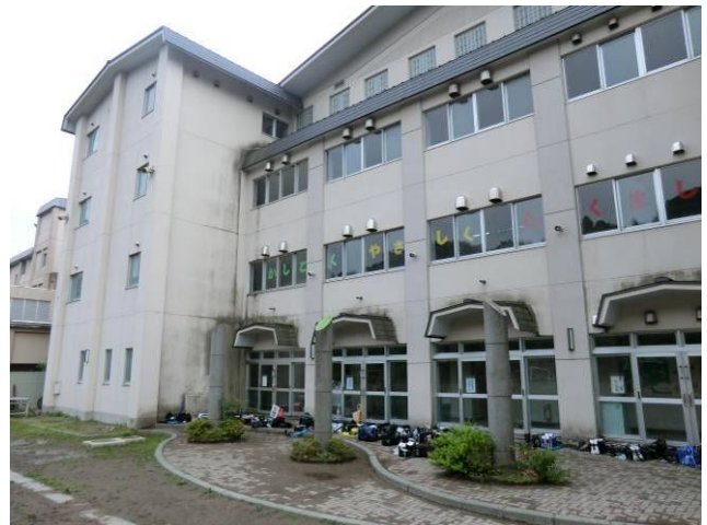
写真 3-2-10-2 根岸小学校南面
