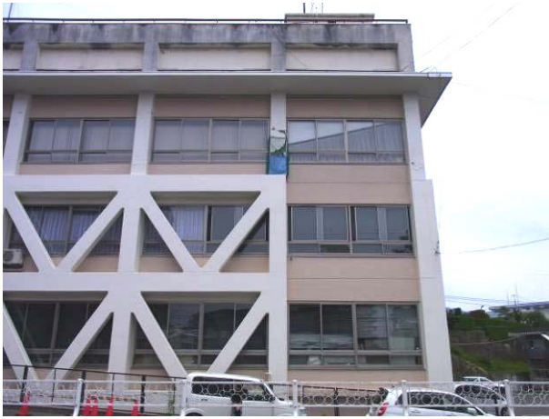
写真 3-22-4-3 外付耐震補強法による補強
