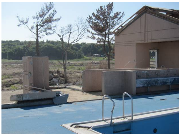
写真 3-30-17-1 プールサイドの RC 塀全景
