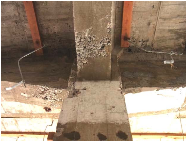
写真 3-18-8-3 梁下端を見上げる
