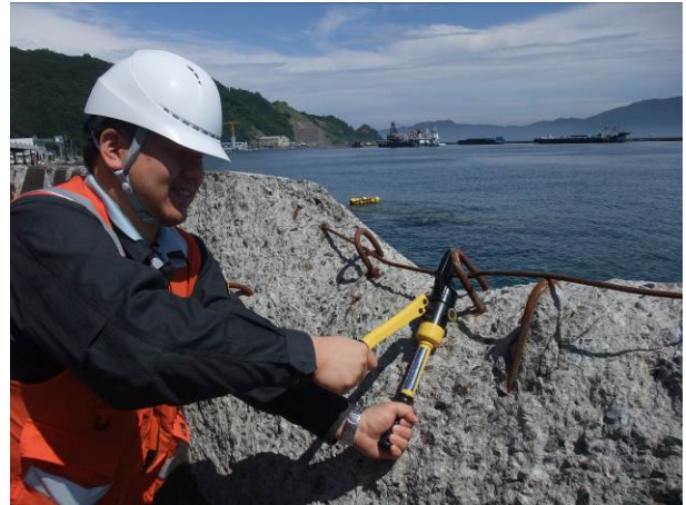
写真 3-13-17-2 堤防の鉄筋入手
