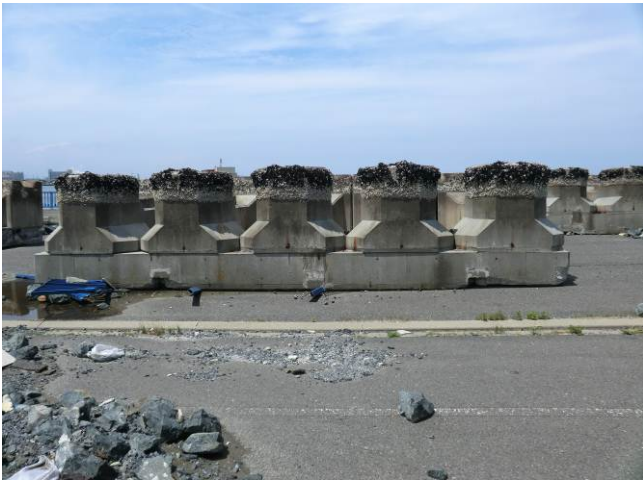
写真 3-2-5-1 道路と海との間の構造体（上下転倒）
