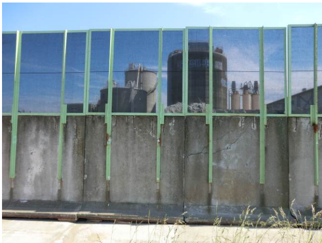
写真 3-2-7-1 RC 塀受圧面
