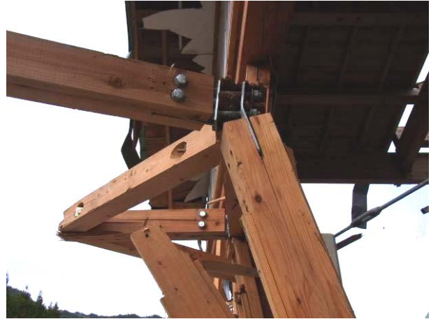
写真 3-8-1-4 集成材接合金物が塑性変形している
