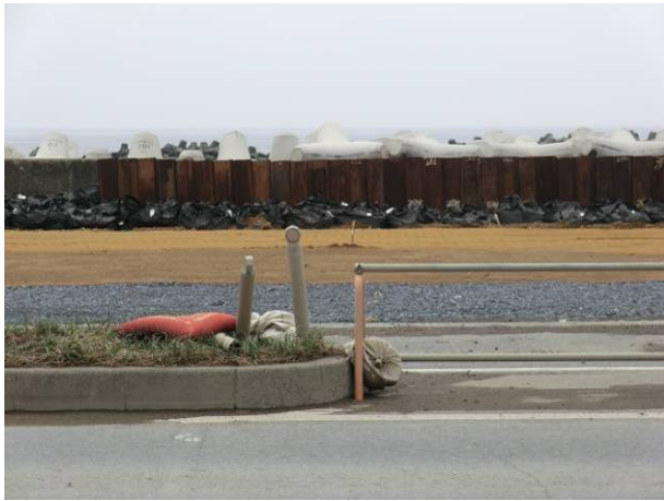
写真 3-19-3-5 直近の堤防破損（鋼矢板で応急復旧）
