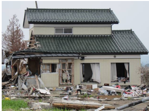
写真 3-29-4-4 背面の津波痕跡を計測した建物
