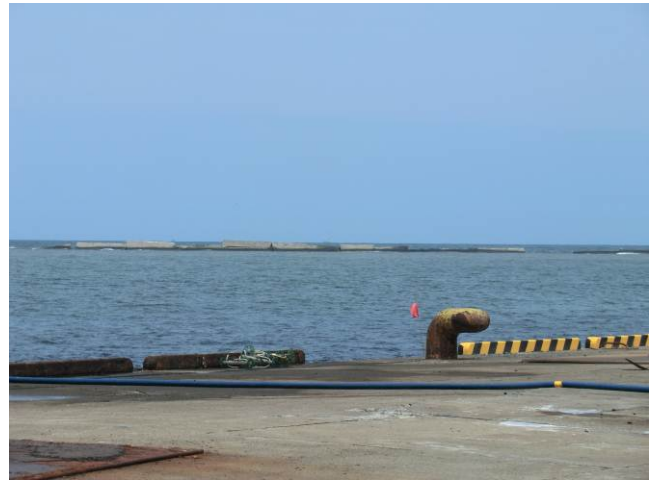
写真 3-2-1-4 破壊された防波堤
