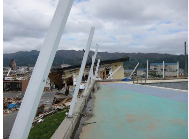
写真 3-14-5-2 プールフェンスの被害の様子
