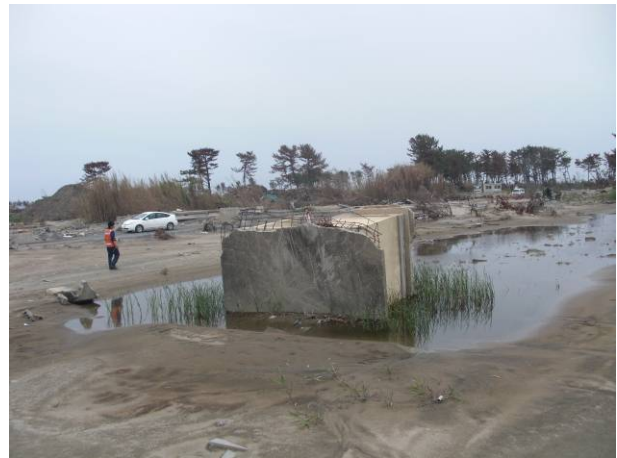
写真 3-29-2-2 転倒した平屋の上面
