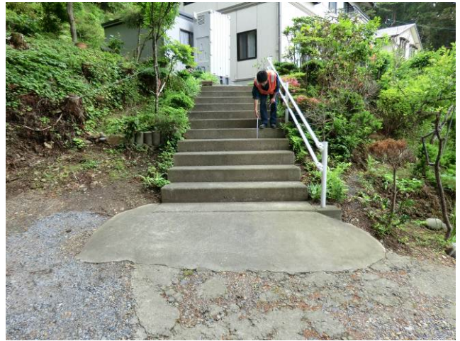
写真 3-7-8-2 浸水深の計測
