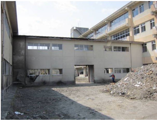
写真 3-12-1-5 鉄骨造2階建て渡り廊下棟
