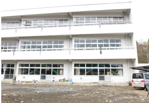
写真 3-9-2-3 教室棟はブレースによる耐震補強済
