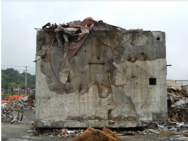
写真 3-16-1-3 汚水処理槽（南立面）
