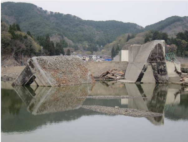
写真 3-12-4-1 防潮堤（左：転倒，右：残存）
