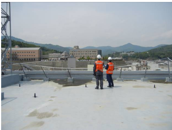
写真 3-18-12-3 病院側からなぎ倒されるフェンス
