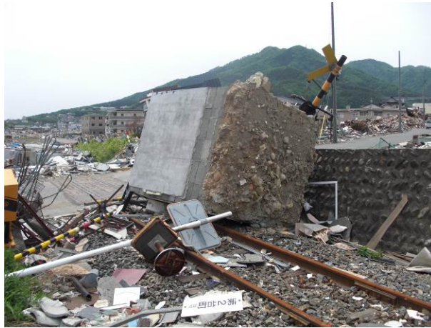
写真 3-14-20-1 転倒した CB 造建物の様子
