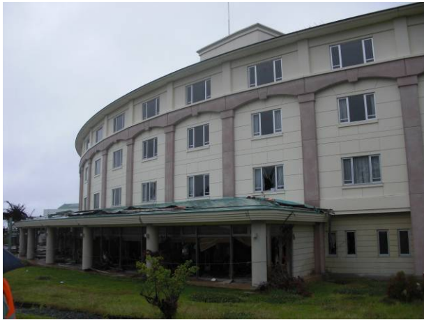
写真 3-20-1-1 かんぼの宿の窓ガラス破損
