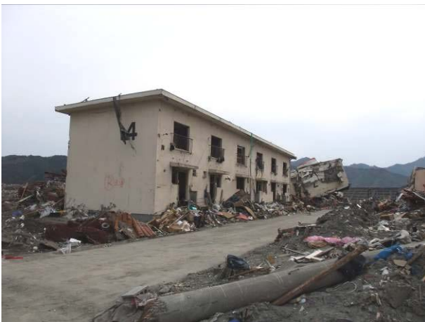
写真 3-12-3-3 残存住宅 (4号棟)
