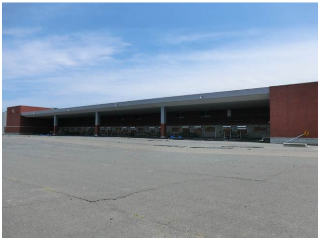
写真 3-2-4-1 八戸市水産会館
