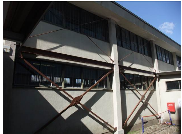
写真 3-13-21-8 ブレース補強済みの屋内体育館
