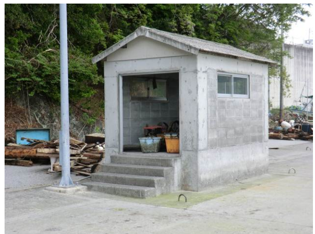
写真 3-14-30-1 妻面⊥海岸線の棟の様子
