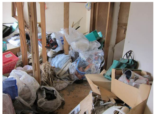
写真 3-13-3-2 片岸市営住宅 3 階の内部の様子
