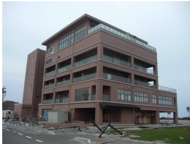
写真 3-29-6-1 浸水深を計測した亙理温泉鳥の海の側面, 背面
