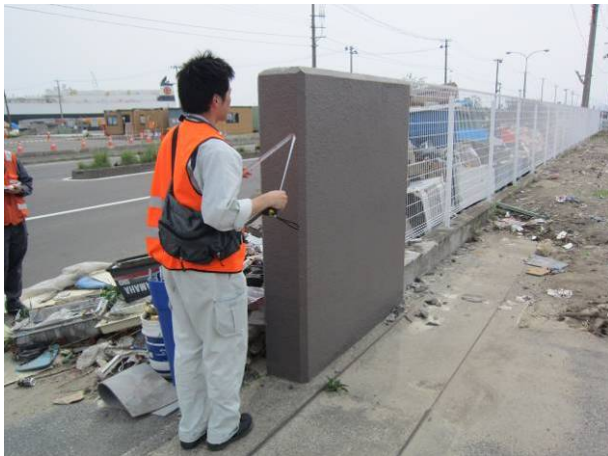
写真 3-25-2-1 ST 冷蔵前の RC 塀
