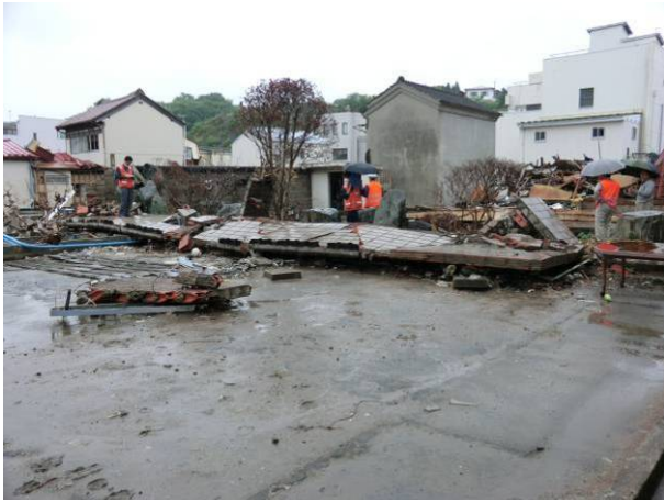
写真 3-16-3-1 転倒したレンガ・ブロック塀全景
