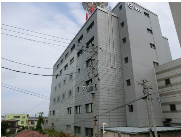
写真 3-2-19-1 NTT 八戸支店第3棟
