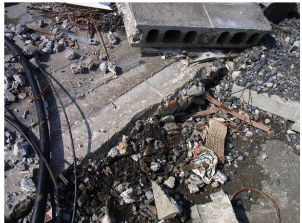
写真 3-13-18-2 地中に埋まっていた基礎部の様子
