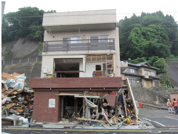
写真 3-13-15-1 建物受圧面の様子
