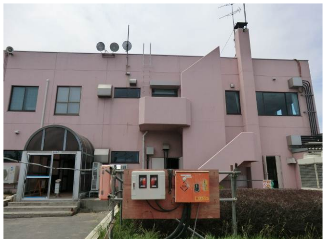
写真 3-2-1-2 八戸港フェリーターミナル東面
