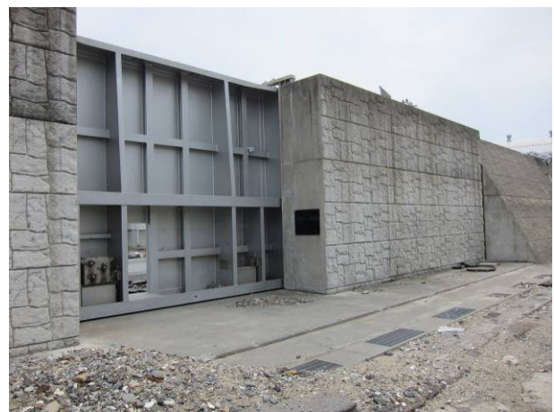
写真 3-11-1-2 残留した厚さ 1200mm の防潮堤
