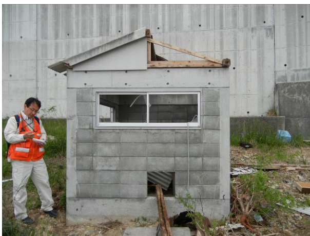
写真 3-14-29-1 妻面//海岸線の棟の様子
