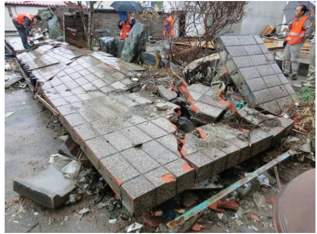
写真 3-16-3-2 転倒したレンガ・ブロック塀
