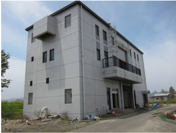
写真 3-30-22-3 山本浄化センターの西側の建物
