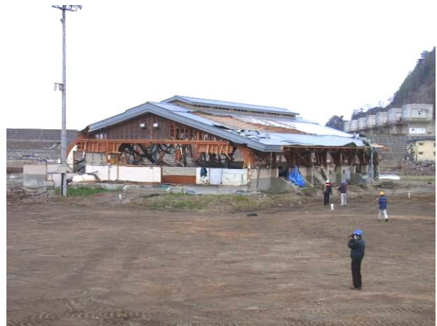
写真 3-8-1-2 プール棟全景
