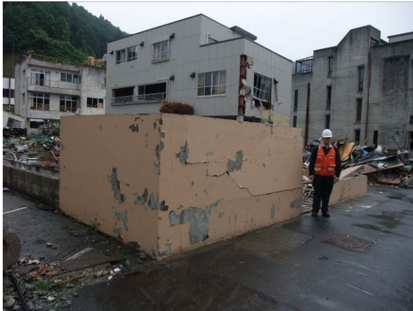
写真 3-13-11-1 CB 塀の全景
