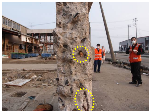
写真 3-19-7-4 RC塀断面に見える横筋の様子
