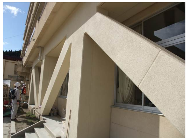
写真 3-13-22-2 建物正面の外付耐震補強の様子
