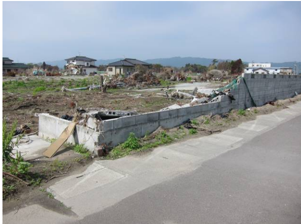
写真 3-30-19-1 転倒した RC 塀
