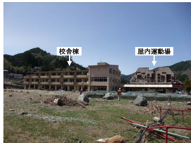
写真 3-13-4-2 被災後の校舎と屋内体育館の様子
