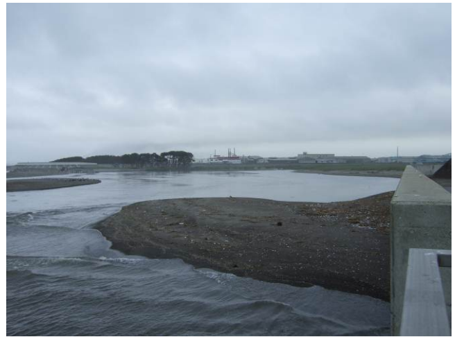
写真 3-1-2-2 堤防から南側
