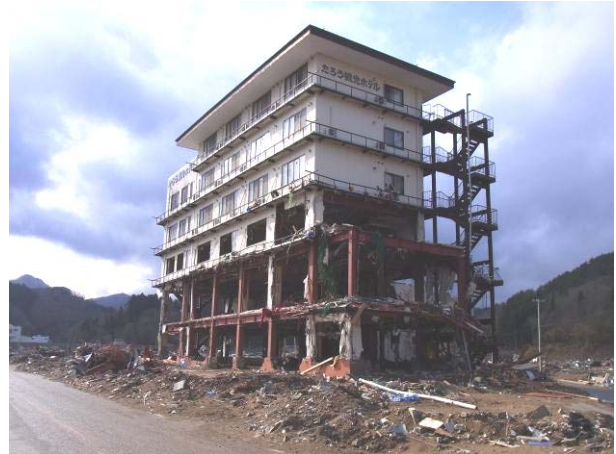
写真 3-9-3-2 3階まで浸水した
