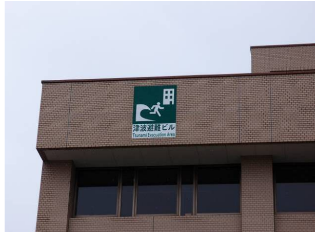
写真 3-16-4-2 津波避難ビルに指定されている
