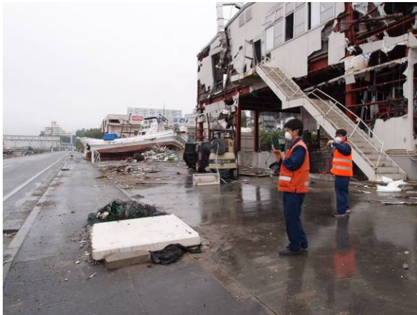
写真 3-16-2-1 引き波で転倒した RC 塀
