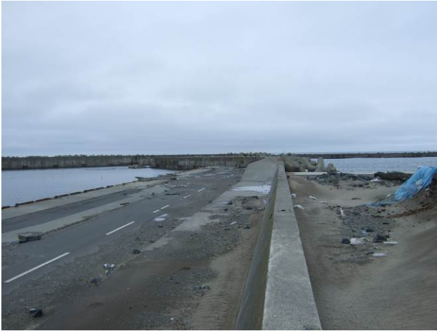
写真 3-1-3-1 堤防から東側
