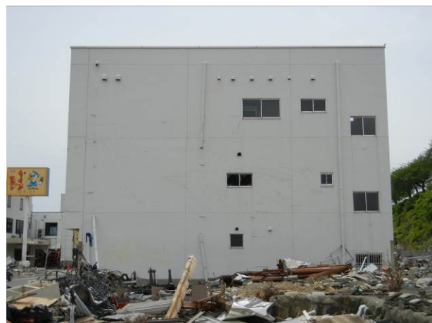
写真 3-14-14-4 建物右側面の様子
