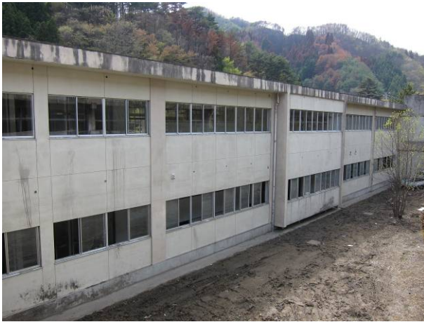
写真 3-12-1-3 RC造2階建て特別教室棟
