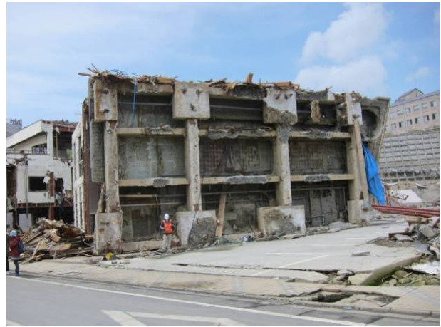
写真 3-18-2-2 底面（フーチングに杭頭跡有）
