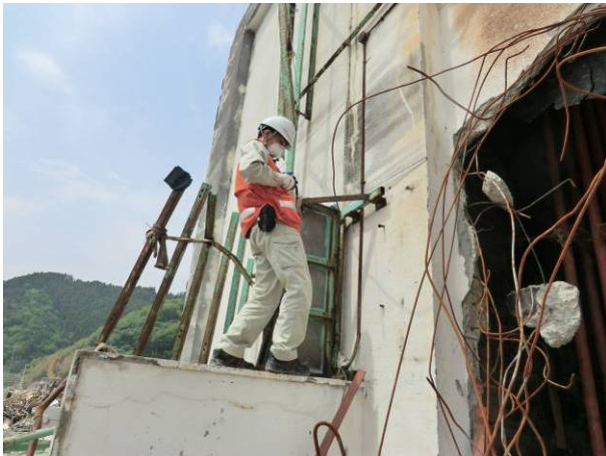
写真 3-18-1-5 冷凍倉庫寸法計測中
