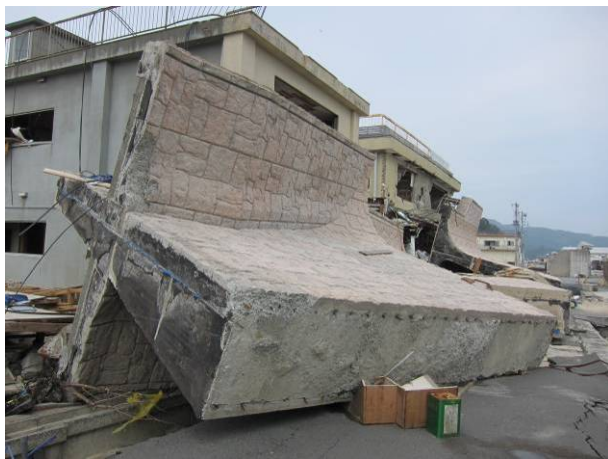
写真 3-11-2-1 流出した防潮堤
