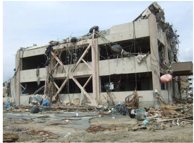
写真 3-17-1-2 ブレースの補強の様子
