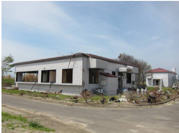
写真 3-30-22-1 山本浄化センターの海側の建物
