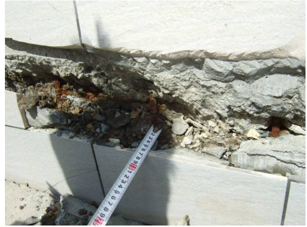
写真 3-18-6-2 縦筋位置の計測
