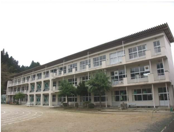
写真 3-32-2-3 中里小学校校舎棟
