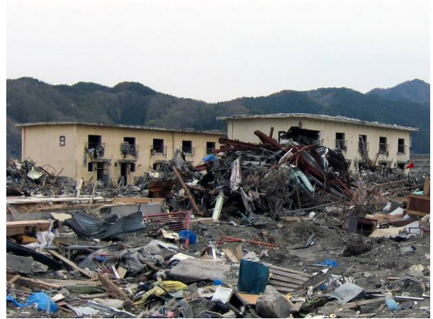
写真 3-12-3-6 残存住宅 (右: 8号棟, 左: 9号棟)
