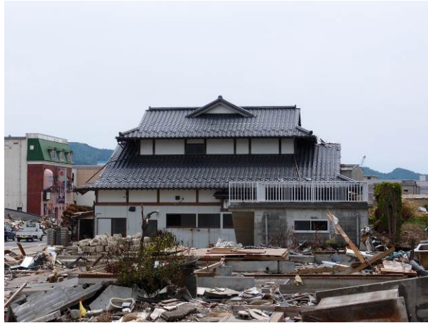
写真 3-14-15-1 建物正面の様子
