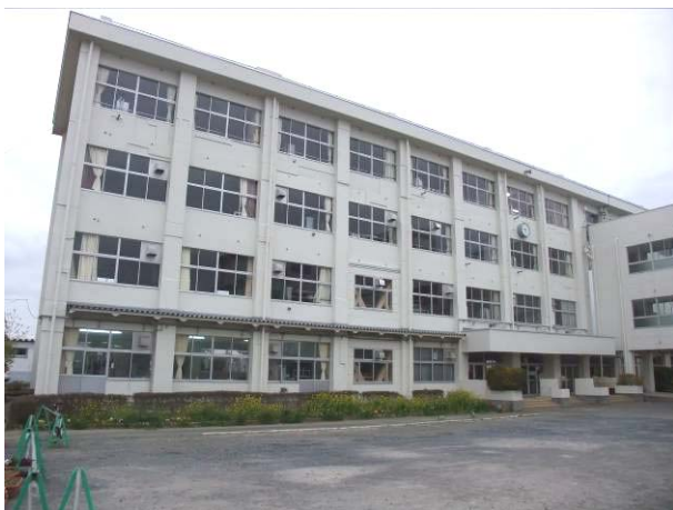
写真 3-33-2-1 南光台中学校教室棟
