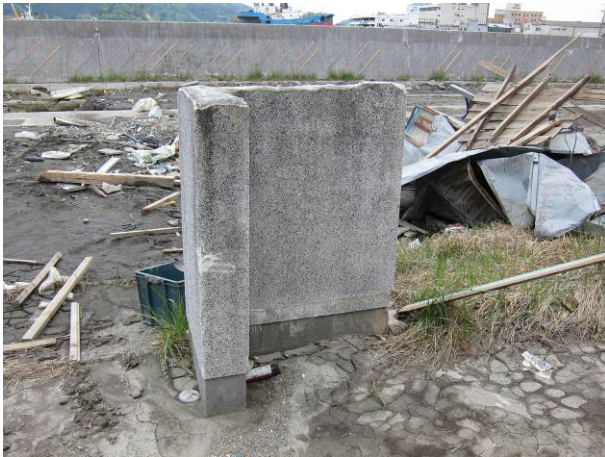
写真 3-14-19-1 転倒していない塀
