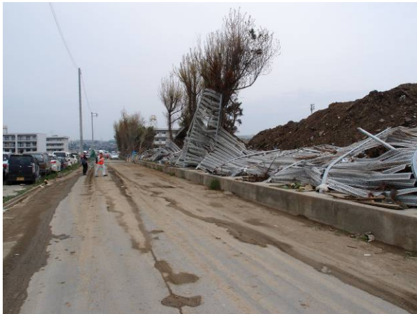
写真 3-19-3-1 転倒したフェンス
