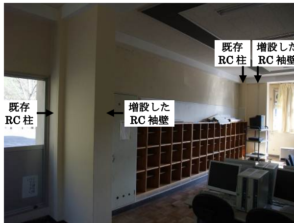
写真 3-13-22-5 RC 袖壁増設
