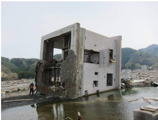
写真 3-12-2-1 転倒した RC 住宅（北面）
