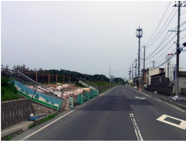
写真 3-24-1-3 CB 塀直前の河川堤防が決壊
