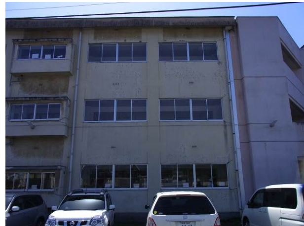
写真 3-13-19-4 柱と壁の間にスリットの施工の様子
