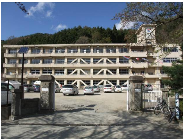
写真 3-13-22-1 建物全景と耐震補強の様子
