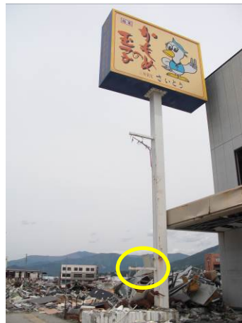
写真 3-14-12-1 看板鉄骨支持部材の様子
