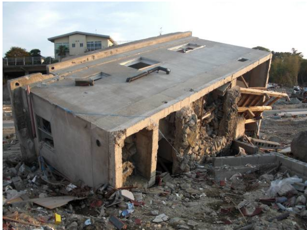
写真 3-31-3-1 平屋住宅の受圧面
