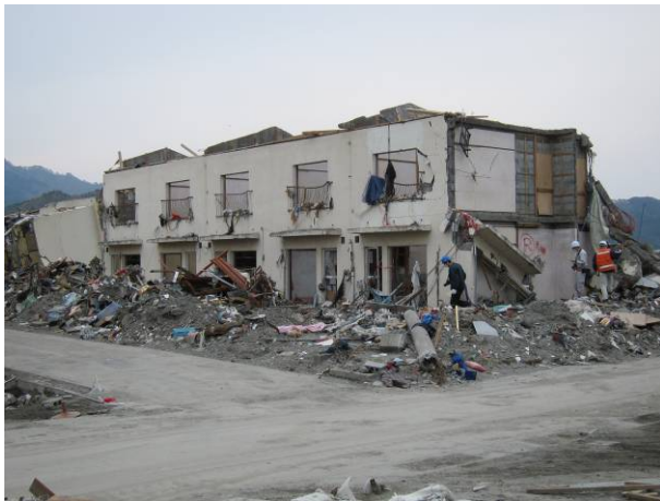
写真 3-12-3-1 残存住宅 (1号棟)
