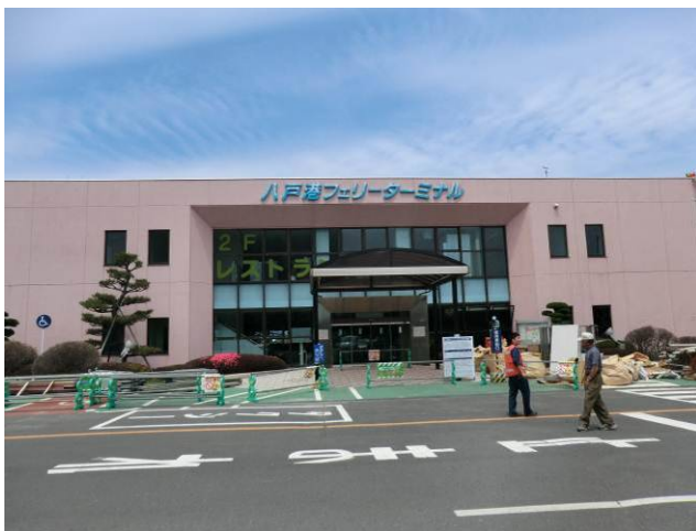
写真 3-2-1-1 八戸港フェリーターミナル南面
