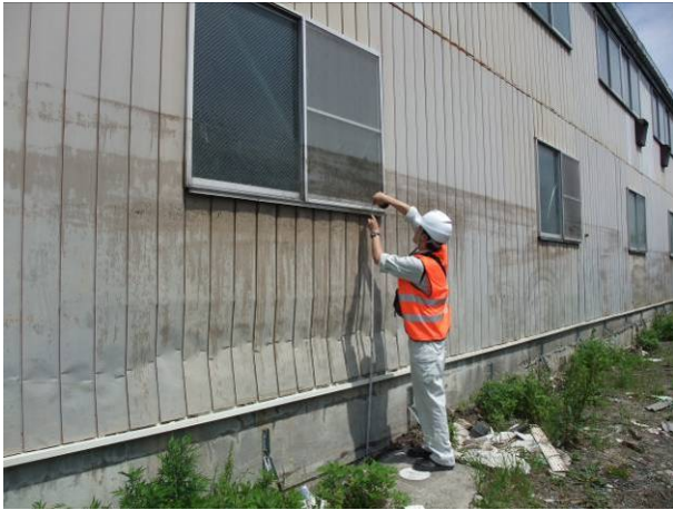
写真 3-22-2-3 浸水深の計測
