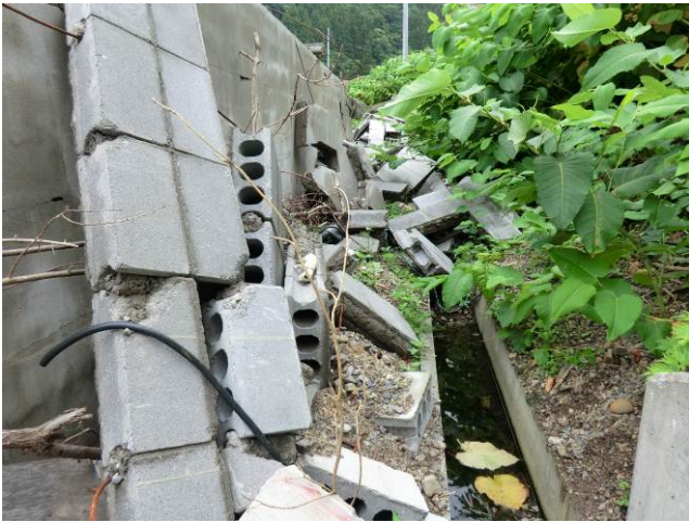
写真 3-6-1-3 CB 造倉庫裏側
