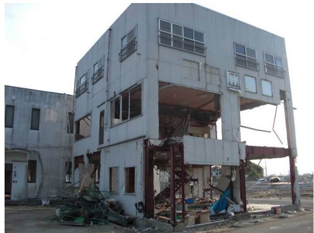
写真 3-31-5-2 MH 旅館の東面
