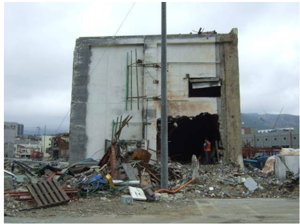
写真 3-18-1-4 冷凍倉庫南面
