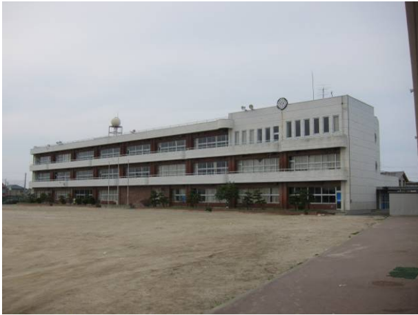
写真 3-29-9-1 亙理町立荒浜小学校の校舎
