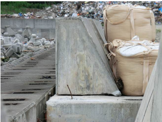
写真 3-3-6-1 転倒していない堤防
