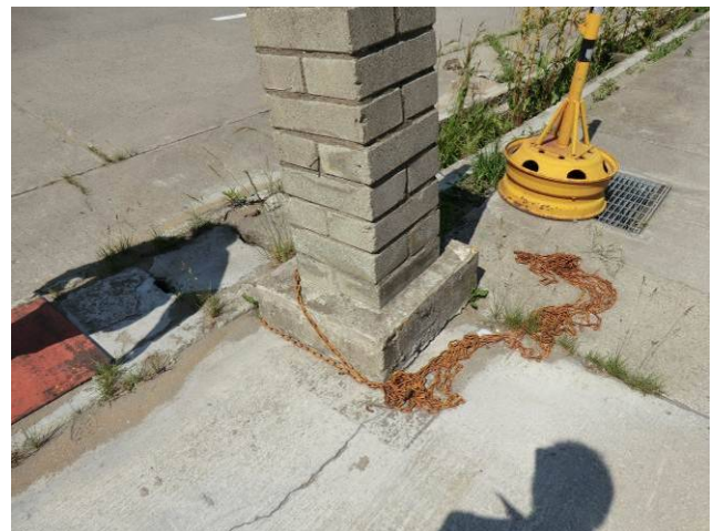
写真 3-2-6-2 CB 門柱移動の痕跡
