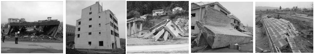
層崩壊した建築物 (陸前高田市, RC造平屋) 残存する建築物 (女川町, RC造4階) 崩壊した鉄道橋 (田野畑村, RC造) 崩壊・転倒した防潮堤 (山田町, RC造) 崩壊したブロック塀 (亘理町, CB造)
