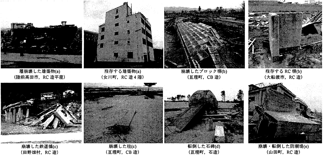
写真1 被害事例 (a)~(e)は2.3節の構造物の分類記号を表す
