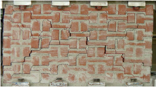
(a) レンガ造試験体
