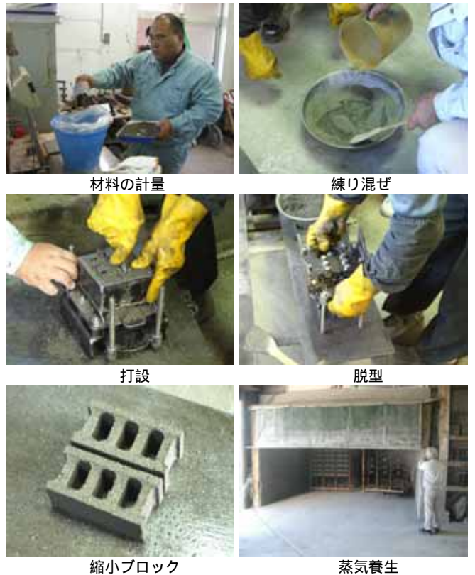
図6 縮小ブロックの製作工程（国内Y社工場にて）
